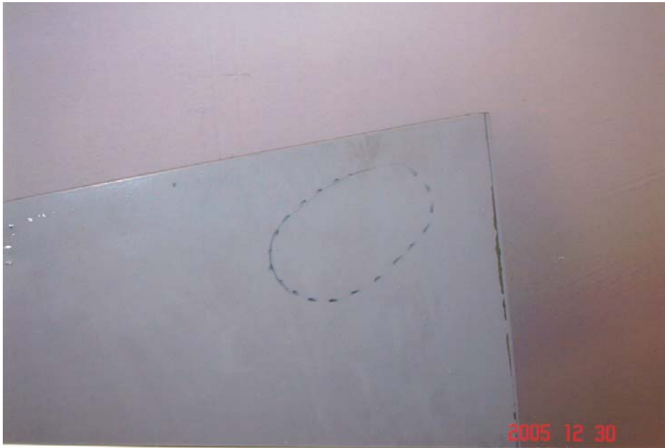
Şekil 7.44 Kaba hatlarıyla hata tespit edilen bölgenin işaretlenmesi
