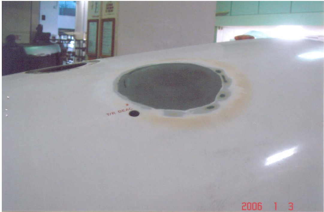
Şekil 7.95 Bu işlemlerden sonra tamir edilen bölümün tahribatsız muayeneleri yapılarak zımparalanmış, boyanmış ve parça servise verilmiştir
