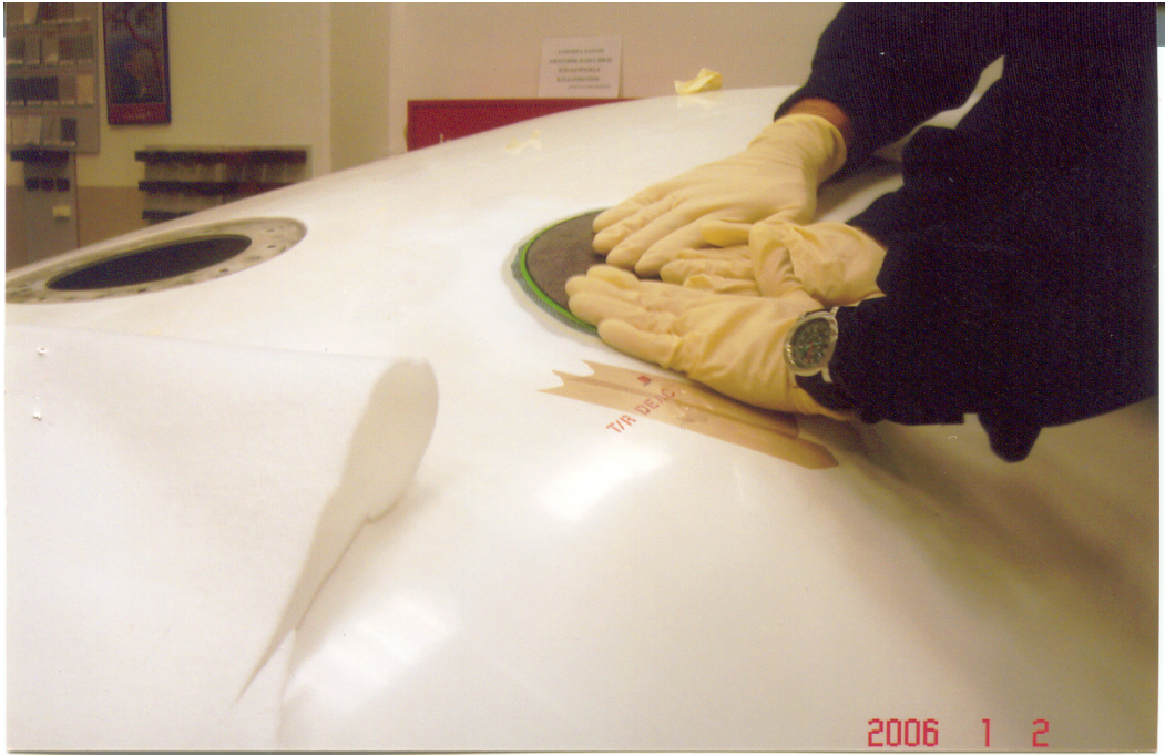
Şekil 7.91 Karbon tabakaları, yapışkan film tabakalarıyla beraber uygulanmıştır
