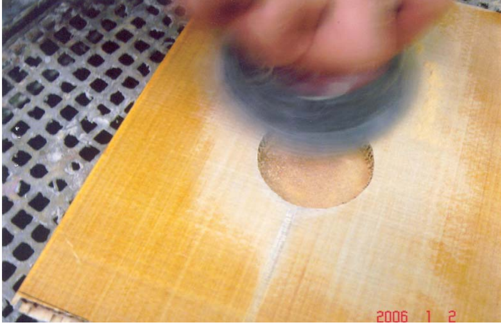
Şekil 7.75 Bölge tamamen zıpara makinasıyla temizlenerek, gerekli olan yüzey düzgünlüğü sağlandı. Etraftaki boya ve parlaticılar çıkarıldı
