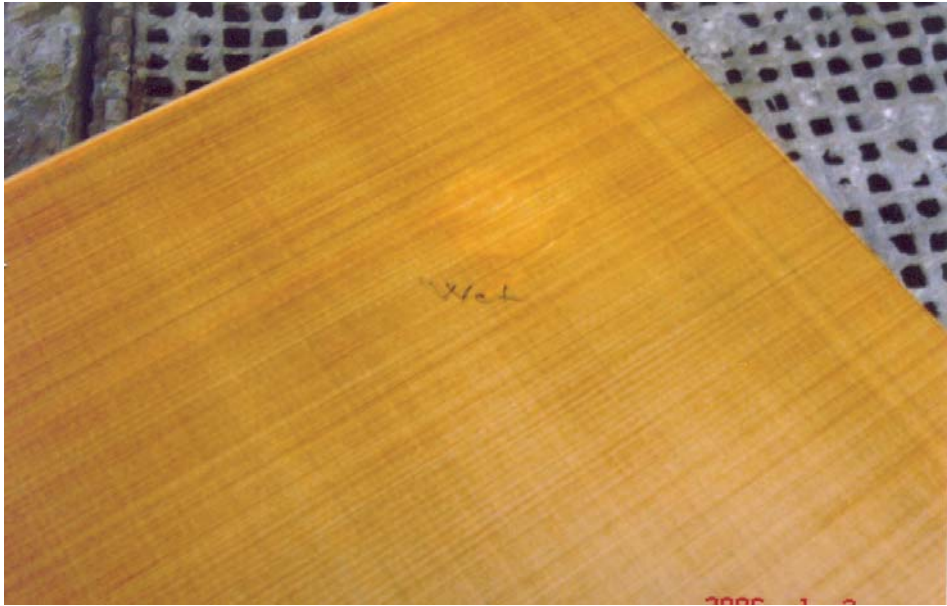
Şekil 7.54 Hasarlandırılarak ıslak serme tamirinin uygulanacağı bölge
