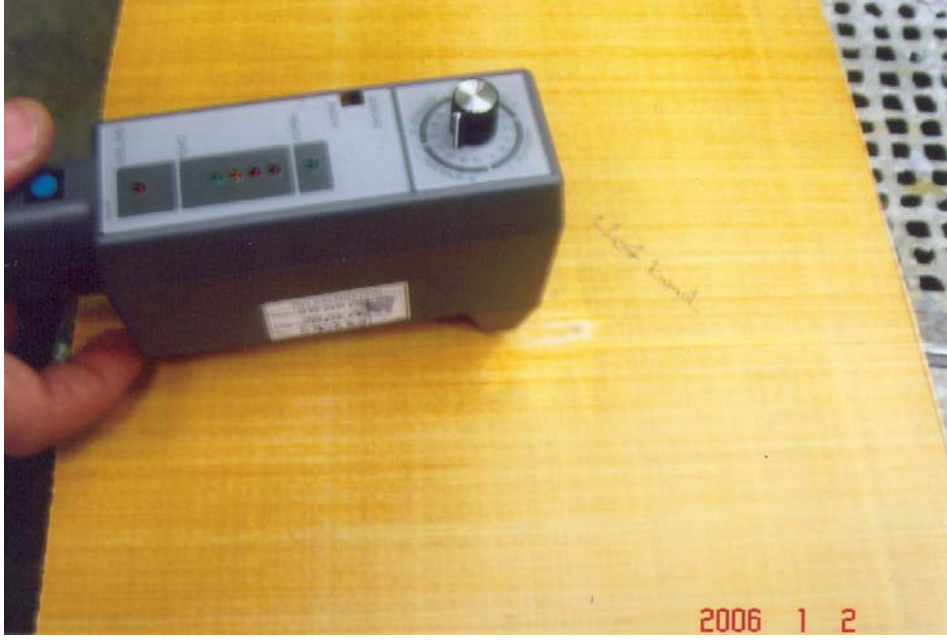
Şekil 7.37 Tap cihazının hasarlı bölgeye uygulanması
