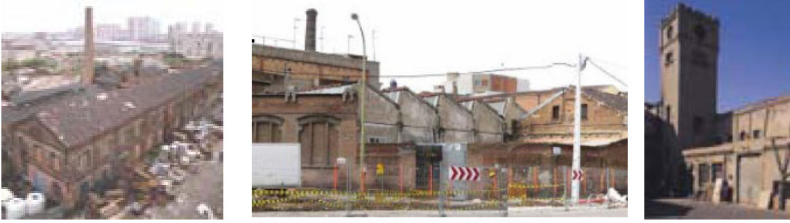
Şekil 2.10 Barcelona Poblenou endüstri kentindeki sanayi yapıları
