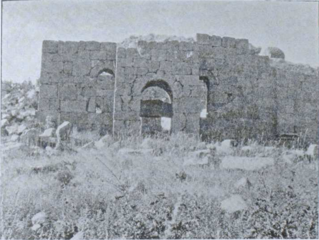
Resim 3.43 Kara Kilise güney görünüşü (Restle, 1978)
