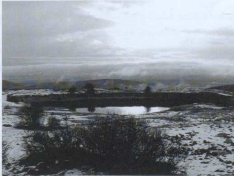
Resim 4.5 Buzluk Kilise yapı taşlarıyla oluşturulmuş su toplama havuzu
