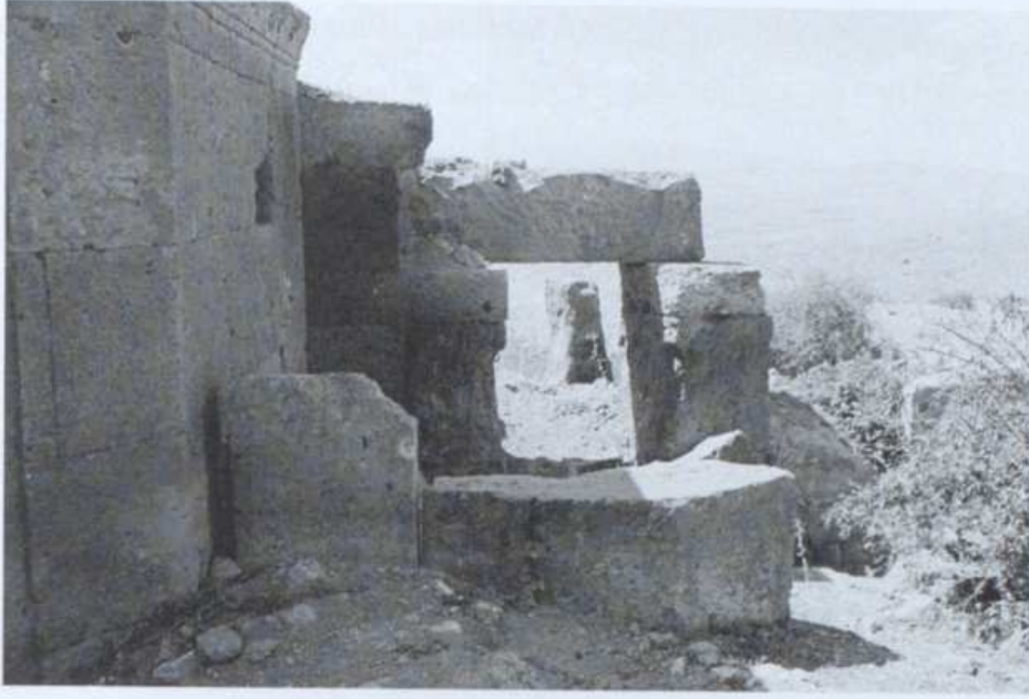
Resim 3.73 Panagia Buzluk Kilisesi kuzey haç kolu doğu duvarı
