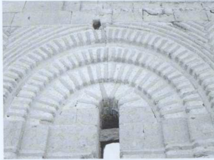
Resim 3.143 Çanlı Kilise'de tuğla / derz oranı
