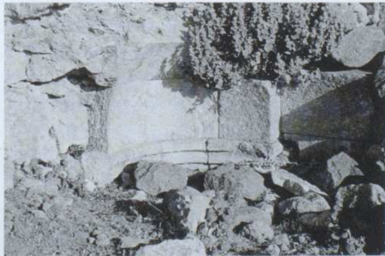
Resim 3.106 Süt Kilise, Kuzey Kilise parekklesion apsisi (Restle, 1978)
