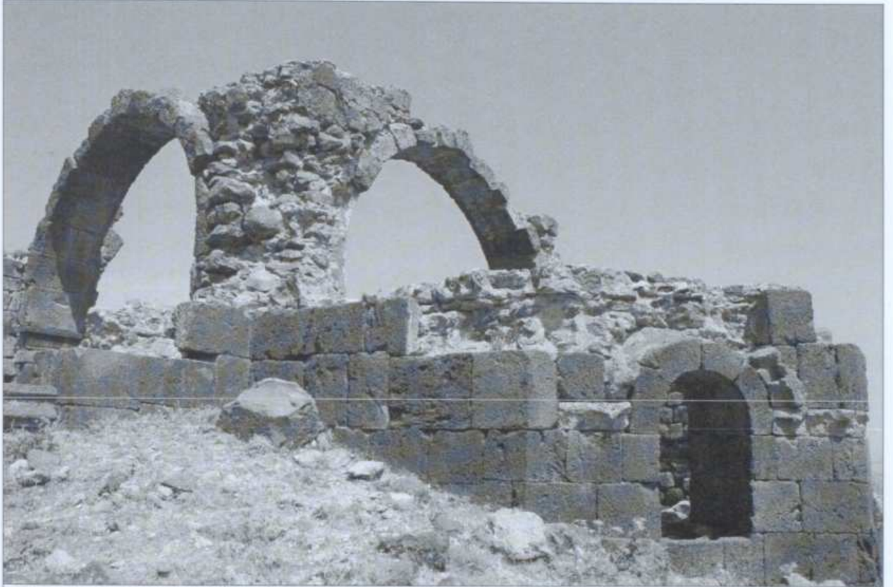
Viranşehir No.1 / Kemer Kilise güneydoğu görünüşü
