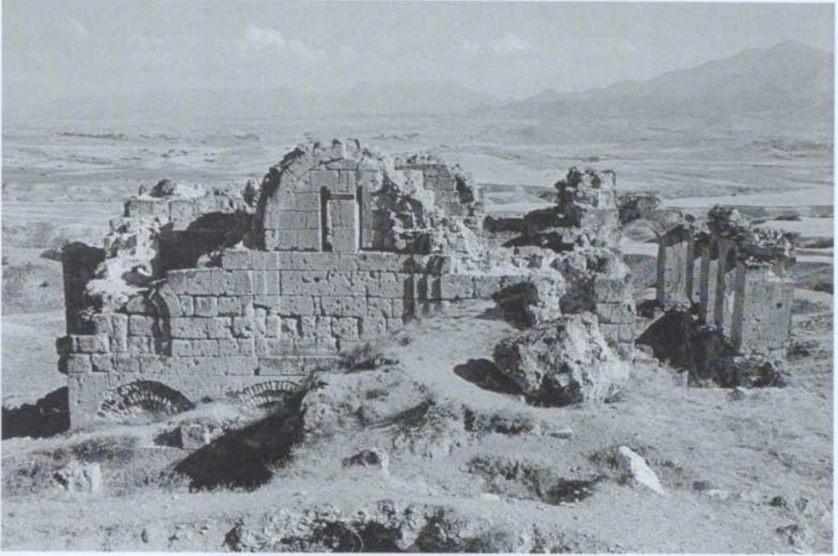
Resim 3.120 Çanlı Kilise, kuzey cephesi
