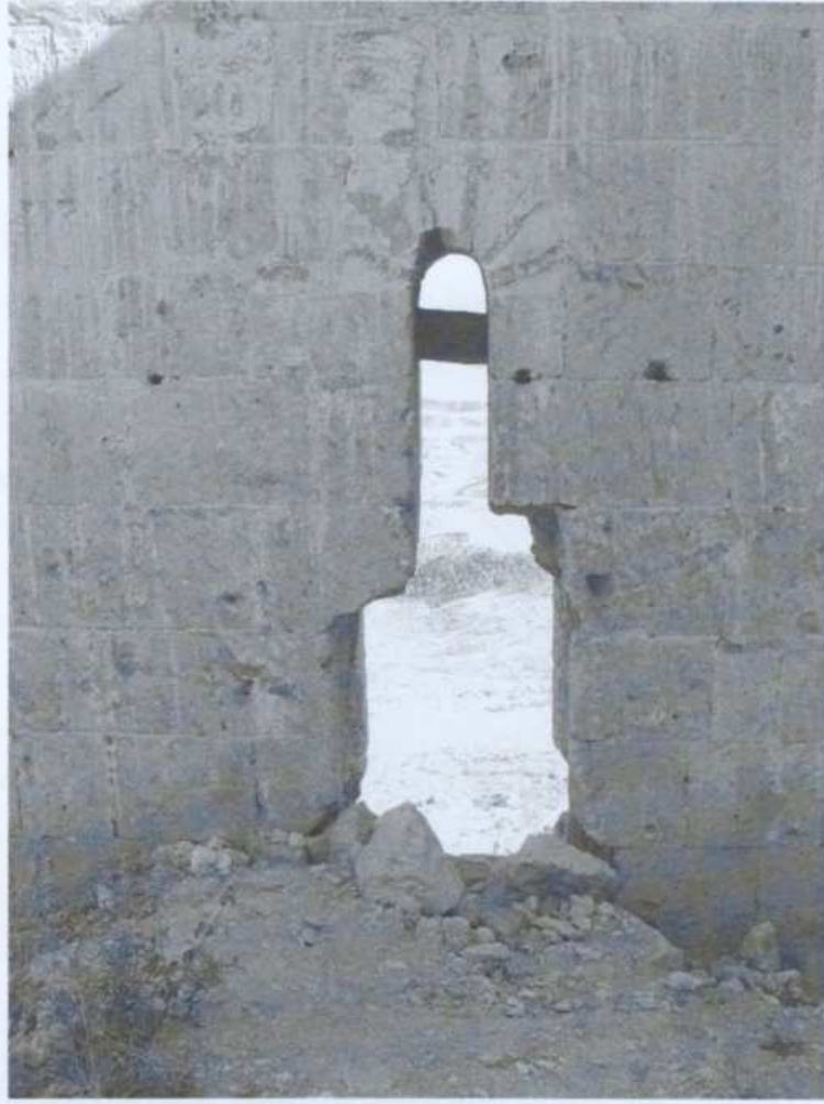
Resim 3.153 Çanlı Kilise, ahşap hatıl
