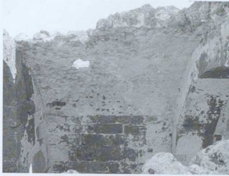
Resim 3.58 Kızıl Kilise, tonozlarda kullanılan “kavurma” yöntemi
