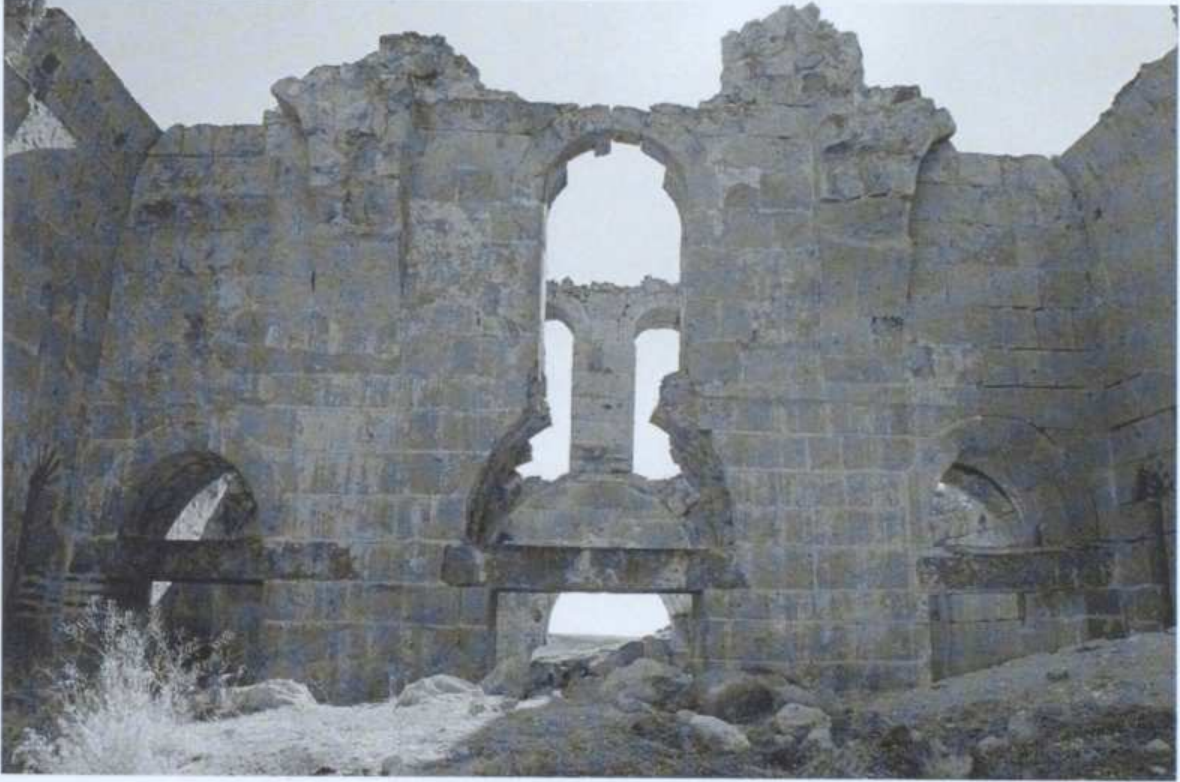
Resim 3.118 Çanlı Kilise, naos batı duvarı
