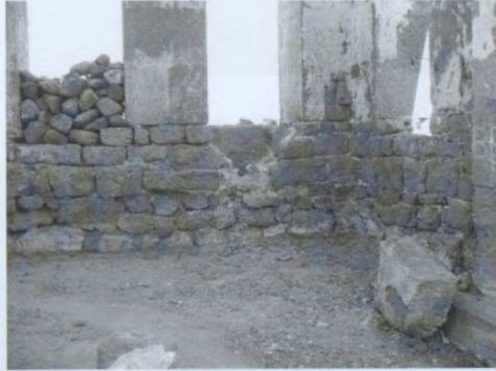
Resim 32. Batı haç kolu güney duvarı
