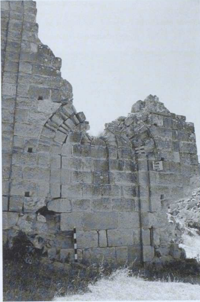
Resim 3.134 Hagios Hermolaos Kilisesi kuzeybatı köşe mekânı kuzey cephesi
