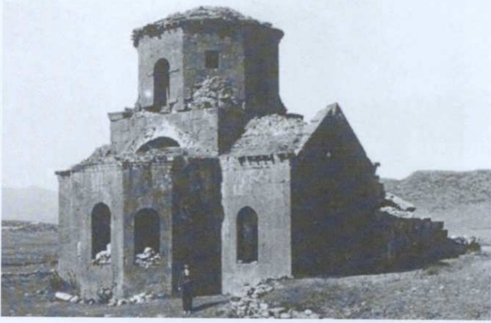
Resim 3.65 Kızıl Kilise, kuzeydoğu cephesi (Bell, 1909)
