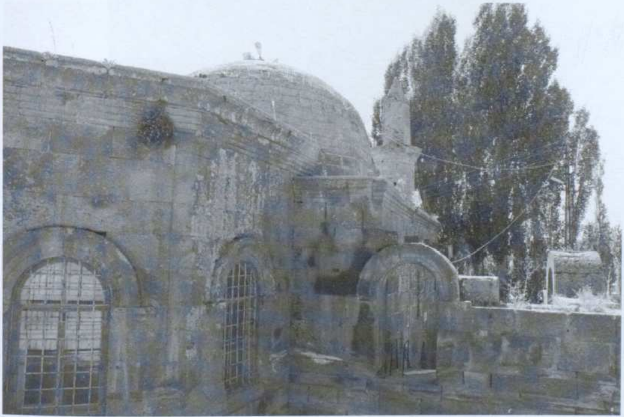
Resim 3.44 Çardakköy Kilisesi kuzeybatı görünüşü
