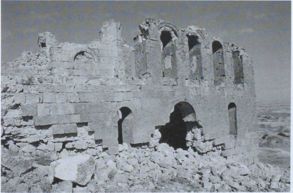
Resim 3.111 Çanlı Kilise, narteksin batı cephesi
