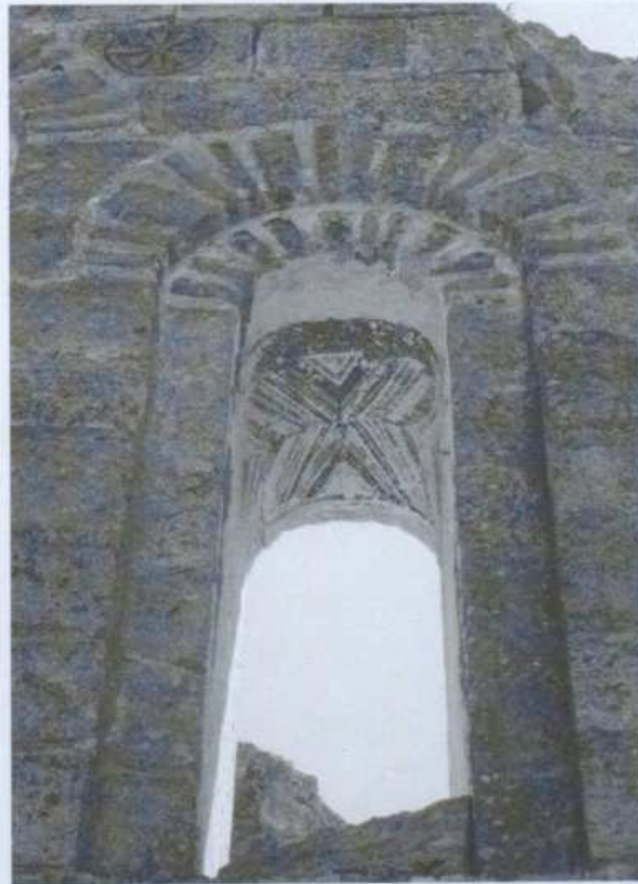
Resim 3.142 Karagedik Kilise, tuğla kullanımı
