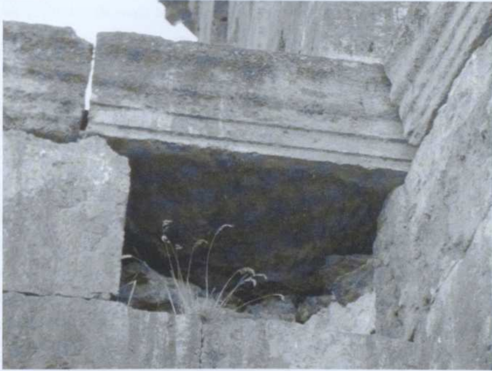
Resim 5.2 Kızıl Kilise’de düşmüş kaplama taşı
