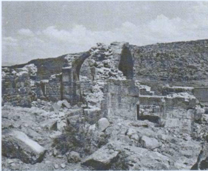
Resim 3.97 Kemer Kilise güneybatı görünüşü (Restle, 1978)
