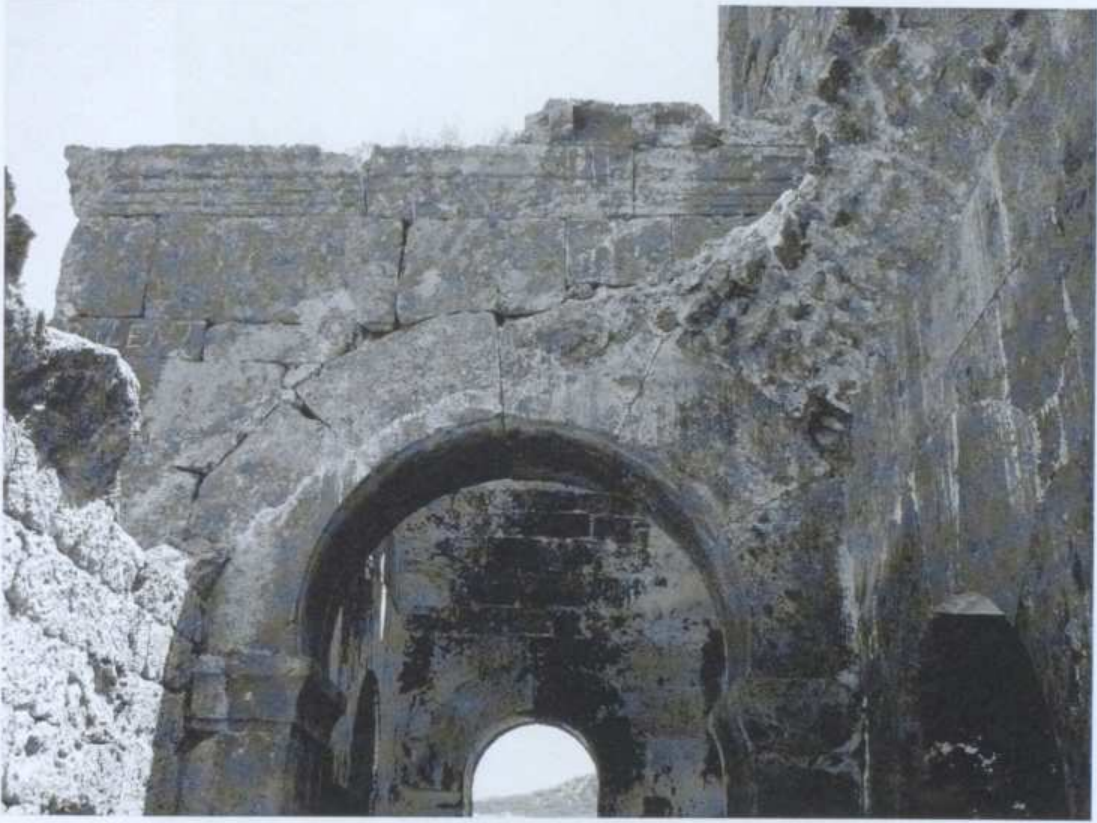
Resim 3.57 Kızıl Kilise, Parekklesion tonoz izi
