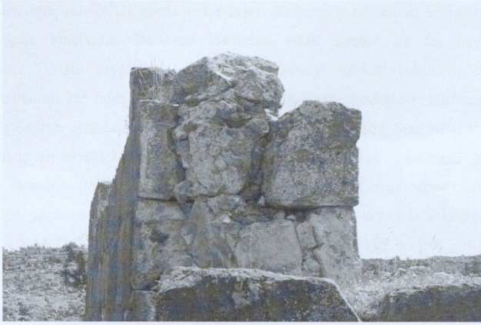
Resim 6.1 Viranşehir I.nolu Kilise, sandık duvar tekniği
