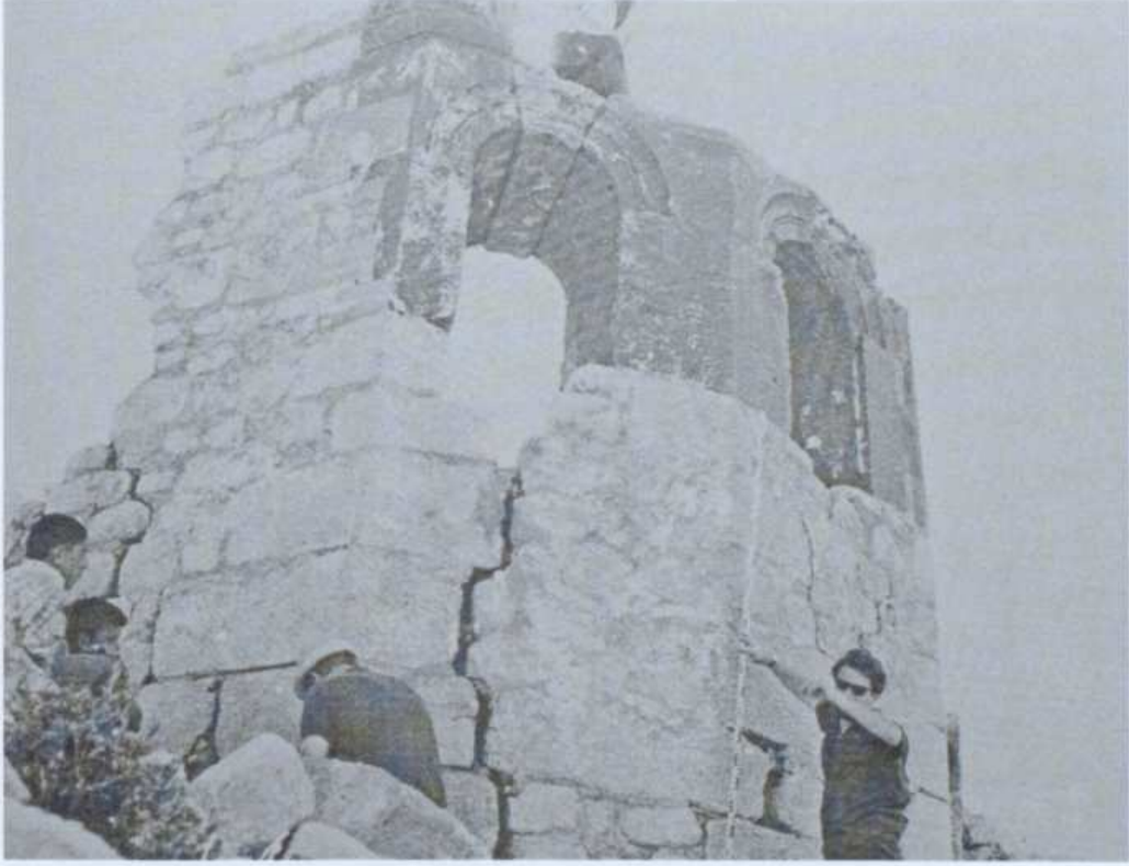
Resim 3.9 Satı Manastır Kilisesi apsisinin güneydoğudan görünüşü (Restle, 1978)
