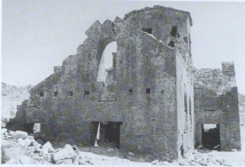
Resim 3.63 Kızıl Kilise, batı cephesi
