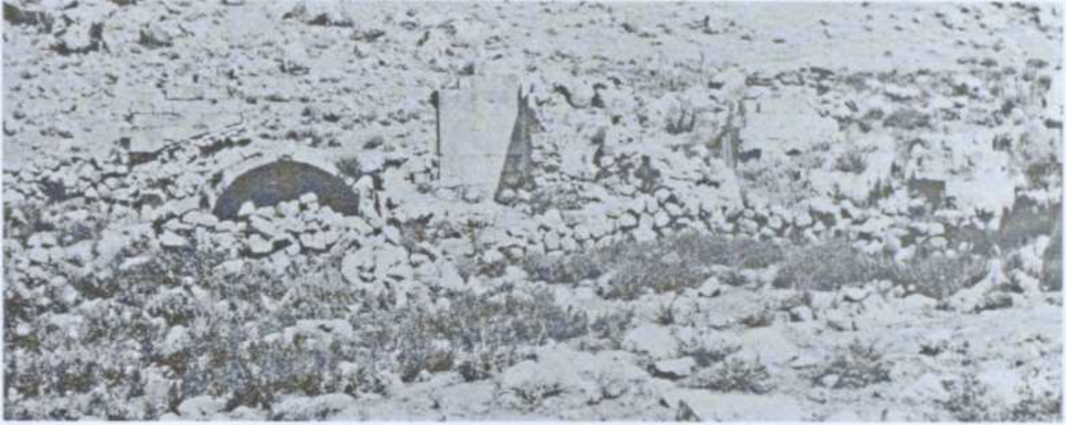
Resim 3.105 Süt Kilise, batıdan görünüş (Restle, 1978)
