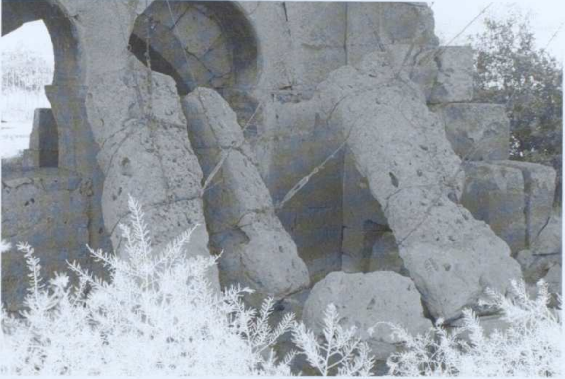
Resim 3.29 Konstantinos Kilisesi kuzey cephedeki taş destek bloklar
