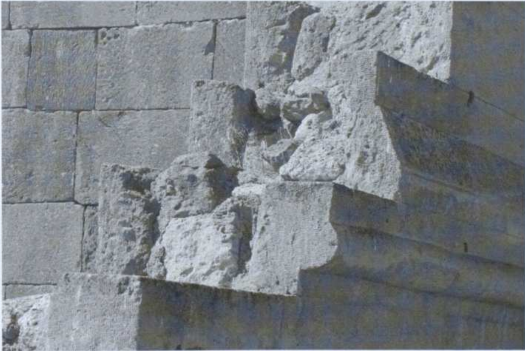
Resim 3.149 Çardak Kilisesi duvar sistemi
