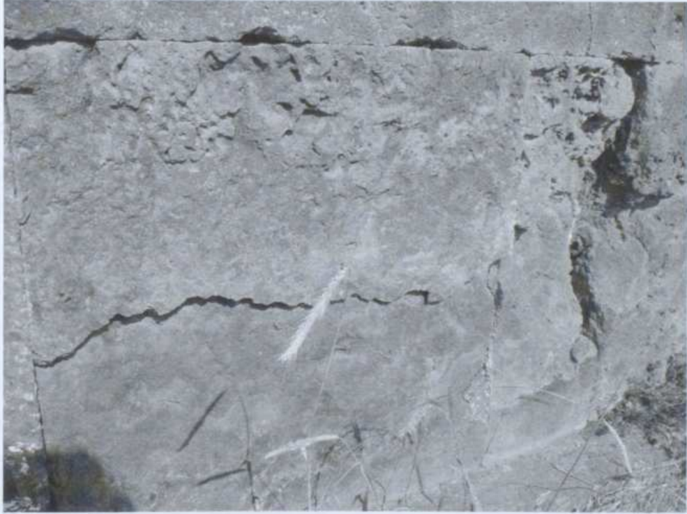
Resim 4.1 Kızıl Kilise, taşın tabakalar halinde kopması
