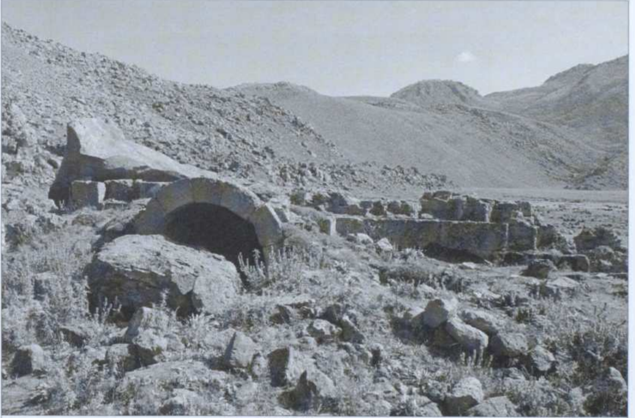
Sarigöl Kilisesi kuzeybatı görünüşü
