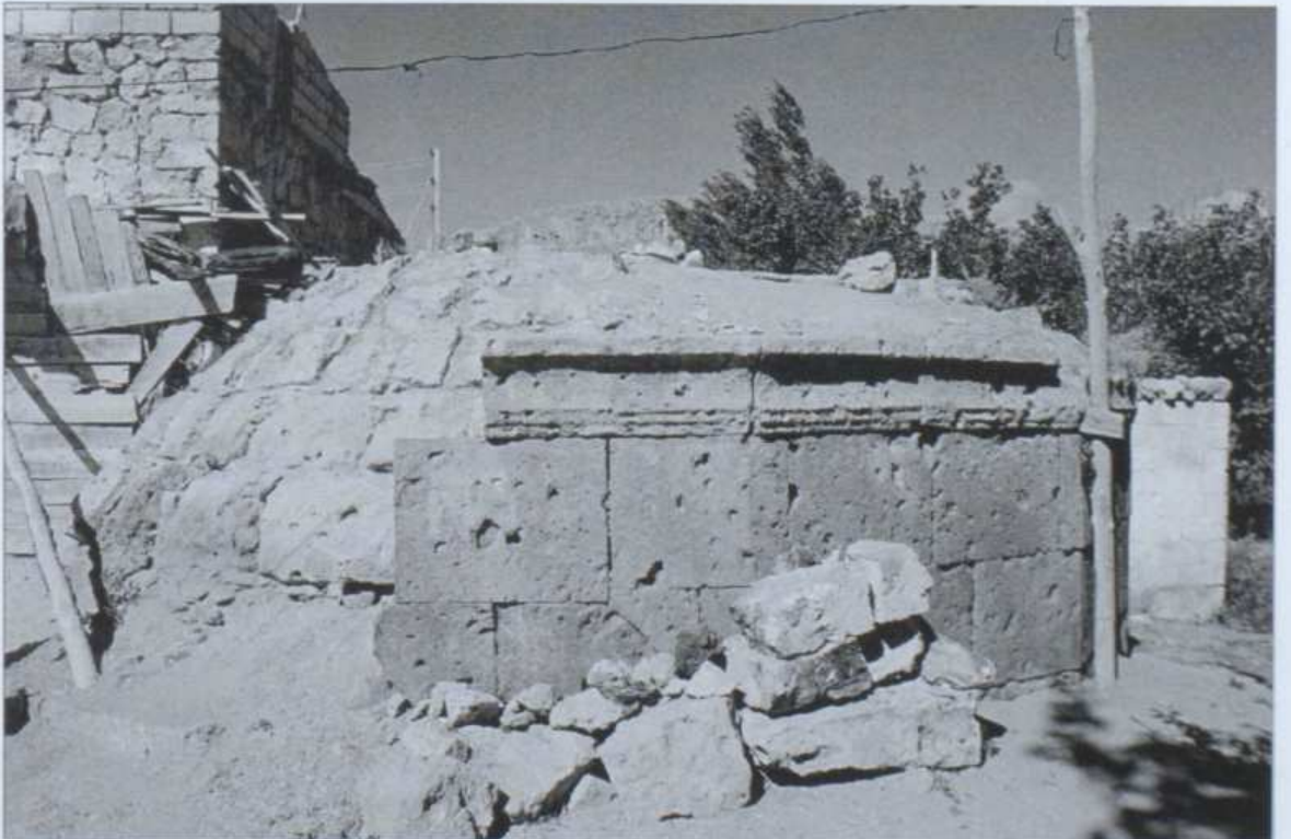
Başköy Kilisesi doğu görünüşü
