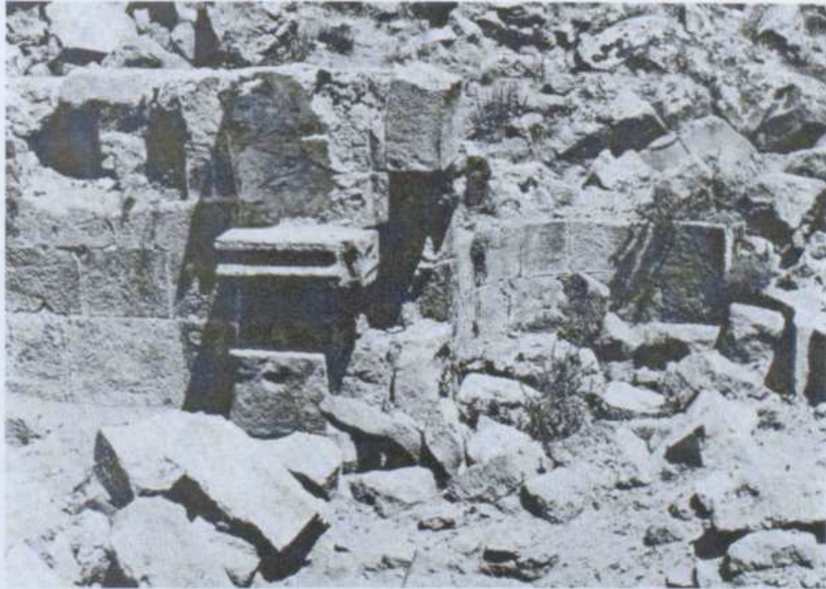
Resim 3.23 Çavdarlık Kilisesi apsis, parekklesion ve arkad kalıntıları (Restle, 1978)
