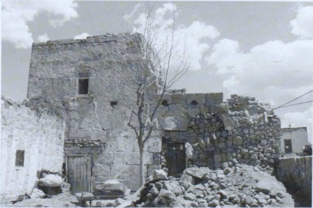
Resim 3.88 Çukurkent Kilisesi batı görünüşü
