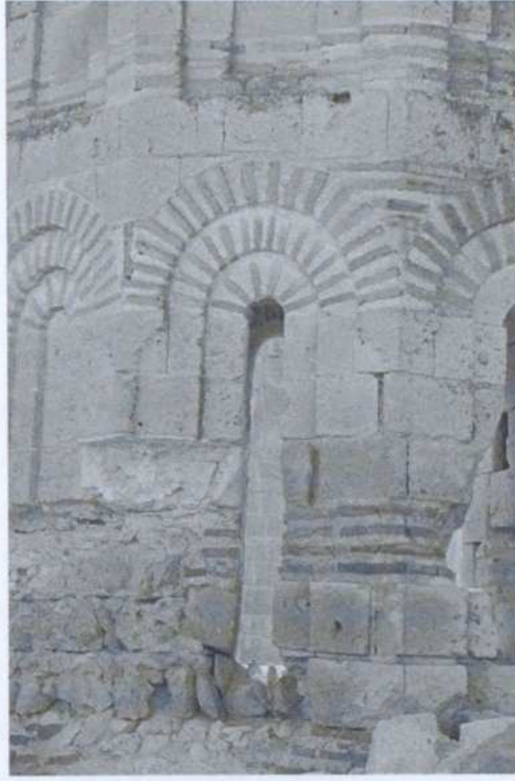
Resim 3.141 Çanlı Kilise, tuğla kullanımı
