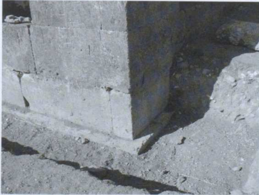
Resim 18. Kuzey haç kolu kuzeydoğu köşesi
