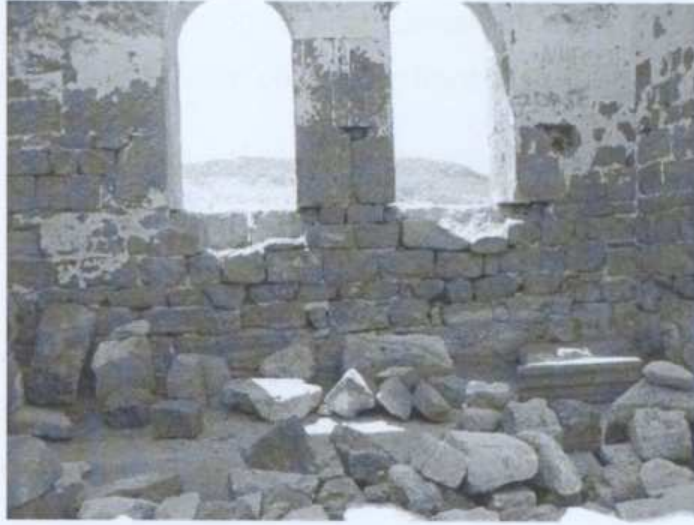
Resim 33.Moloz taşlar kaldırıldıktan sonra batı haç kolu güney duvarı pencereleri
