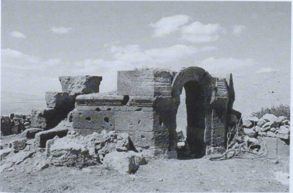
Resim 3.72 Panagia Buzluk Kilisesi apsisinin güneybatı görünüşü
