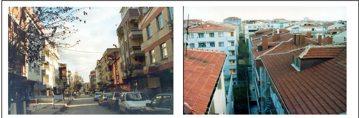
Şekil Ek 5.13 Sokak içi genel görünüm ve ada içi boşluklara genel bakış
