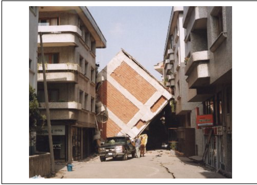
Şekil 2.4 1999 Marmara depremi, bina hasarı nedeniyle yerleşim alanı yol blokajı (Çiftçi, 2002)
