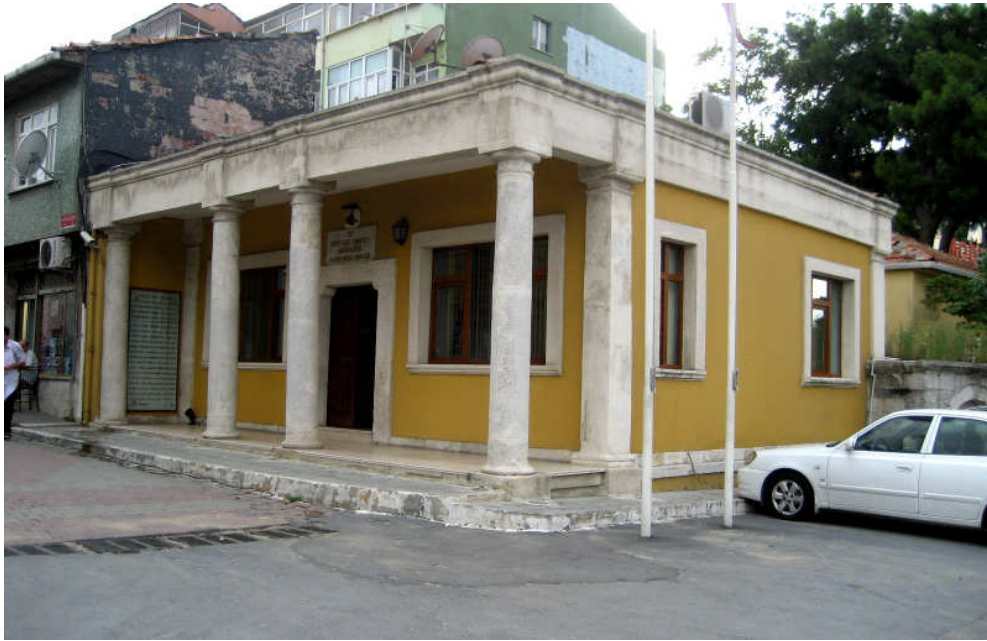
Şekil 3.92 Otakçılar Karakolu, II. Mahmud döneminden günümüze ulaşan en eski karakol yapısı (2010)
