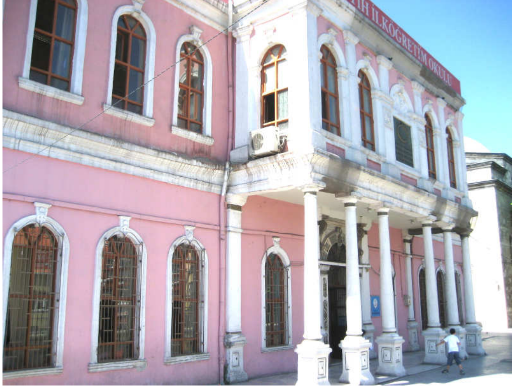
Şekil 3.214 Fatih Askeri Rüşdiyesi güney cephesi (27 Mayıs 2009)
