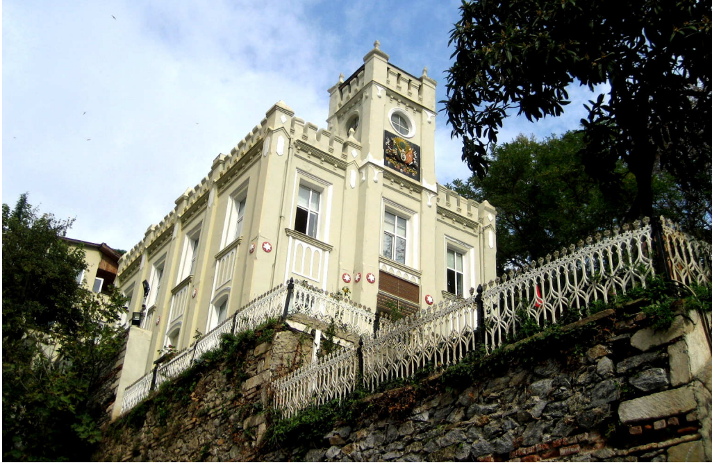
Şekil 3.280 Pazarbaşı Karakolu Karakütük Caddesi'nden güney ve doğu cephesi (26 Ekim 2010)
