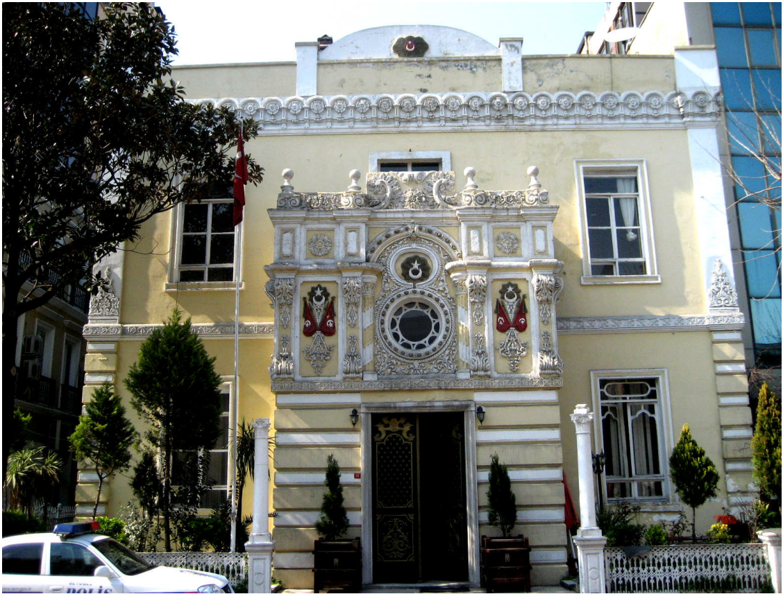
Şekil 3.119 Tophane Karakolu doğu cephesi (28 Mart 2009)
