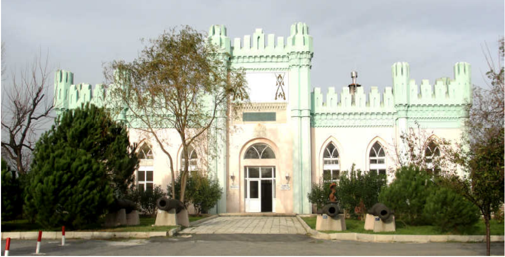
Şekil 3.253 Orhaniye Kışlası silahhane yapısı (1 Aralık 2010)
