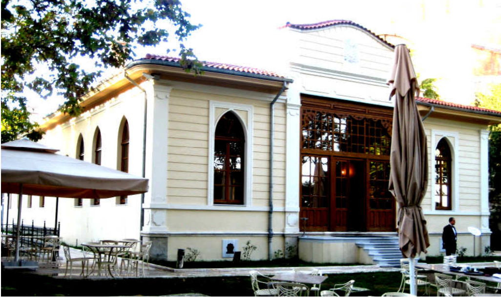
Şekil 3.331 Topkapı Sarayı Dış Karakol Binası doğu ve güney cephesi (20 Ekim 2010)
