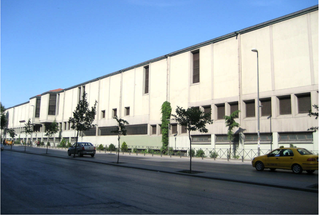
Şekil 3.153 1950'lerin sonunda yıkılan ve 1986'da yenilenen batı cephesi (29 Mayıs 2010)
