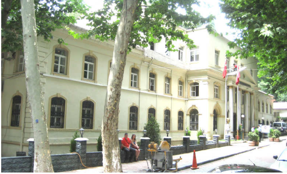
Şekil 3.182 Mecidiye Karakolu doğu cephesi ve muhtes kat (30 Temmuz 2010)
