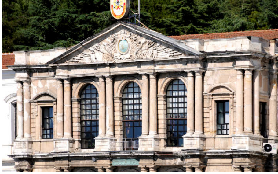
Şekil 3.75 Kuleli Kışlası'nın batı cephesindeki üçgen alınlık
