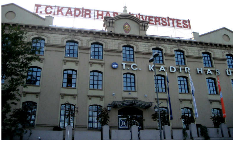
Şekil 3.263 Cibali Tütün ve Sigara Fabrikası'nın Haliç cephesindeki giriş cephesi (20 Ekim 2008)
