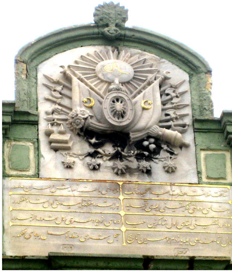
Şekil 3.55 Müftülük (Bab-ı Meşihat) ön cephede bulunan II. Abdülhamid tuğralı arma ve kitabe (27 Şubat 2010)
