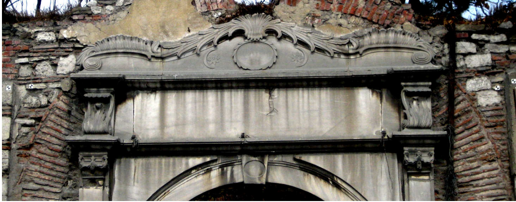
Şekil 3.85 Rami Kışlası güneybatı kanadındaki giriş kapısındaki alınlık(17 Eylül 2008)
