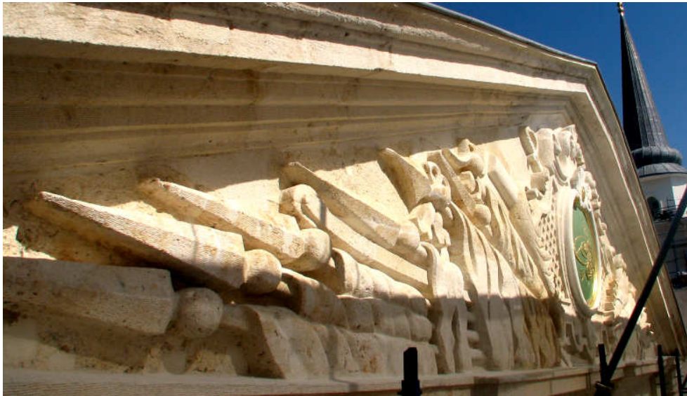
Şekil 3.77 Üçgen alınlığın restorasyon sonrası yan cepheden görünüşü (2010)
