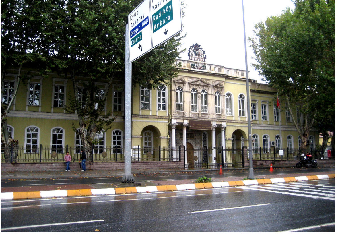
Şekil 3.165 Mühendishane'nin güney cephesi (27 Ekim 2010)
