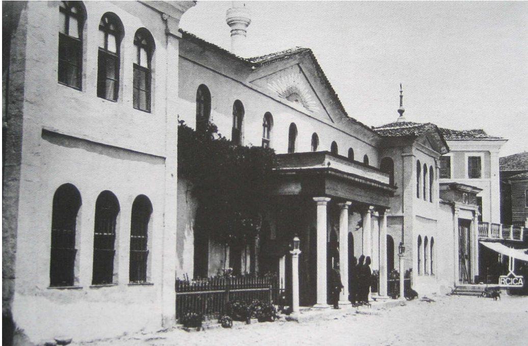
Şekil 3.135 19. yüzyıla ait bir fotoğrafta Arnavutköy Karakolu'nun güneydoğu cephesi ve günümüze ulaşamayan giriş saçığı [65] (Yıldız Albümleri / İRCİCA Arşivi)
