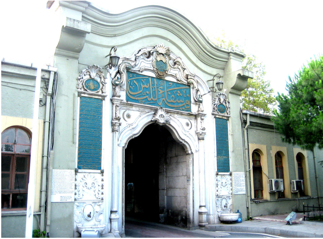
Şekil 3.67 Maltepe Hastanesi Nizamiye Kapısı (2010)
