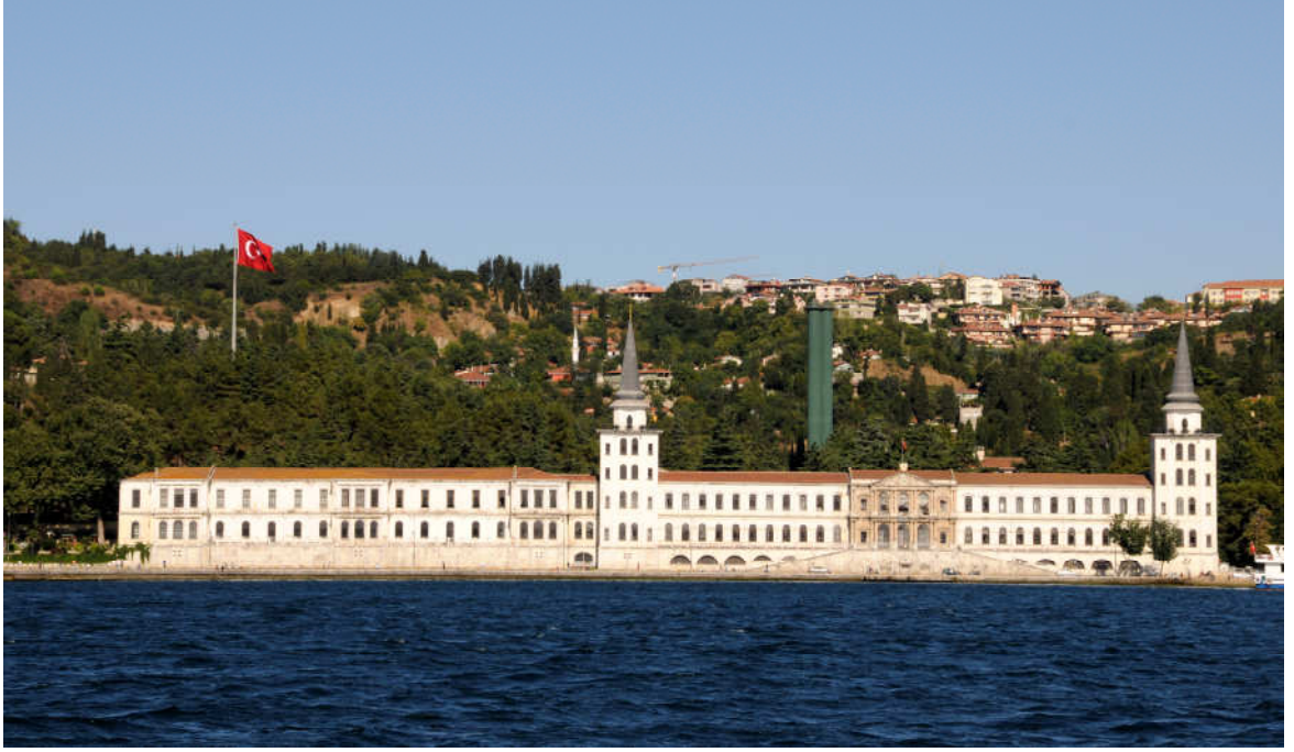
Şekil 3.73 Kuleli Kışlası batı cephesi
