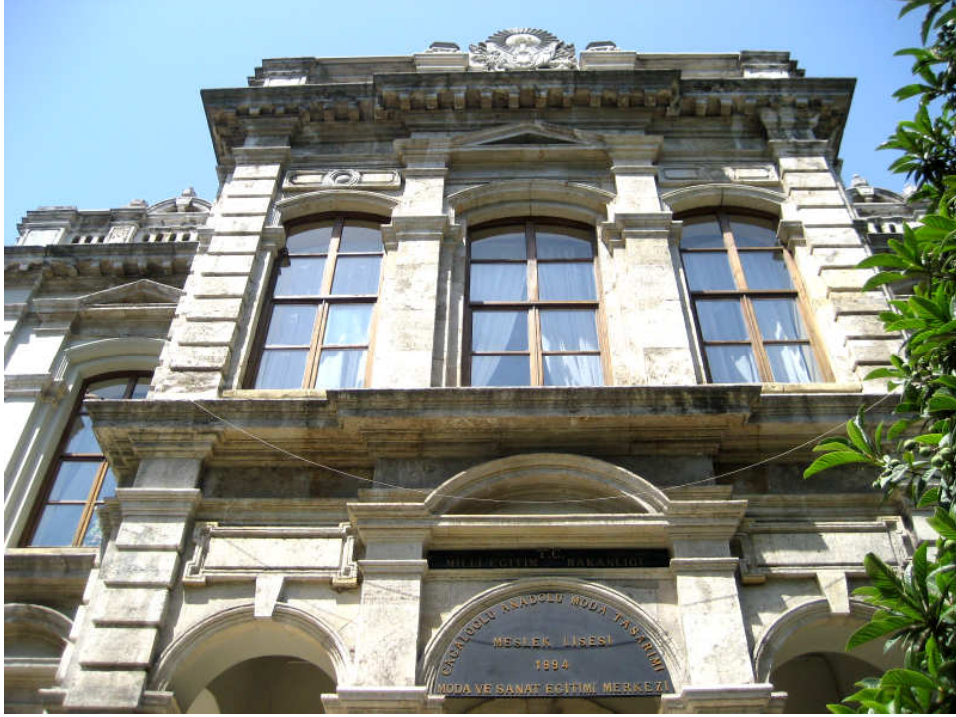
Şekil 3.245 Yapının giriş kısmı (14 Mayıs 2010)
