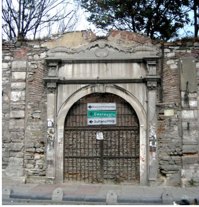
Şekil 3.84 Rami Kışlası güneybatı kanadındaki giriş kapısının günümüzdeki durumu (17 Eylül 2008)
