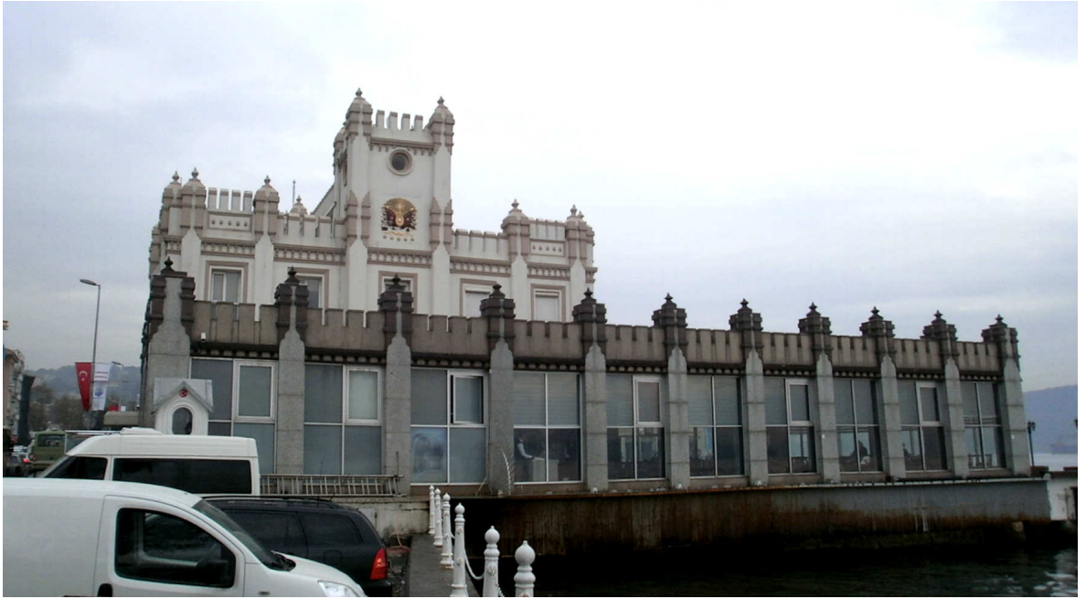
Şekil 3.273 Mesarburnu Karakolu ve güney cephesine yakın tarihte ilave edilen kafeterya (26 Ekim 2010)
