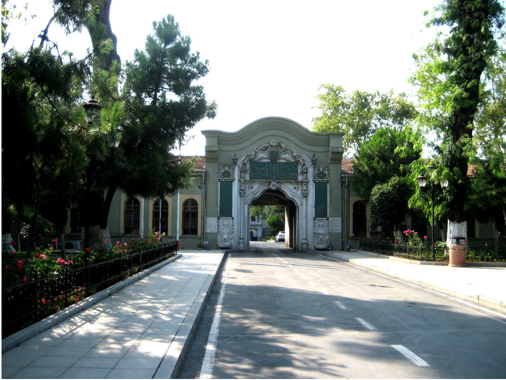
Şekil 3.66 Maltepe Hastanesi güneydoğu cephesinde 1995'te onarım gören ana girişin Nizamiye Kapısı'nın bulunduğu tek katlı kanadın Topkapı- Rami asfaltı yönünden görünüşü (2010)
