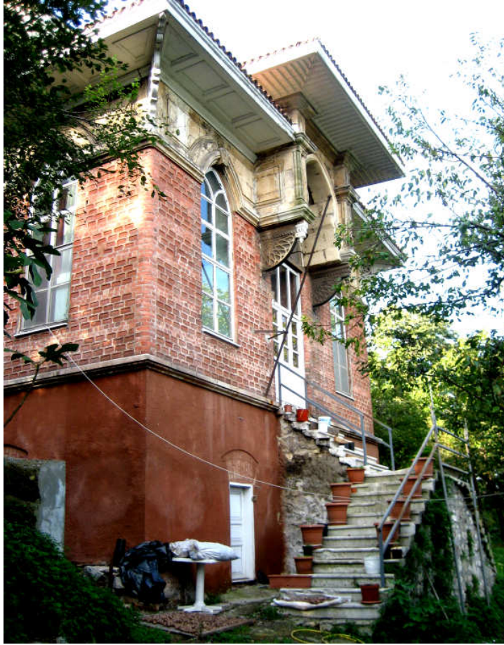
Şekil 3.306 Topkapı Sarayı Karkolu doğu ve güney cephesi (20 Ekim 2010)
