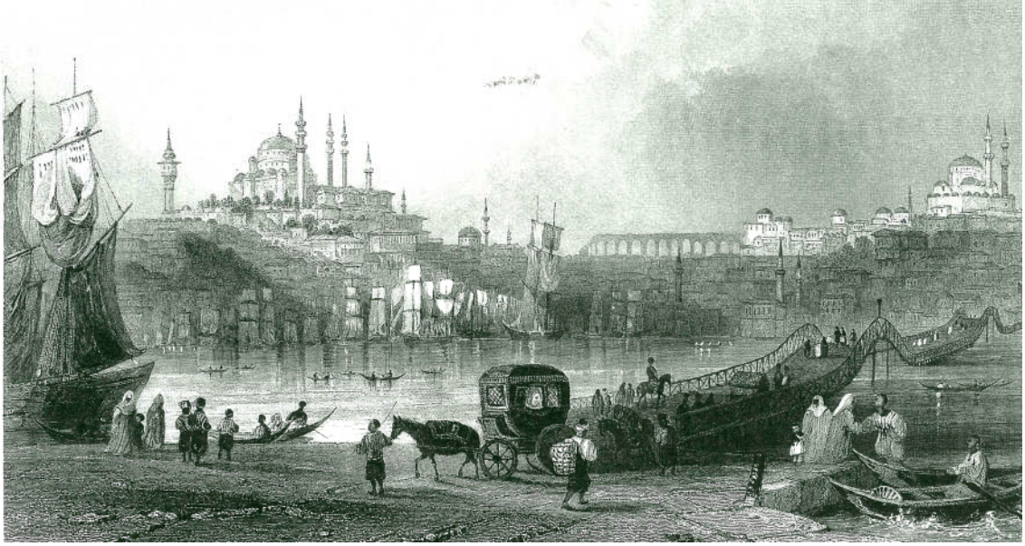
Şekil 3.43 Haliç'e ilk kez inşa edilen "Mahmutiye" veya "Cisr-i Atik" köprüsünün Bartlett tarafından yapılan gravürü [68]
