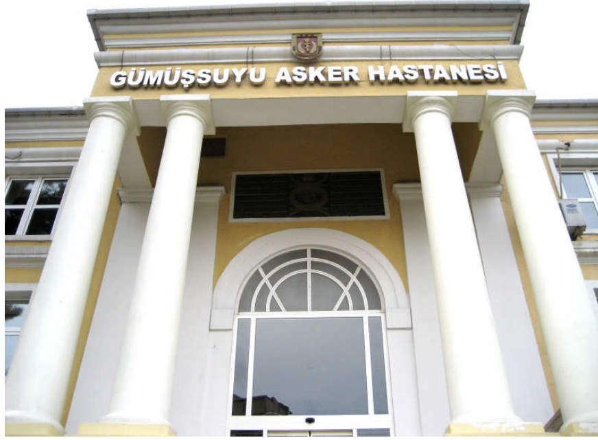
Şekil 3.162 Doğu cephesindeki giriş kapısı (2008)
