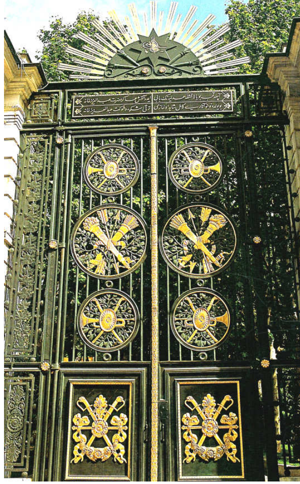
Şekil 3.201 Mekteb-i Sultani İstiklâl Caddesine bakan giriş kapısı (2009)
