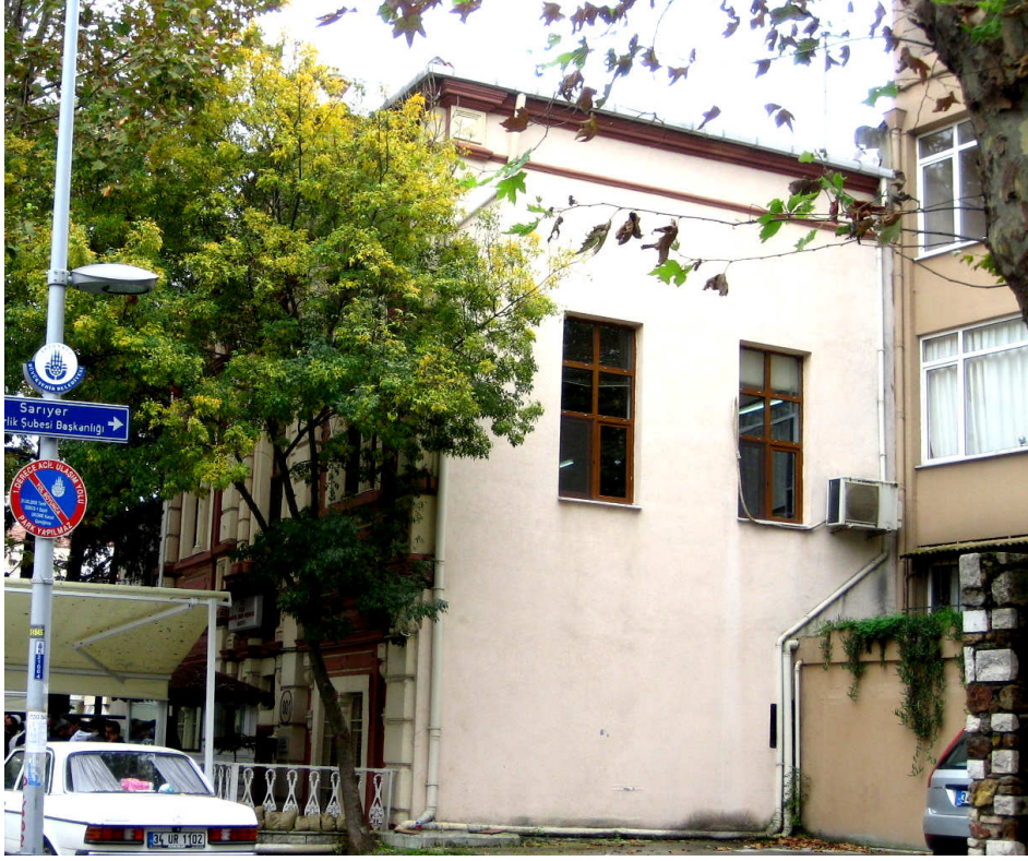
Şekil 3.315 Yeniköy Karakolu batı ve güney cephesi (26 Ekim 2010)
