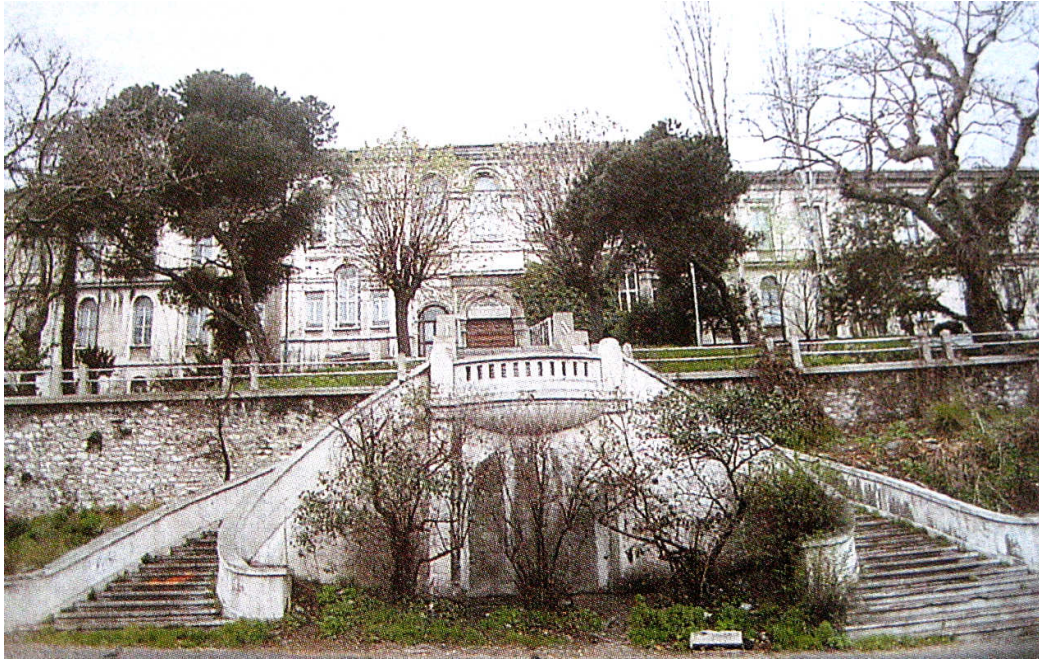
Şekil 3.204 Gümüşsuyu Kışlası'nın deniz cephesinden görünümü [125].
