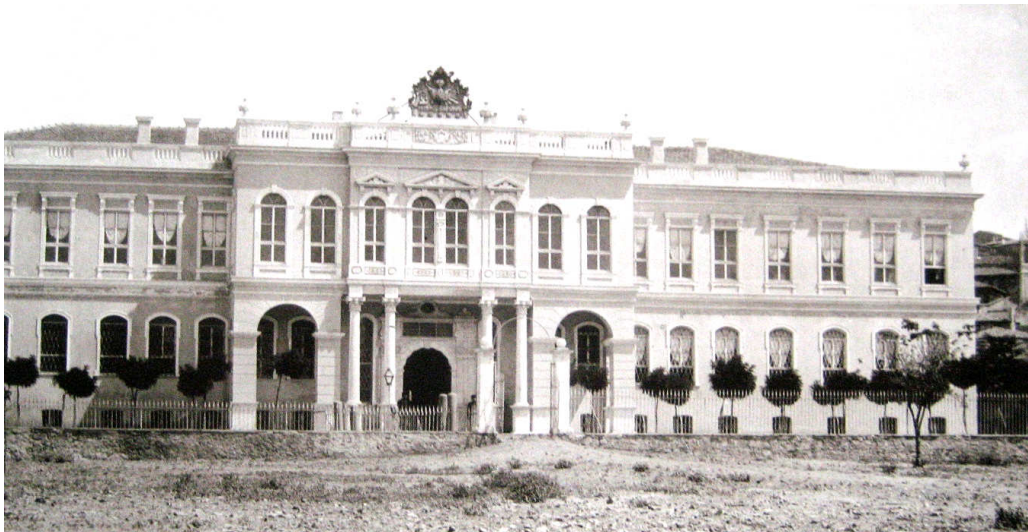
Şekil 3.164 1880–1883 yılları arasında Phébus tarafından çekilen Mühendishane'nin güney cephesi [65 ] (Abdülhamid Koleksiyonu/L.C. F. no: 81905)
