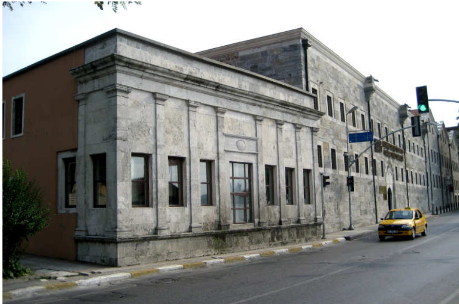
Şekil 3.127 Paşalimanı Karakolu ve hububat ambarının deniz cephesi (2010)
