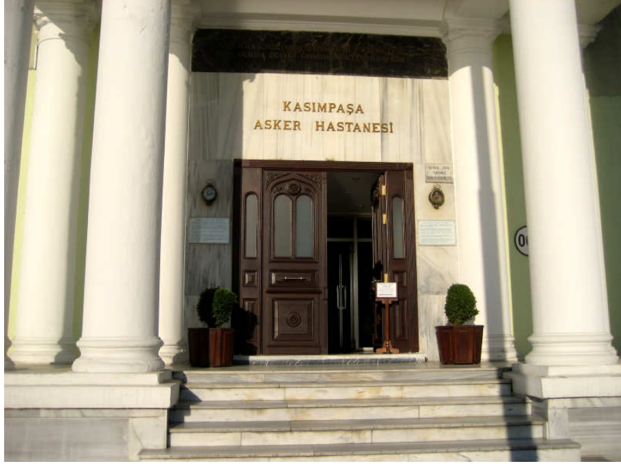
Şekil 3.61 Bahriye Merkez Hastanesi merdivenli ana giriş kapısı (1 Kasım 2010)
