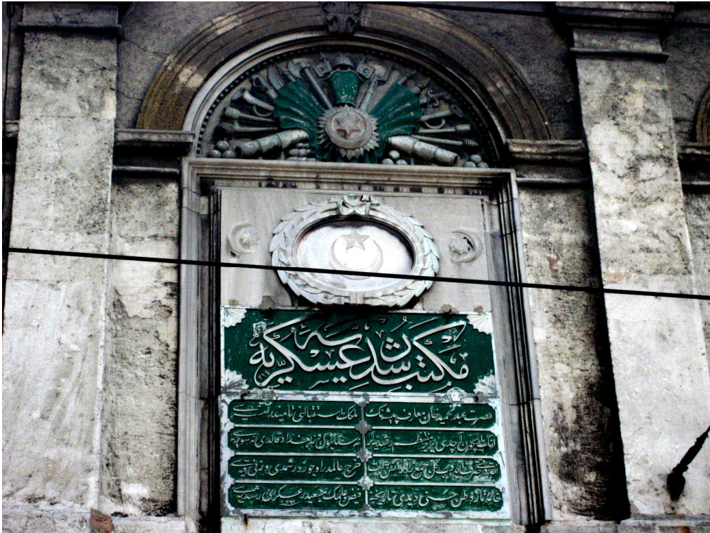
Şekil 3.221 Soğukçeşme Askeri Rüşdiyesi, kuzeydoğu cephesindeki kitabe ve madalyonu (14 Eylül 2008)
