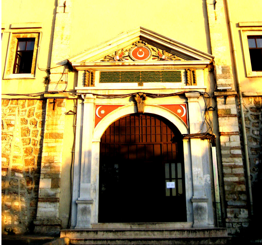
Şekil 3.24 Selimiye Kışlası batı cephesindeki giriş kapısı ve 1258/1842–1843 tarihli kitabe (3 Kasım 2010)
