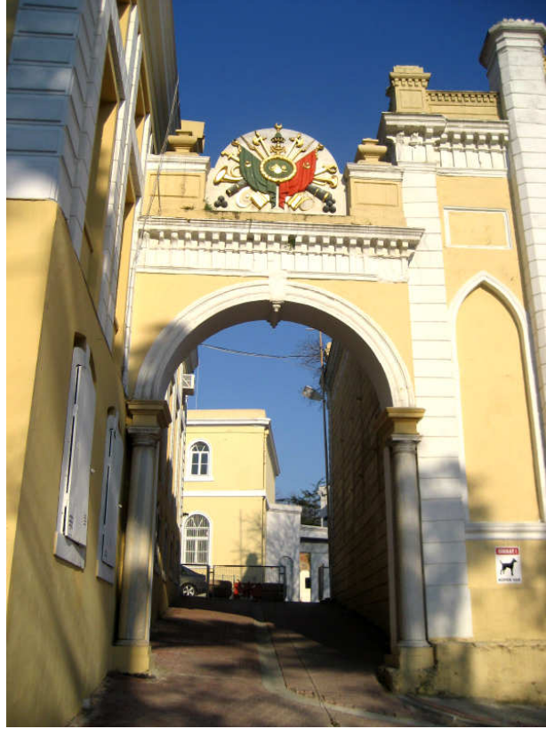
Şekil 3.268 Yıldız Sarayı Karakolunun güneybatı cephesi ile su deposu arasındaki kemerli kapı (9 Nisan 2009)
