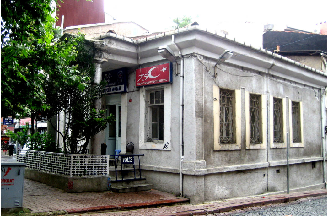
Şekil 3.102 Fatih Çarşamba Karakolu batı ve güney cephesi (10 Temmuz 2010)
