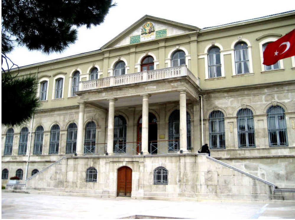
Şekil 3.155 II. Abdülhamid döneminde yenilenen Mekteb-i Harbiye-i Şahane'nin güney cephesi (2 Nisan 2009)
