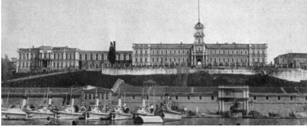
Şekil 3.58 1880–1893 yılları arasında Abdullah Frères tarafından çekilen fotoğrafta Bahriye Merkez Hastanesi'nin deniz cephesinden görünümü [65] (Yıldız Albümleri/L.C. Arşivi/F.no: 81713)
