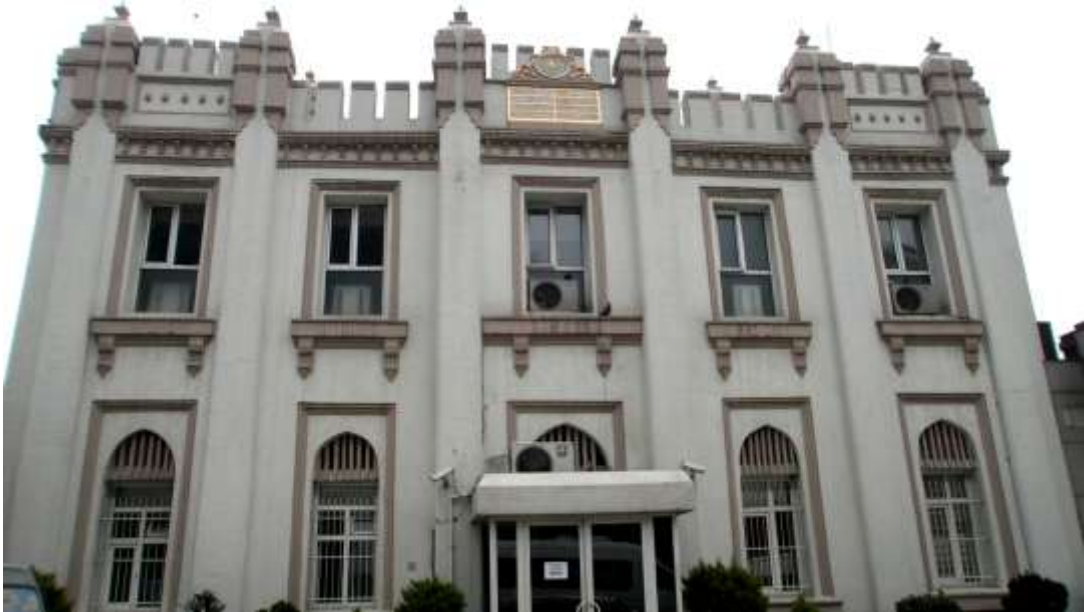
Şekil 3.271 Mesarburnu Karakolu batı cephesi (26 Ekim 2010)
