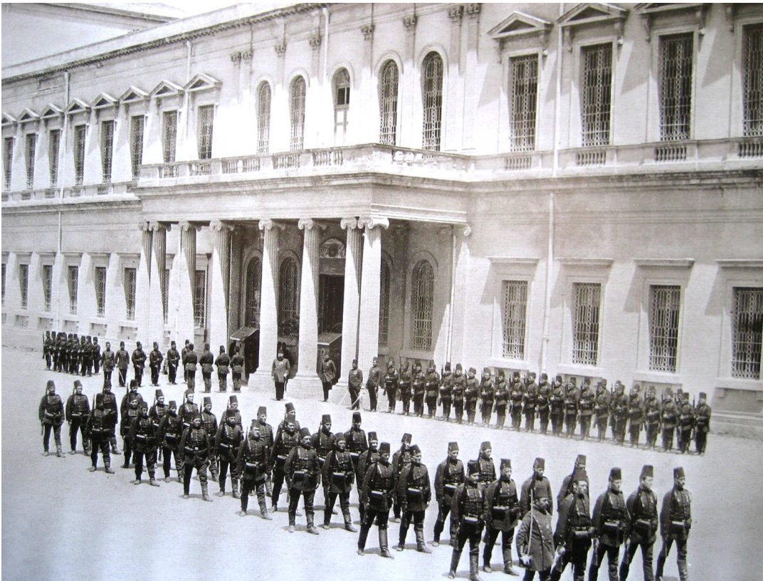
Şekil 3.173 1880–1883 yılları arasında Abdullah Fréres tarafından çekilen Taşkılla'nın batı cephesi [65 ] (Yıldız Albümleri/LC. F. no: 81705)
