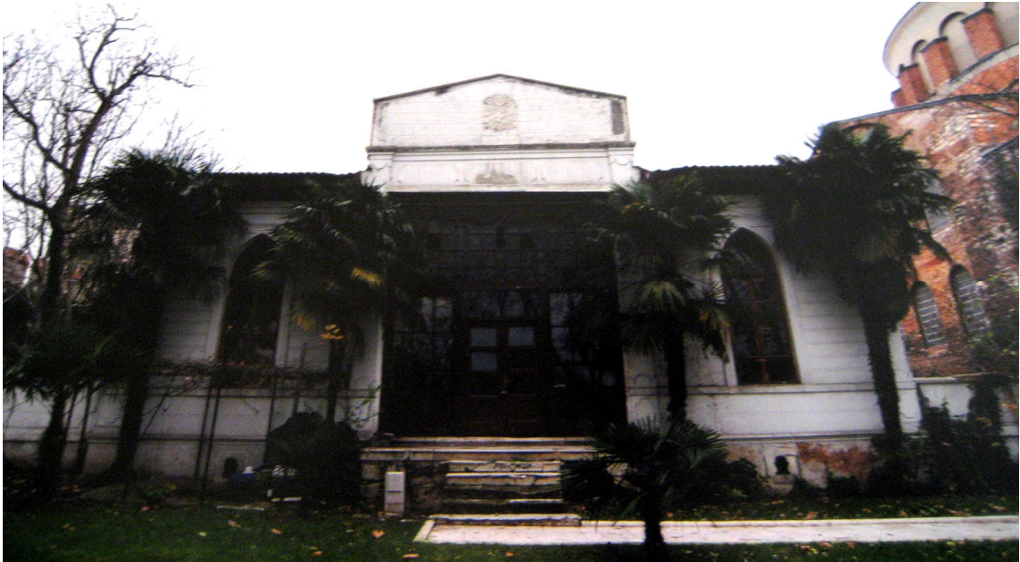
Şekil 3.330 Topkapı Sarayı I. Avlu Dış Karakol Binası doğu cephesindeki restorasyon öncesi fotoğrafı (Karakol Restaurant arşivi)
