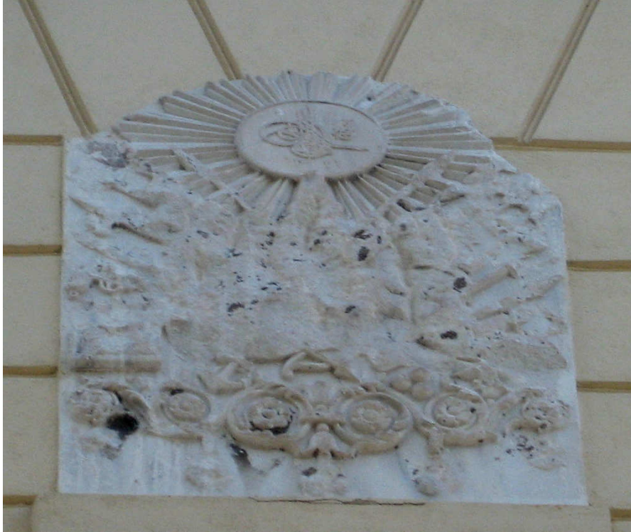
Şekil 3.332 Topkapı Sarayı Dış Karakol Binası II. Abdülhamid tuğralı arma (20 Ekim 2010)
