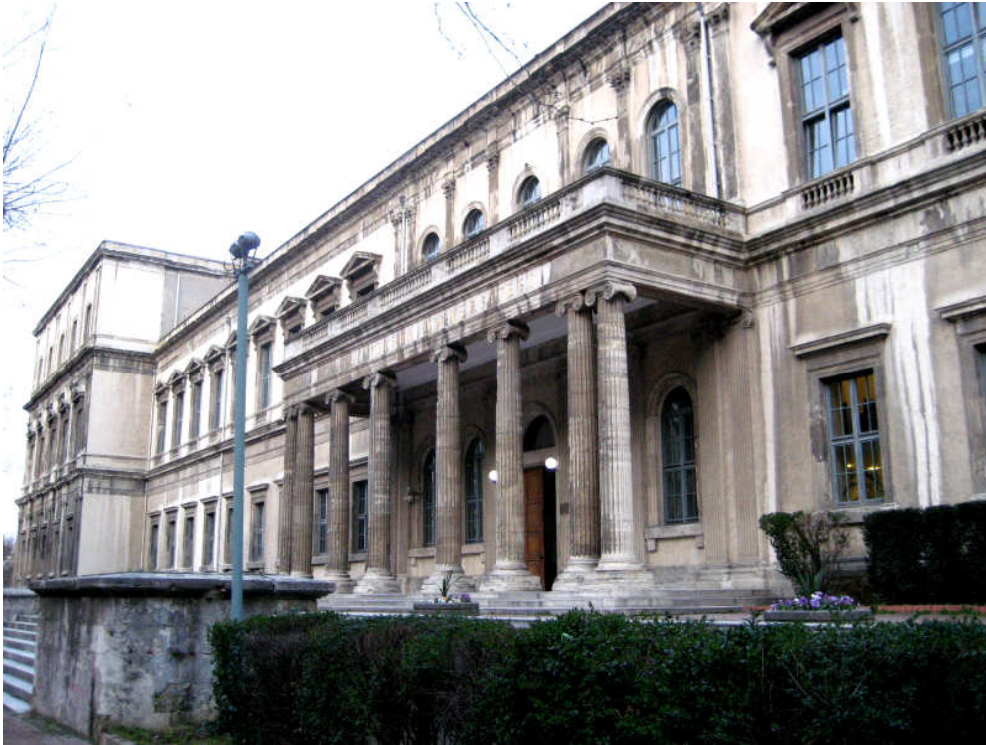
Şekil 3.175 Taşkışla'nın batı cephesi (2010)
