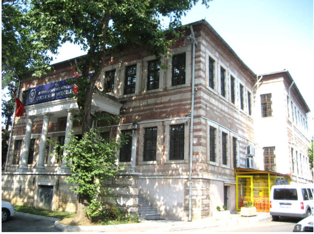
Şekil 3.132 Çinili Karakol'un güneybatı cephesi (26 Temmuz 2010)
