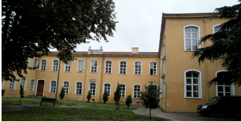
Şekil 3. 259 Hendesehane'nin C Blok olarak kullanılan güney cephesi (27 Ekim 2010)
