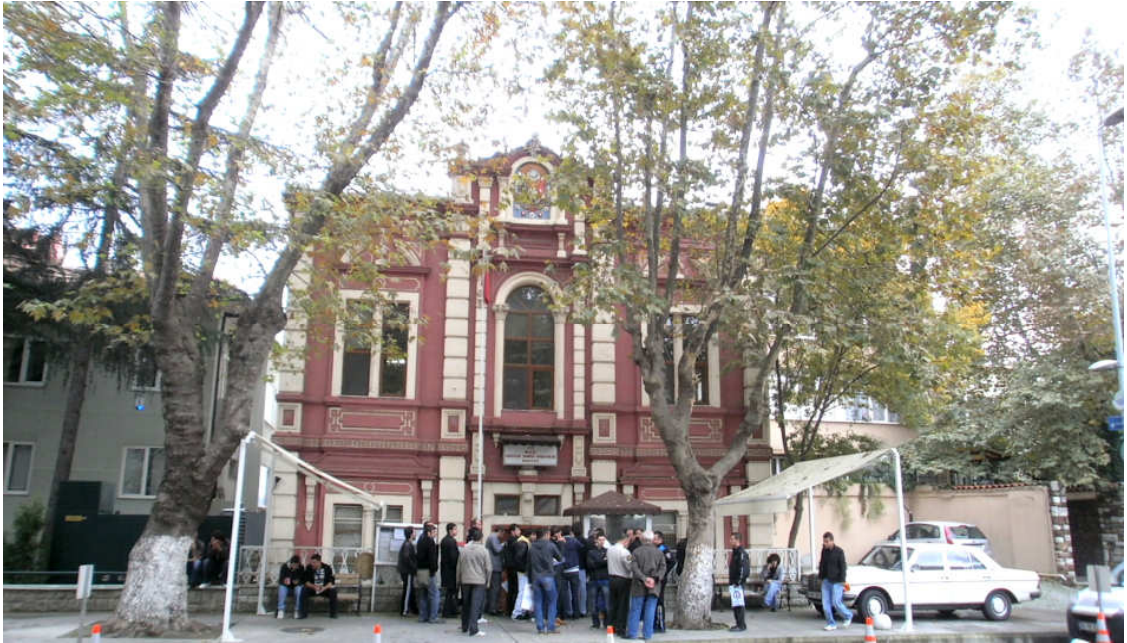
Şekil 3.310 Yeniköy Karakolu Köybaşı Caddesi'ne bakan batı cephesi (26 Ekim 2010)
