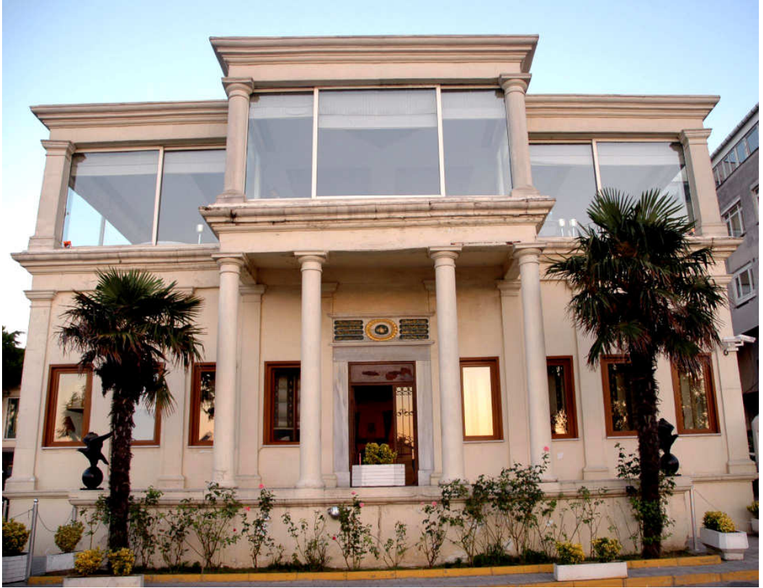
Şekil 3.123 Şemsipaşa Karakolu batı cephesi (29 Temmuz 2010)
