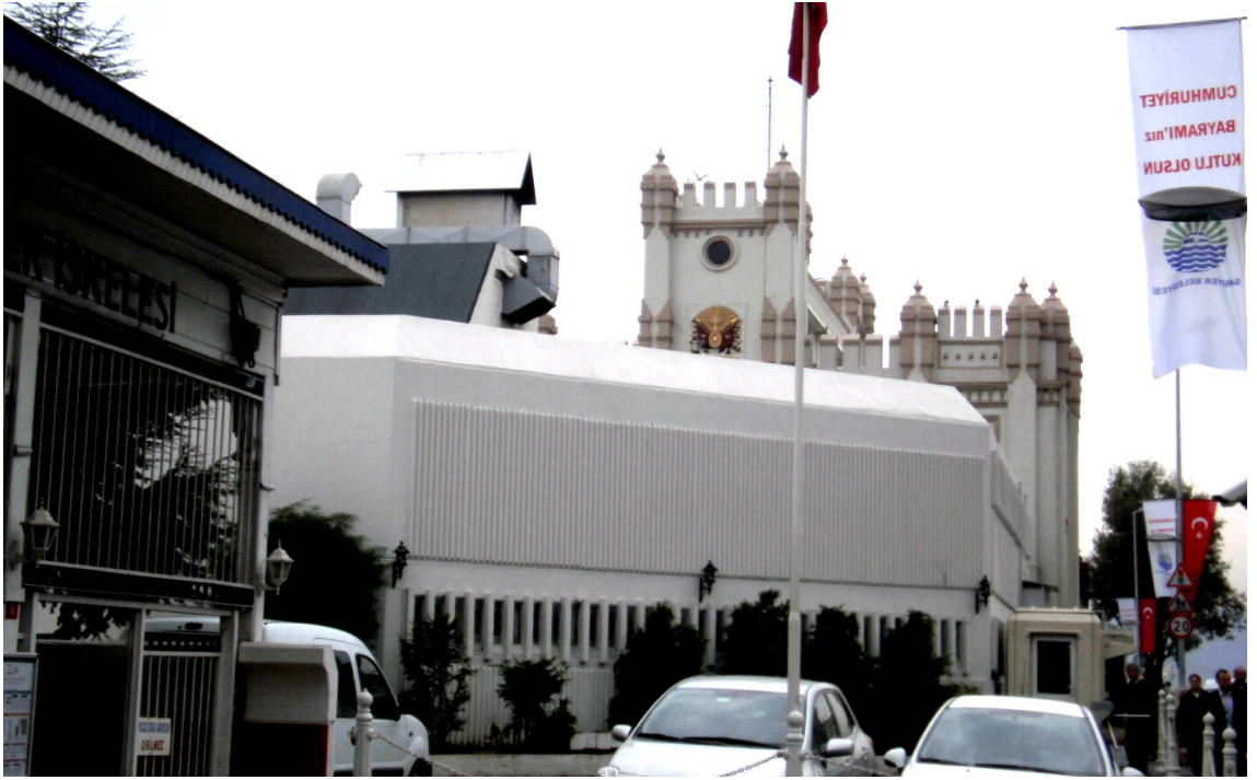
Şekil 3.275 Mesarburnu Karkolu kuzey cephesi. Önündeki yapı yakın tarihte ilave edilen restoran (26 Ekim 2010)
