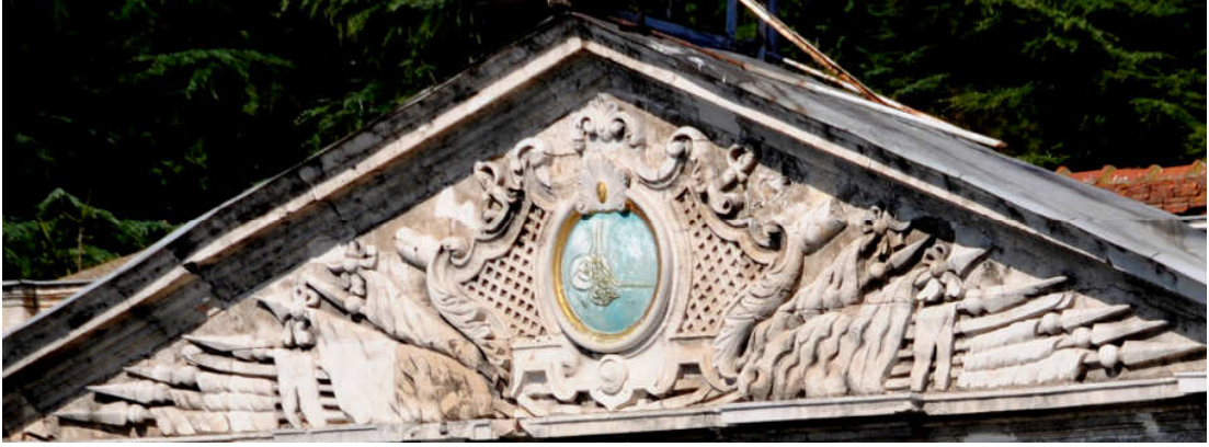
Şekil 3.76 Üçgen alınlığın restorasyon öncesi ön cepheden görünüşü (2009)
