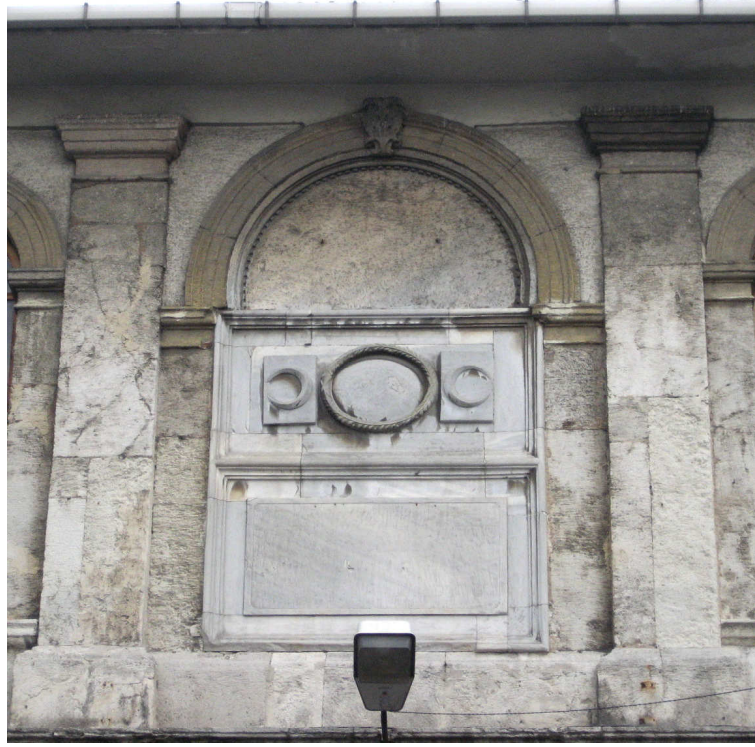
Şekil 3.226 Kocamustafapaşa Askeri Rüşdiyesi ikinci katında bulunan yarım daire kemerli nişi (17 Şubat 2010)
