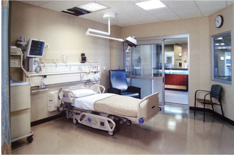
Şekil 3. 42 Duvar tipi yatak başı ünitesi ile düzenlenmiş yoğun bakım odası [12]
