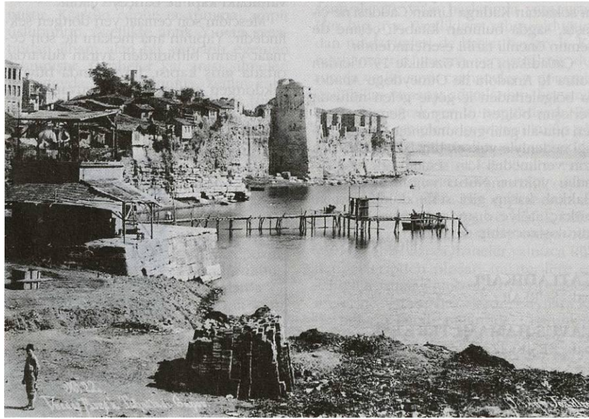
Şekil A.24 Çatladıkapı, 19. yüzyıl (Sebah & Joallier, İstanbul Araştırmaları Enstitüsü)
