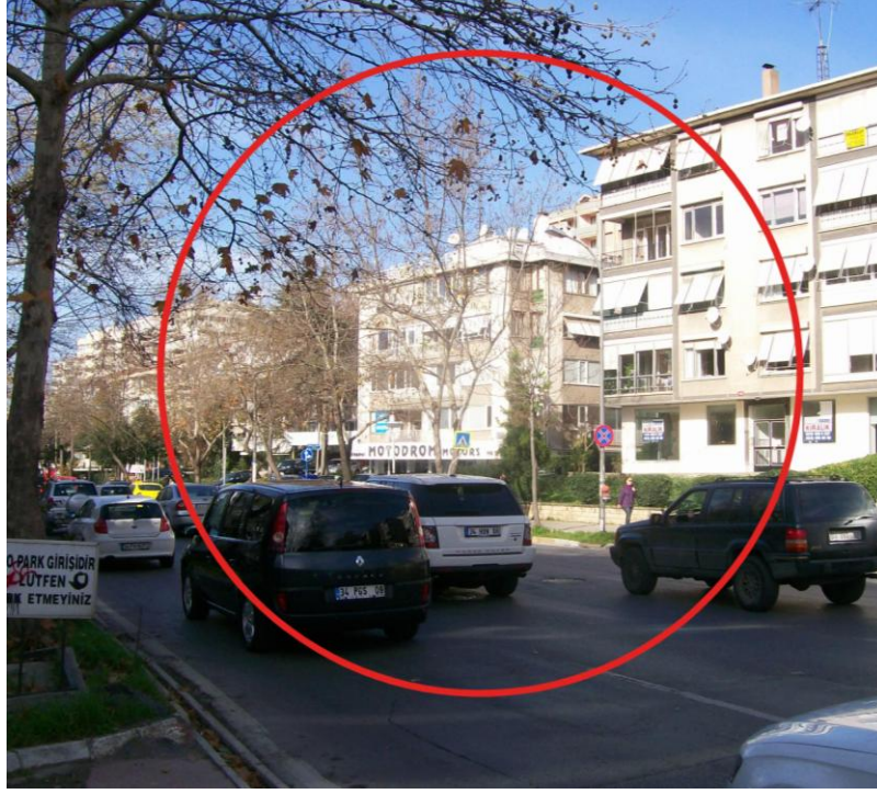
Şekil 8. 1 Uygulamanın gerçekleştirildiği örnek yapının görünüşü
