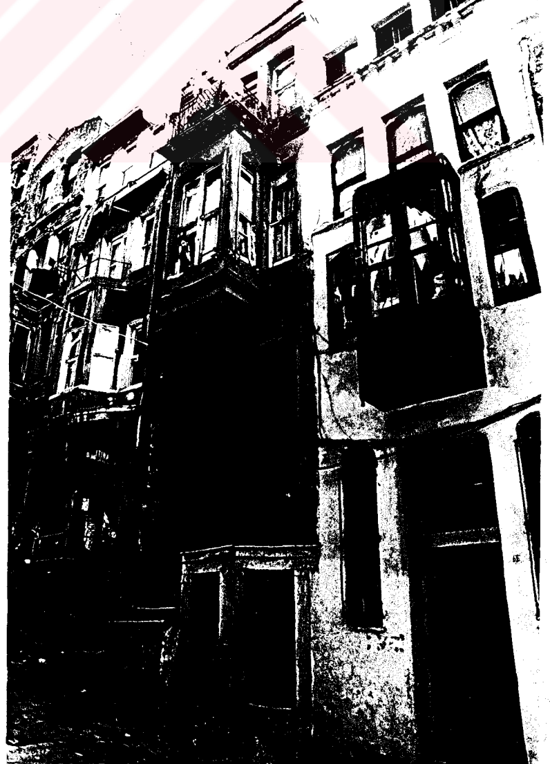
R. 2.7.73 SARAYIÇI SOKAK DOĞU CEPHESİ
