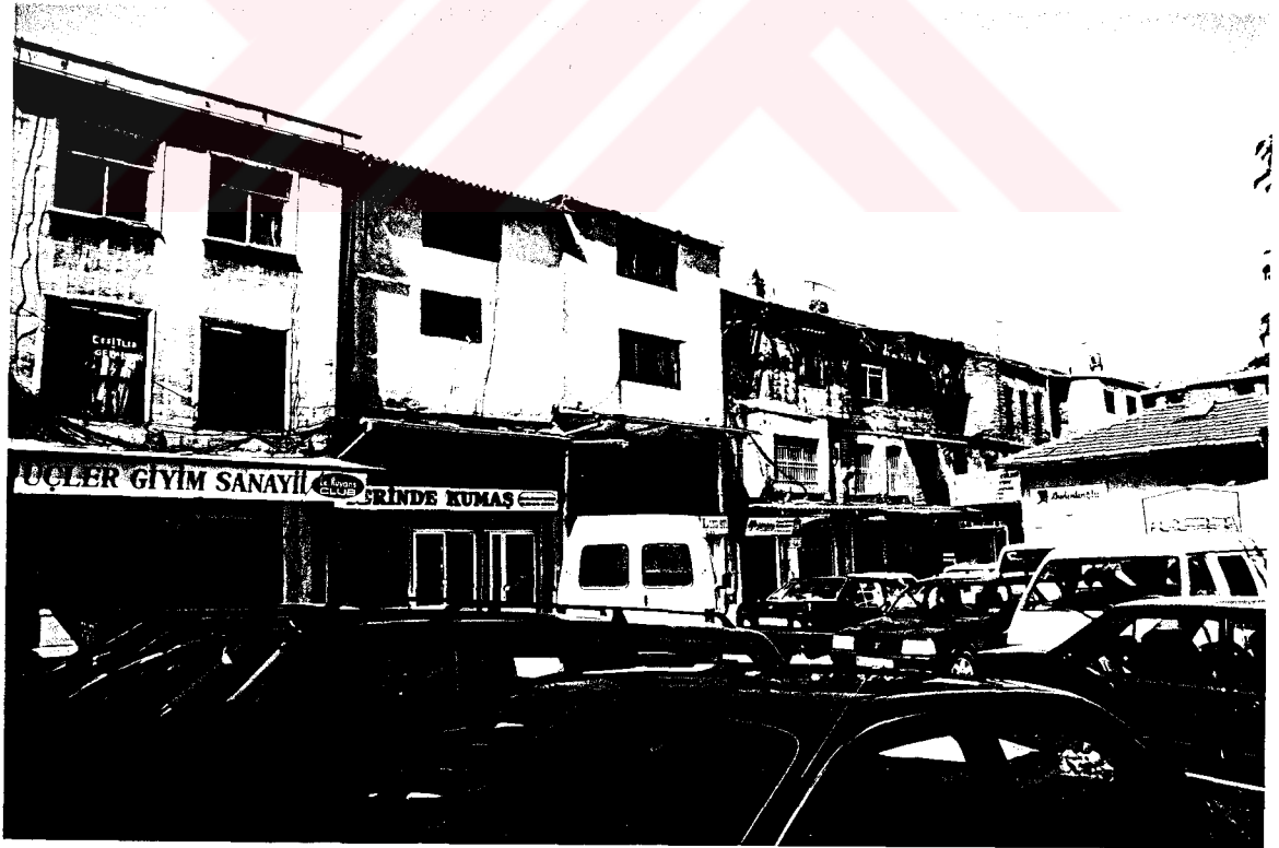
R. 2.7.5 ANA AVLU KUZEY CEPHESİ
