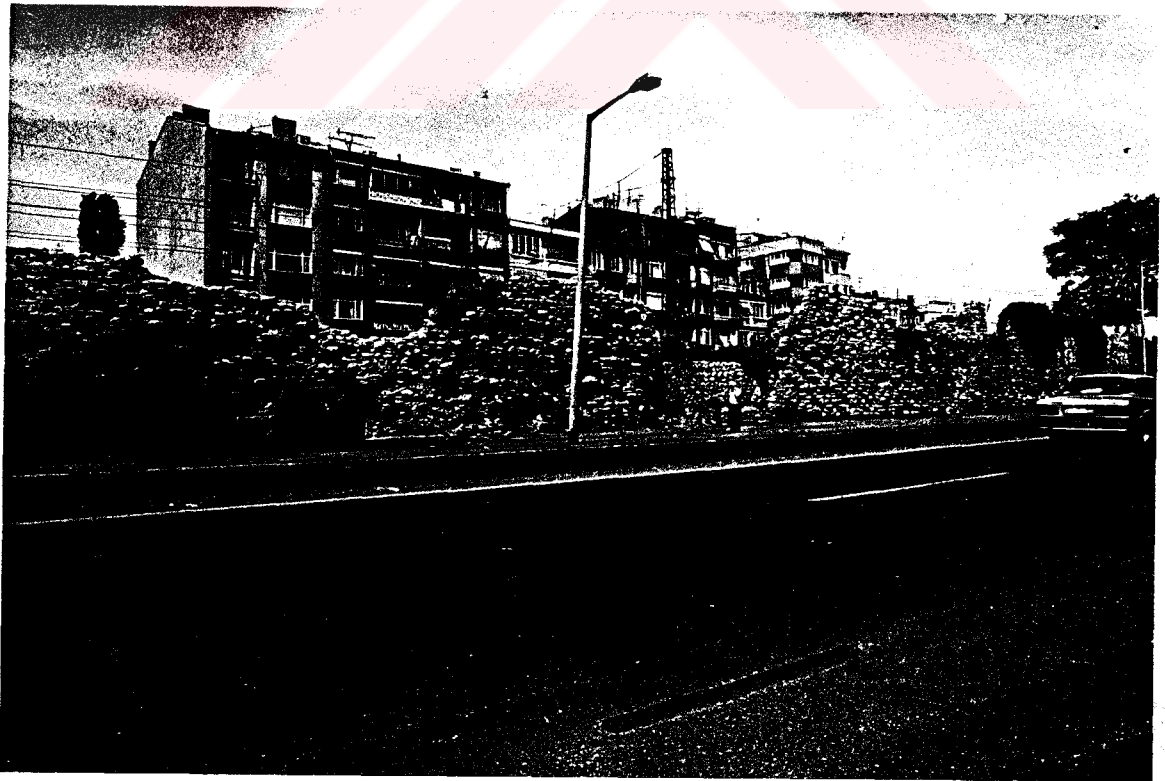
R. 2.8.18 MARMARA SAHİLİ. SURLARI (Yenikapı - Kumkapı arası)
