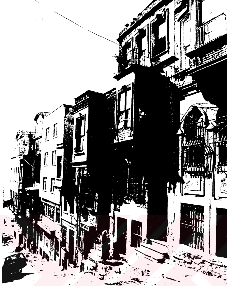
R. 2.1.71 SARAYIÇI SOKAK BATI CEPHESİ
