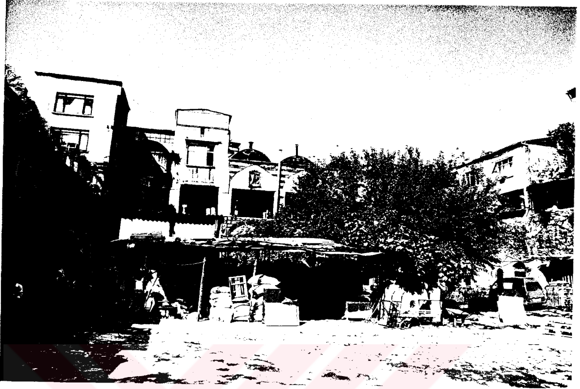
R. 2.7.33 BALKAPANI HAN AVLU KUZEYDOĞU CEPHESİ
