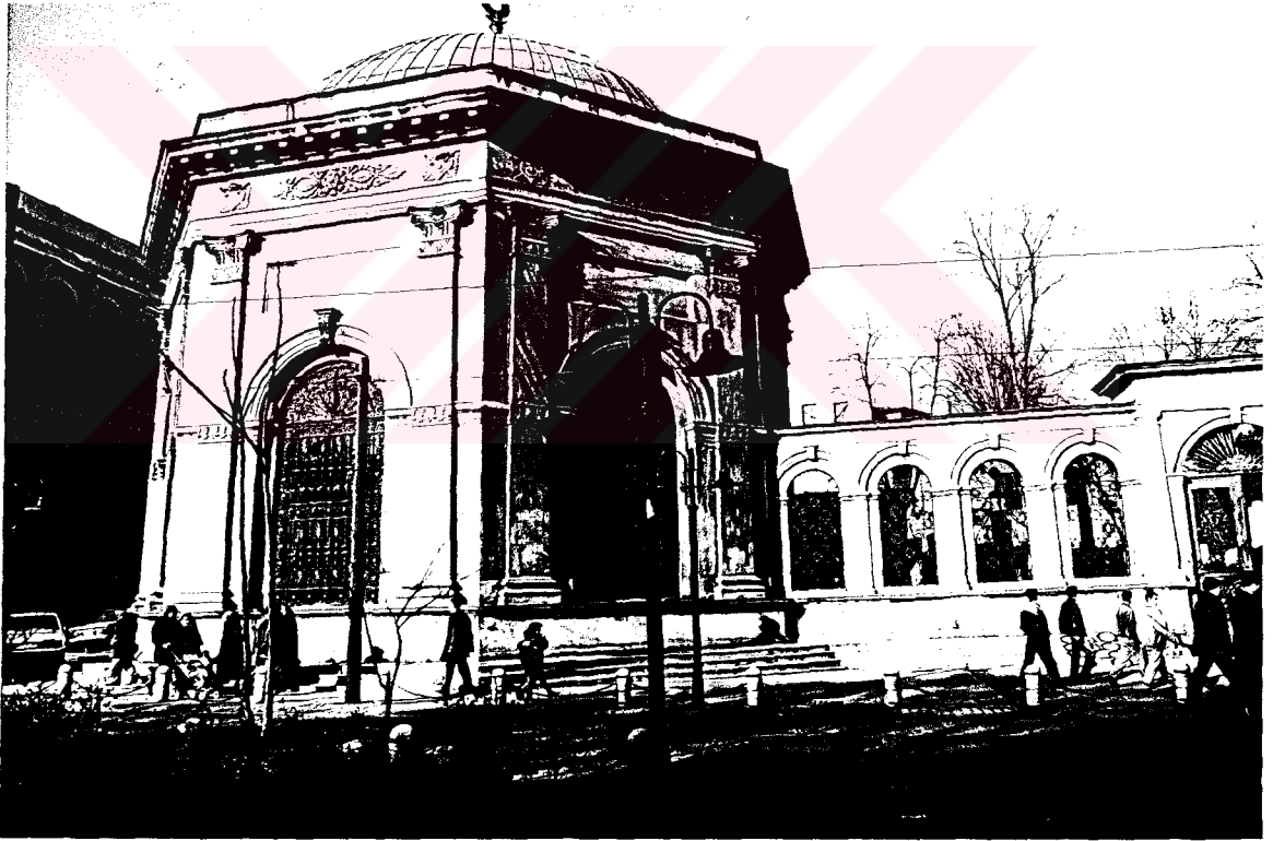
R. 2.6.20 SULTAN ILMAHMUT TÜRBESİ
