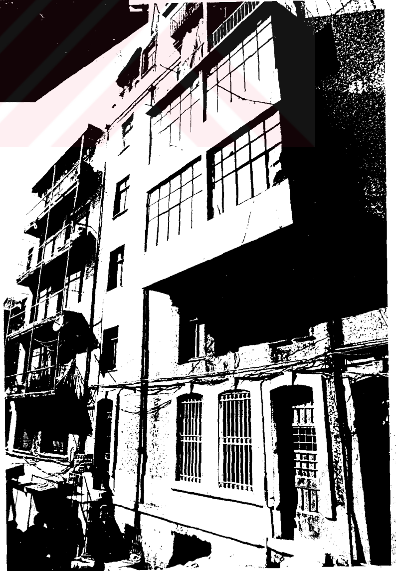
R. 2.1.70 SARAYIÇI SOKAK BATI CEPHESİ
