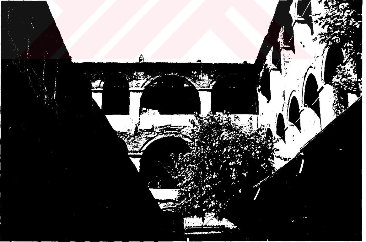
R. 2.7.18. BÜYÜK YENİ HAN AVLU KUZEY CEPHESİ
