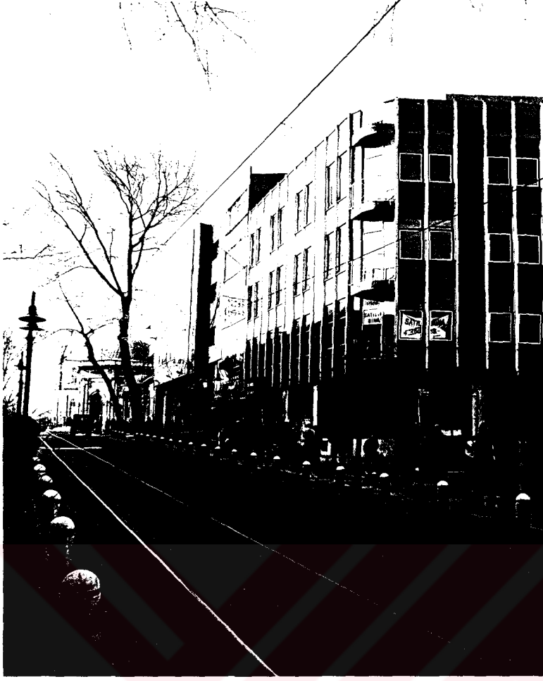
R. 2.6.29 II.MAHMUT TÜRBESİ - SULTANAHMET ARASI YENİ YAPILANMALAR
