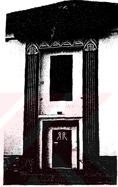
Şekil 3.27 Dublin'de bir endüstri tesisinin, büro binasının girişi
