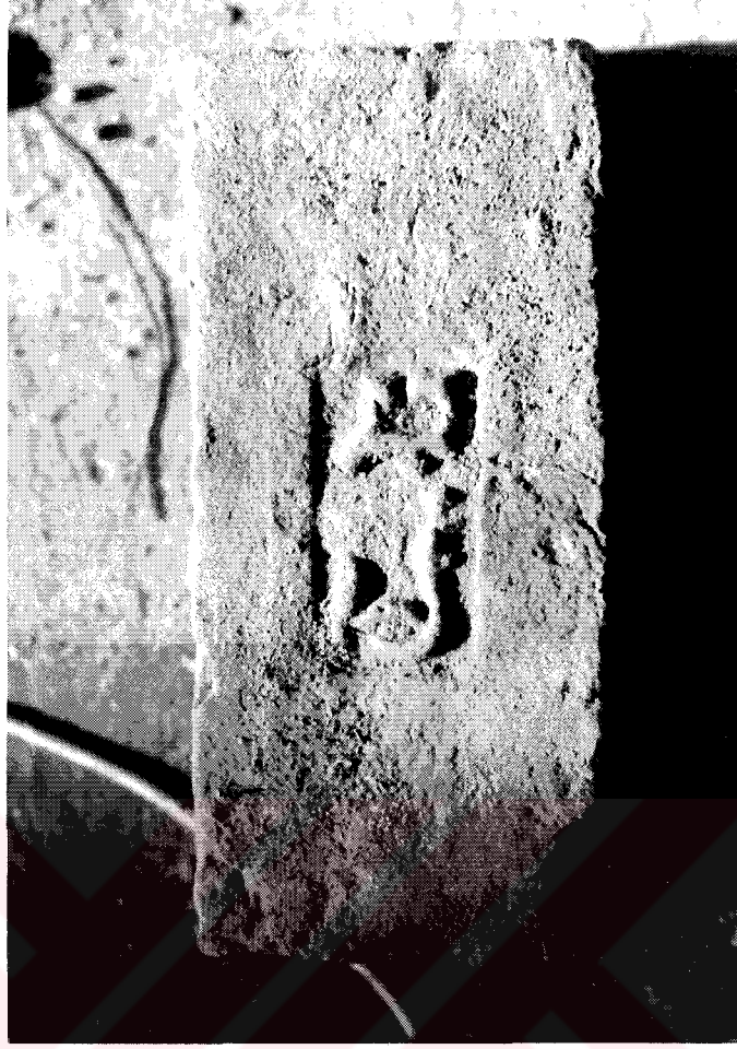
Resim 3.125 Buhara (Özbek) Tekkesi'nde kullanılan modern ölçülü tuğla (22 x 9.5 x 6.5 cm.)
