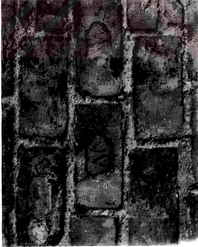
Resim 3.126 Buhara (Özbek) Tekkesi'nde kullanılan modern ölçülü tuğla (22.5 x 11 x 7 cm.)
