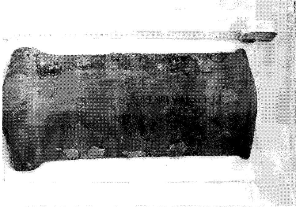
Resim 3.168 Sultanahmet Cezaevi'nde kullanılan alaturka kiremit (45 x 23.5 cm.)
