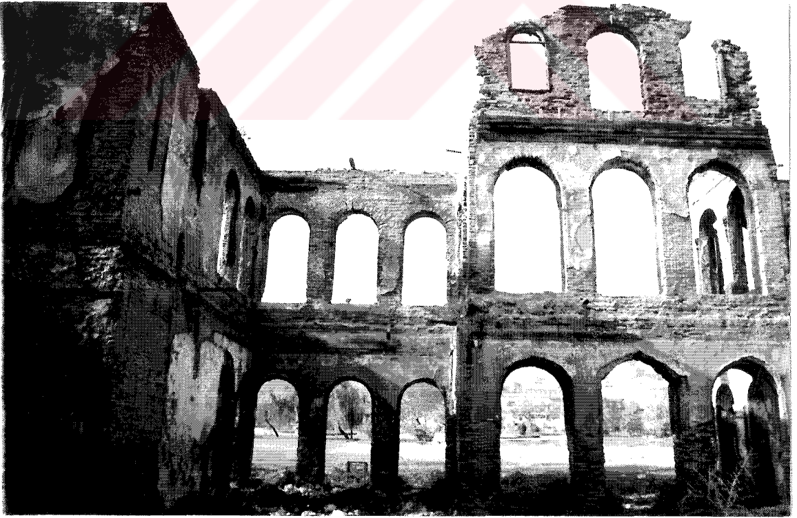
Resim 3.67 Kağıthane Kaser-ı Hümayun yapıları, Hunkar Kaser (yapı içinden batı cephesine bakış)
