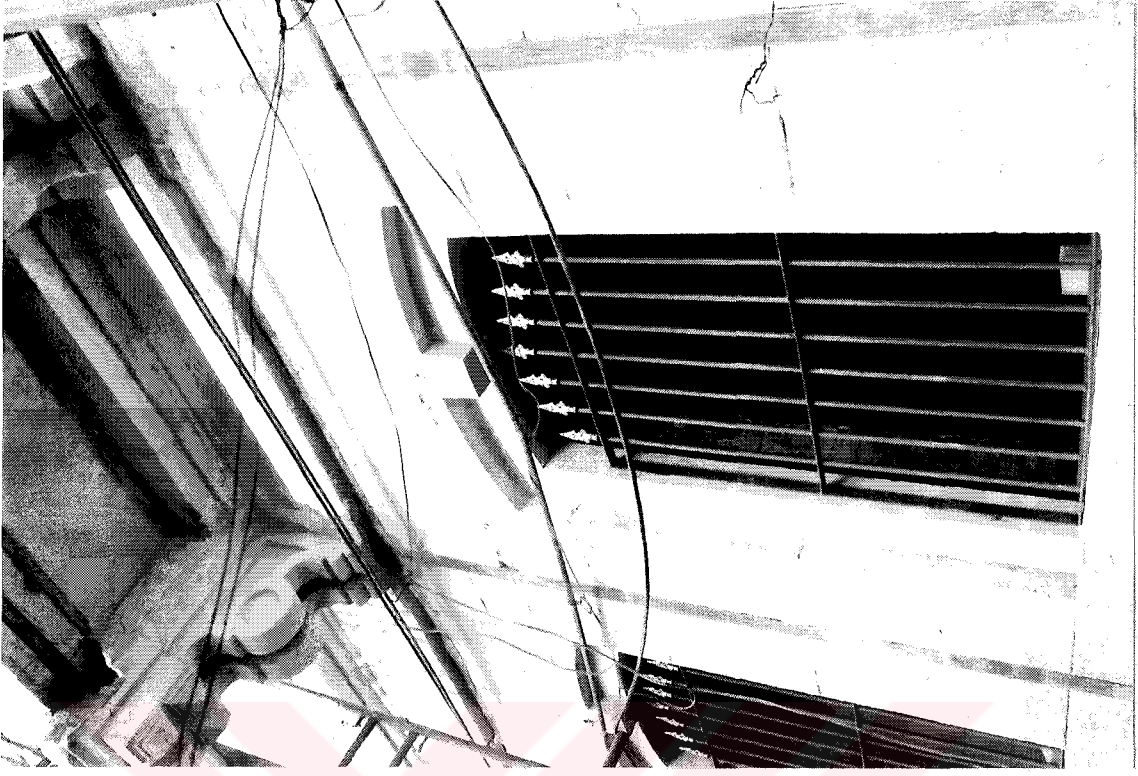
Resim 3.100 Akaretler, yığma kâgir taşıyıcının metal strüktür ile desteklenmesi (restorasyon sonrası)
