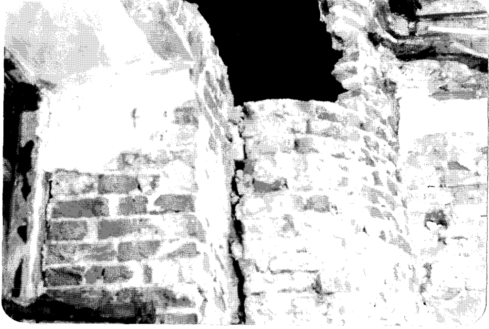
Resim 3.95 Avrupa (Aynalı) Pasajı düşey taşıyıcı yığma tuğla, yatay taşıyıcı volta döşeme (Restorasyon projesi ve uygulama Prof. Haluk Sezgin -1992)
