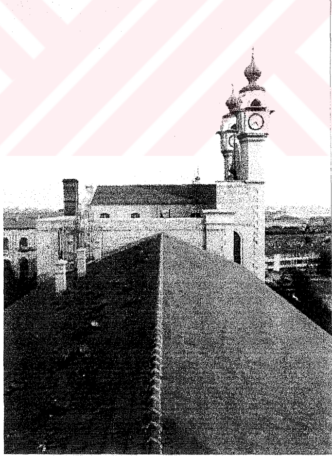
Resim 3.140 Mekteb-i Tıbbiye-i Şahane Binası volta döşeme çatı strüktürü üzeri Marsilya tipi kiremit örtü
