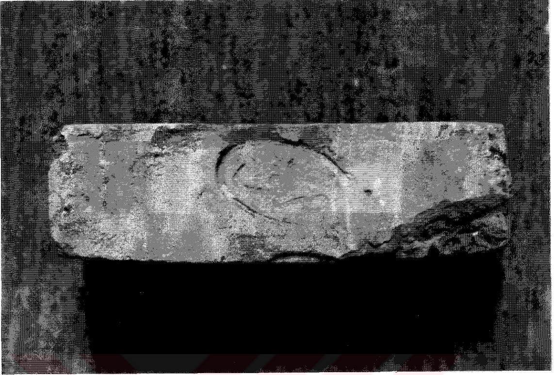
Resim 3.105 Akaretler'de kullanılan modern ölçülü tuğla ( 21 x 10 x 6 (6.5) cm.)
