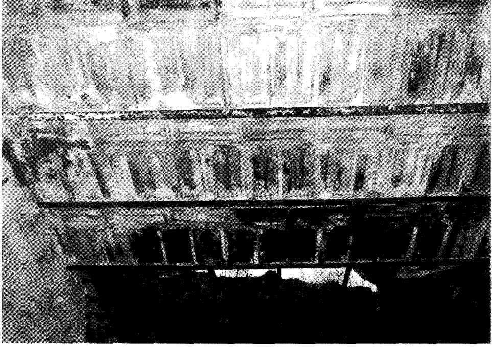
Resim 3.132 Hasan Hüsnü Paşa Tekke ve Türbesi yatay taşıyıcı volta döşeme (putreller arası Marsilya tipi kiremit)
