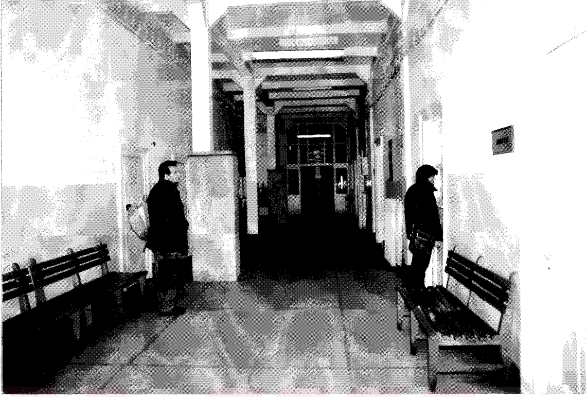
Resim 3.186 Galata Gümrük Binası, fer-beton yapım tekniğinde düşey ve yatay taşıyıcılar
