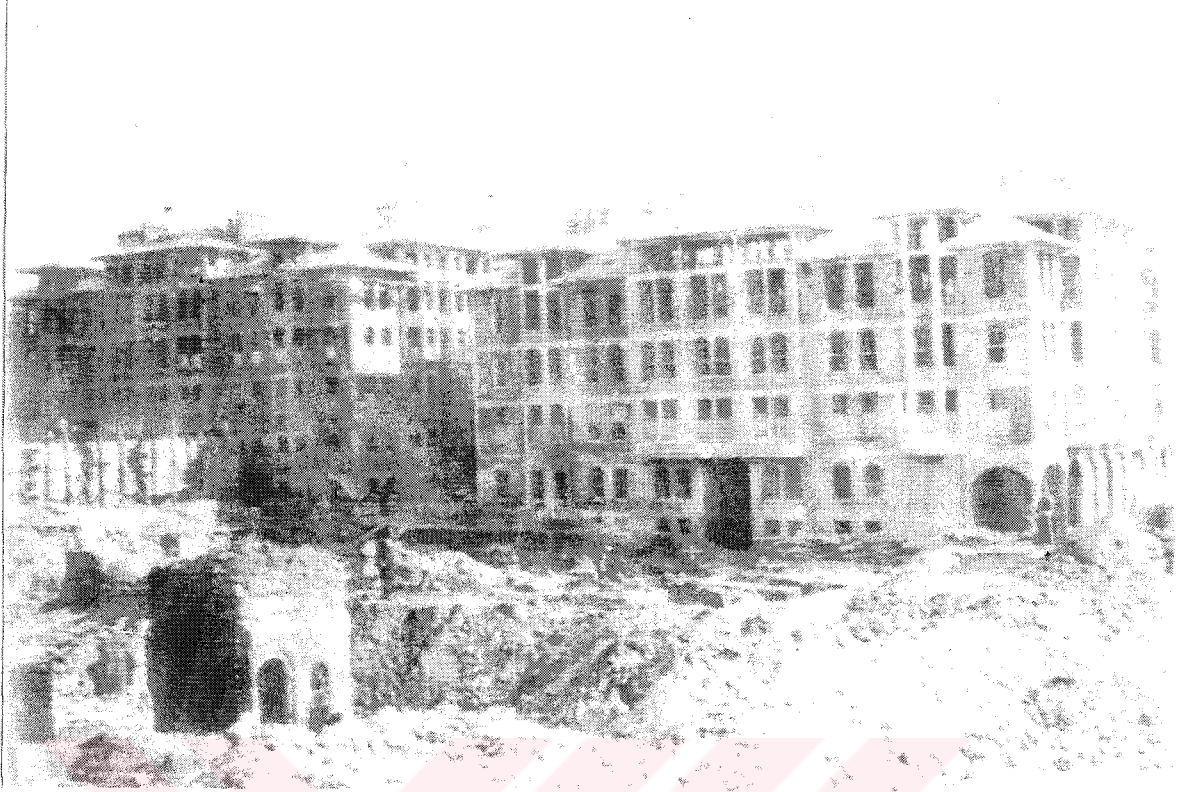
Resim 3.201 Harikzedegan Apartmanları, betonarme iskelet yapım tekniđi
