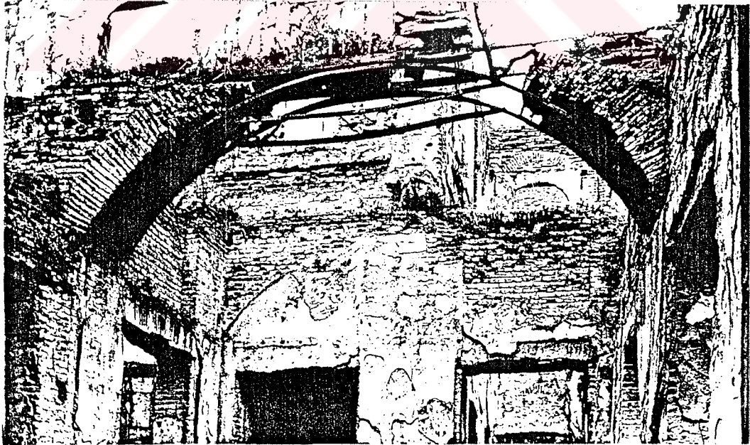
Resim 3.54 Çırağan Sarayı, tuğla kemerleri destekleyen metal donatı
