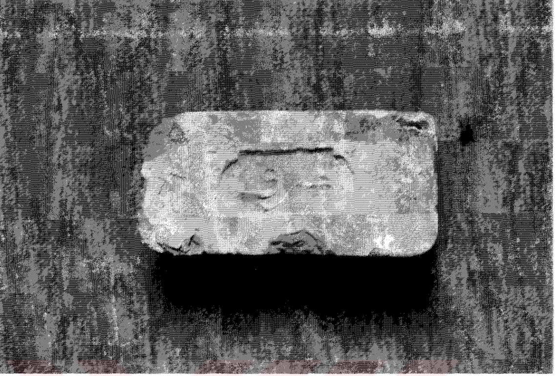
Resim 3.103 Akaretler'de kullanılan modern ölçülü tuğla ( 21 x 10 x 7.5 cm.)
