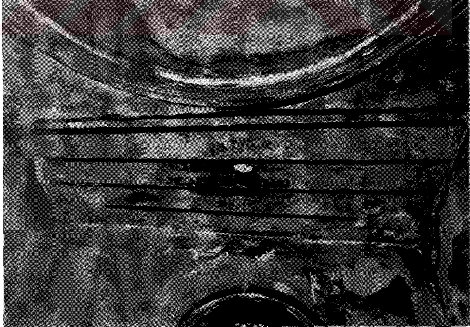
Resim 3.131 Hasan Hüsnü Paşa Tekke ve Türbesi yatay taşıyıcı volta döşeme (putreller arası tuğla)
