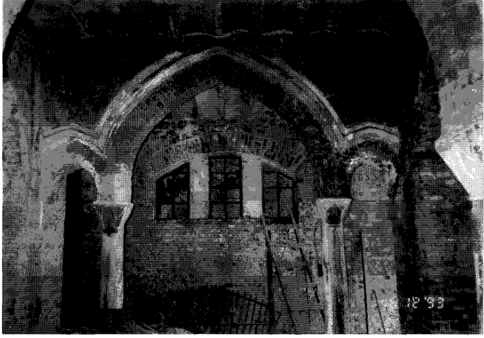
Resim 3.150 Sultanahmet Cezaevi, düşey taşıyıcı yığma tuğla
