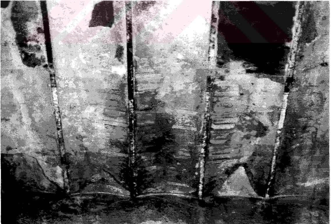
Resim 3.102 Akaretler, yatay taşıyıcı volta döşeme (putreller arası Marsilya tipi kiremit)
