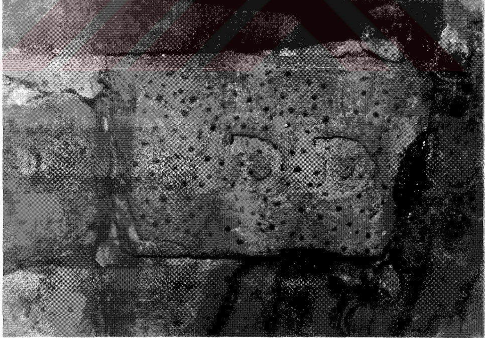
Resim 3.61 Fer'ie Sarayları, Müştemilat Binası giriş sahanlığı volta döşeme tuğlası (21.5-22 x 10 x 6.5 cm.)
