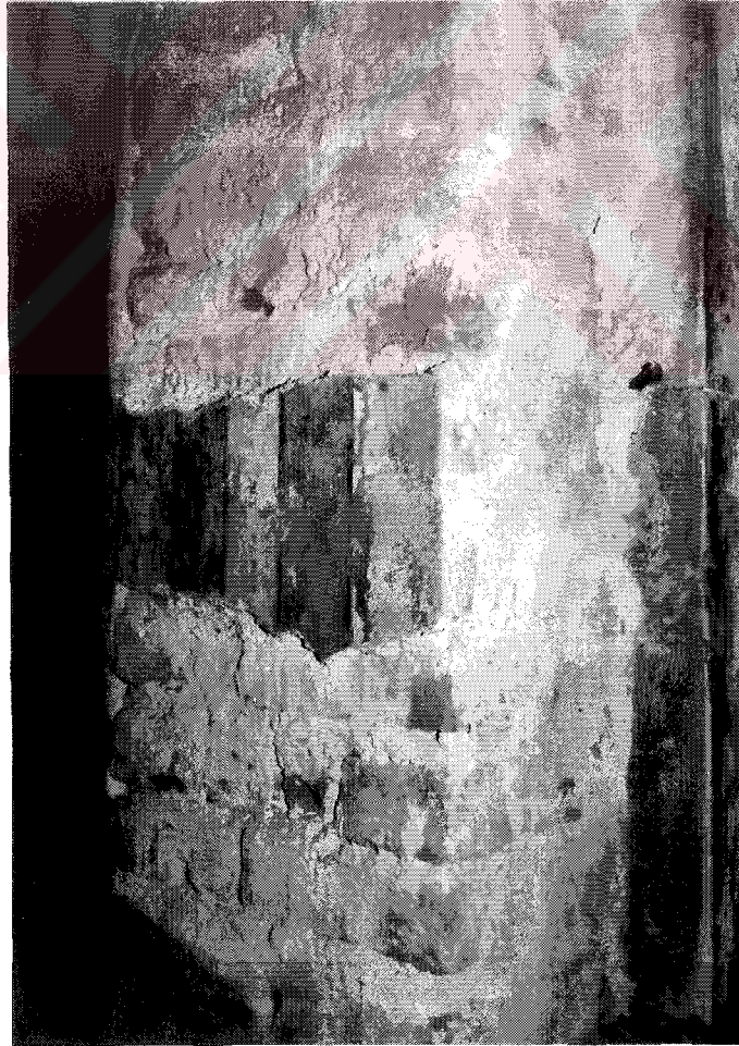
Resim 3.129 Hasan Hüsnü Paşa Tekke ve Türbesi düşey taşıyıcı yığıma tuğla (23.5 x 11.5 x 7.5cm.)
