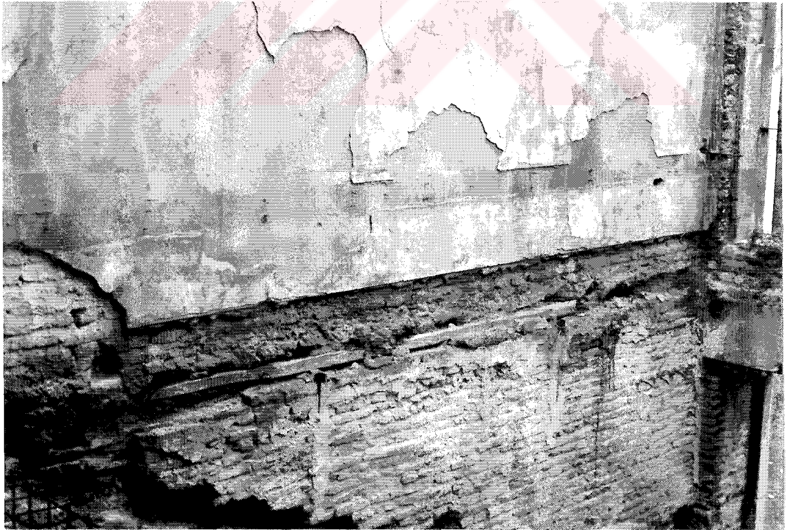
Resim 3.77 Adile Sultan Sarayı, kat döşemesi hizasında ahşap kiriş izleri
