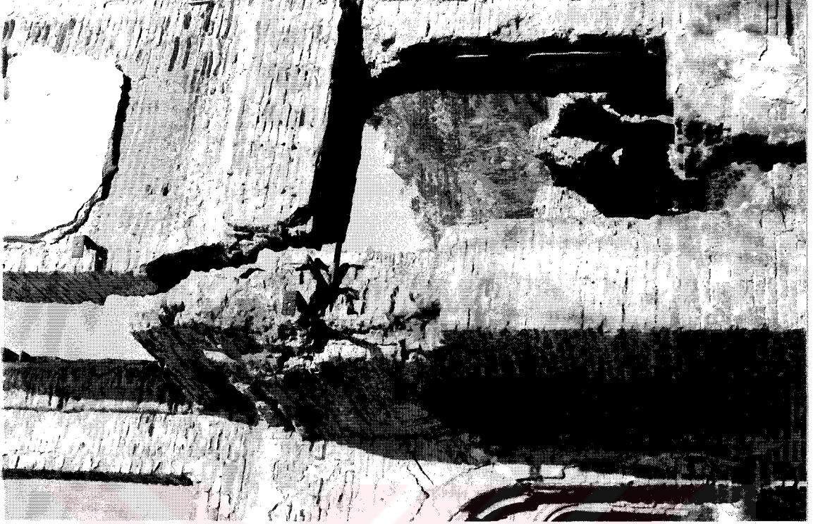
Resim 3.69 Hünkar Kasrı, metal kuşaklama detayı
