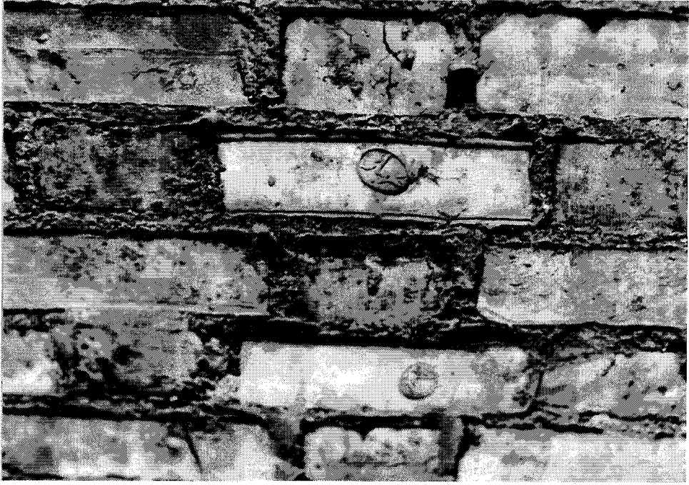
Resim 3.197 Sant' Antoine Kilisesi, taşıyıcı olmayan duvarlarda kullanılan modern ölçülü tuğla (21 x 12.5 x 6.5 cm.)
