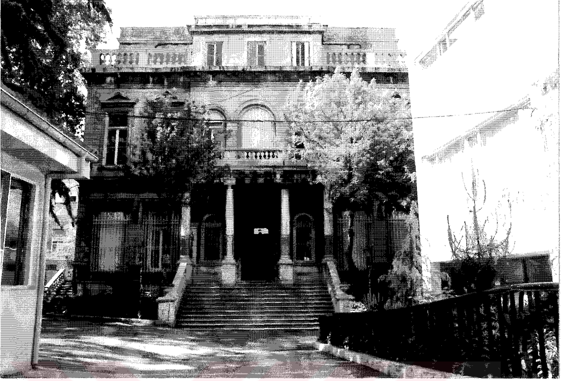
Resim 3.85 Mermer Konak (Mahmut Muhtar Paşa Konağı), kuzey (giriş) cephesi
