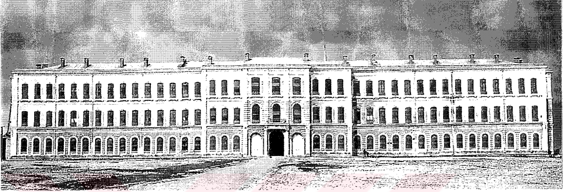
Resim 3.29 Harbiye Nezareti Binası (İstanbul Üniversitesi Rektörlük Binası)
