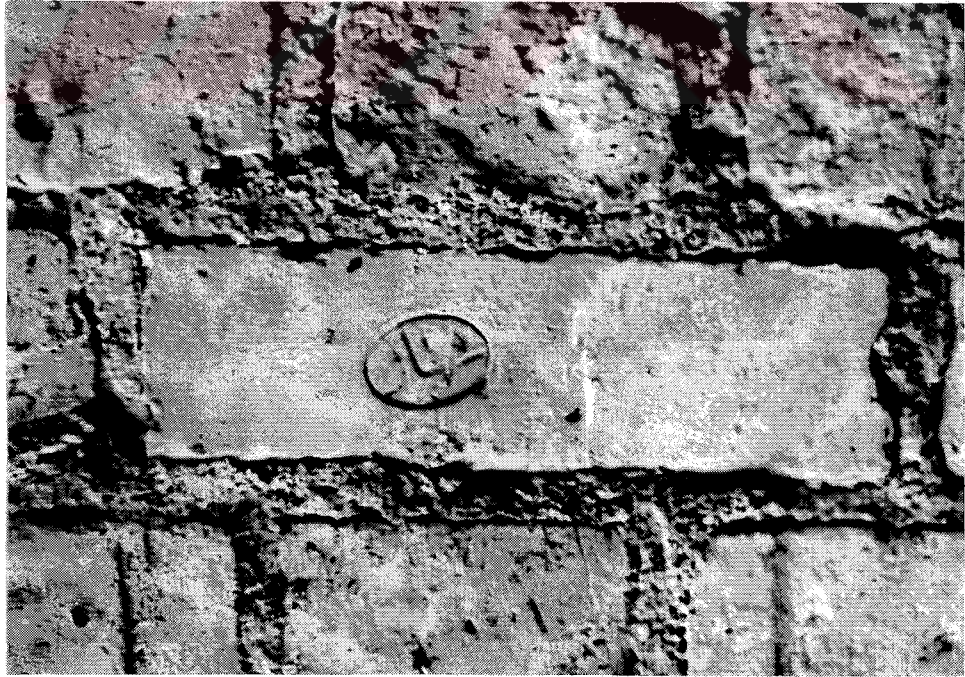
Resim 3.198 Sant' Antoine Kilisesi, taşıyıcı olmayan duvarlarda kullanılan modern ölçülü tuğla (21 x 12.5 x 6.5 cm.)
