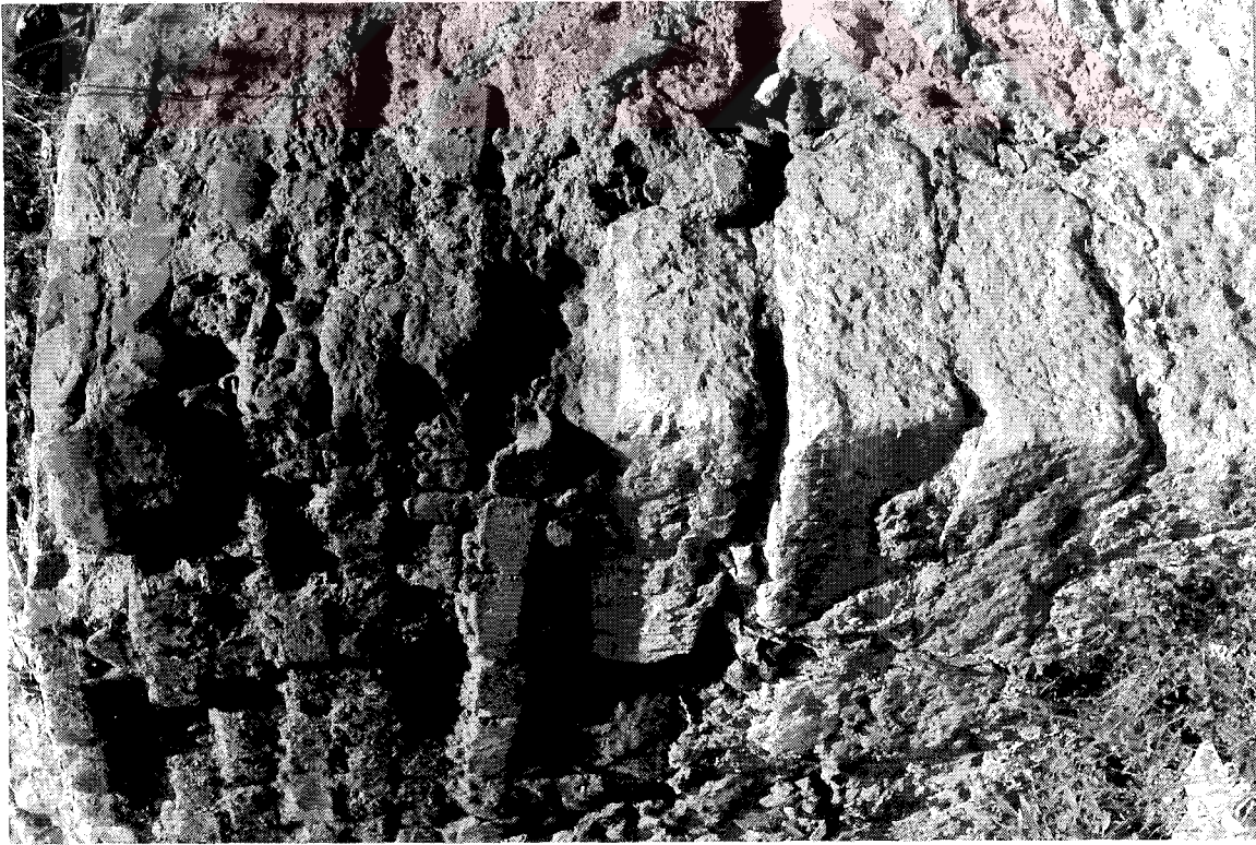
Resim 3.18 Darülfünun Binası, temel ve beden duvarı
