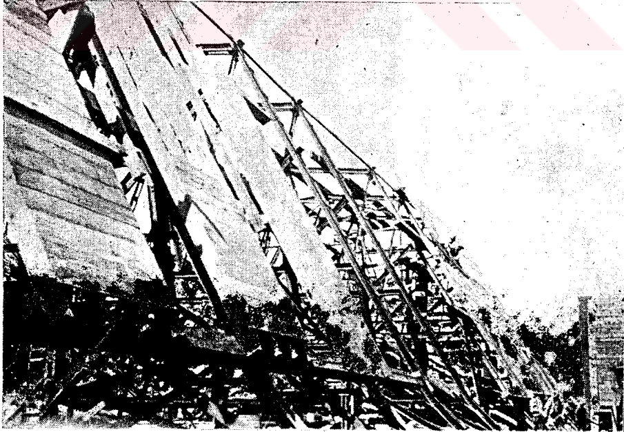
Resim 3.176 Haydarpaşa Garı, çatı konstrüksiyonu çelik iskelet
