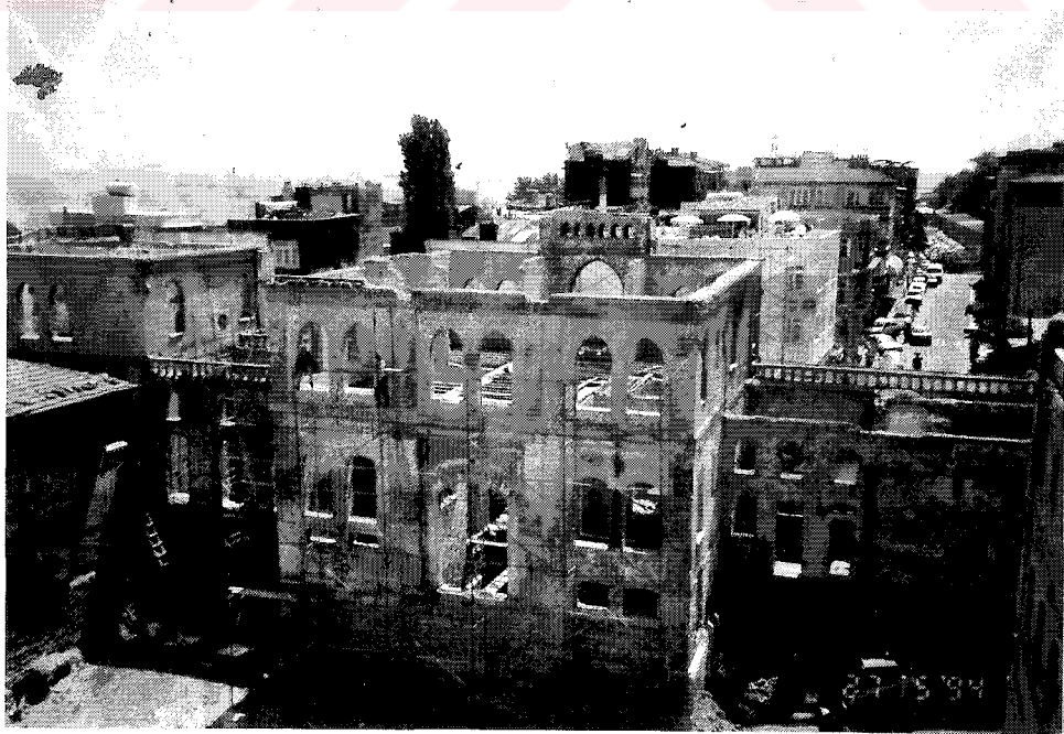
Resim 3.149 Sultanahmet Cezaevi, düşey taşıyıcı yağma tuğla
