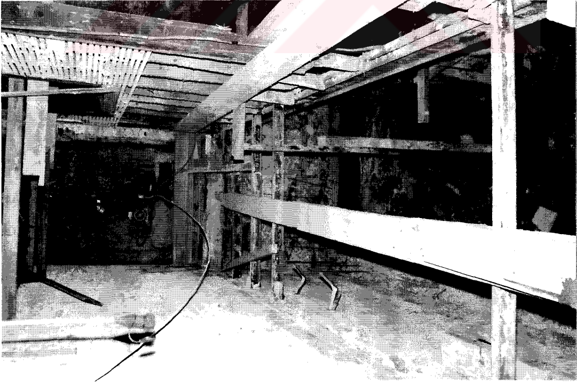
Resim 3.58 Fer' iye Sarayları, Müştemilat Binası, çelik putrel ile takviye ve metal kancalar
