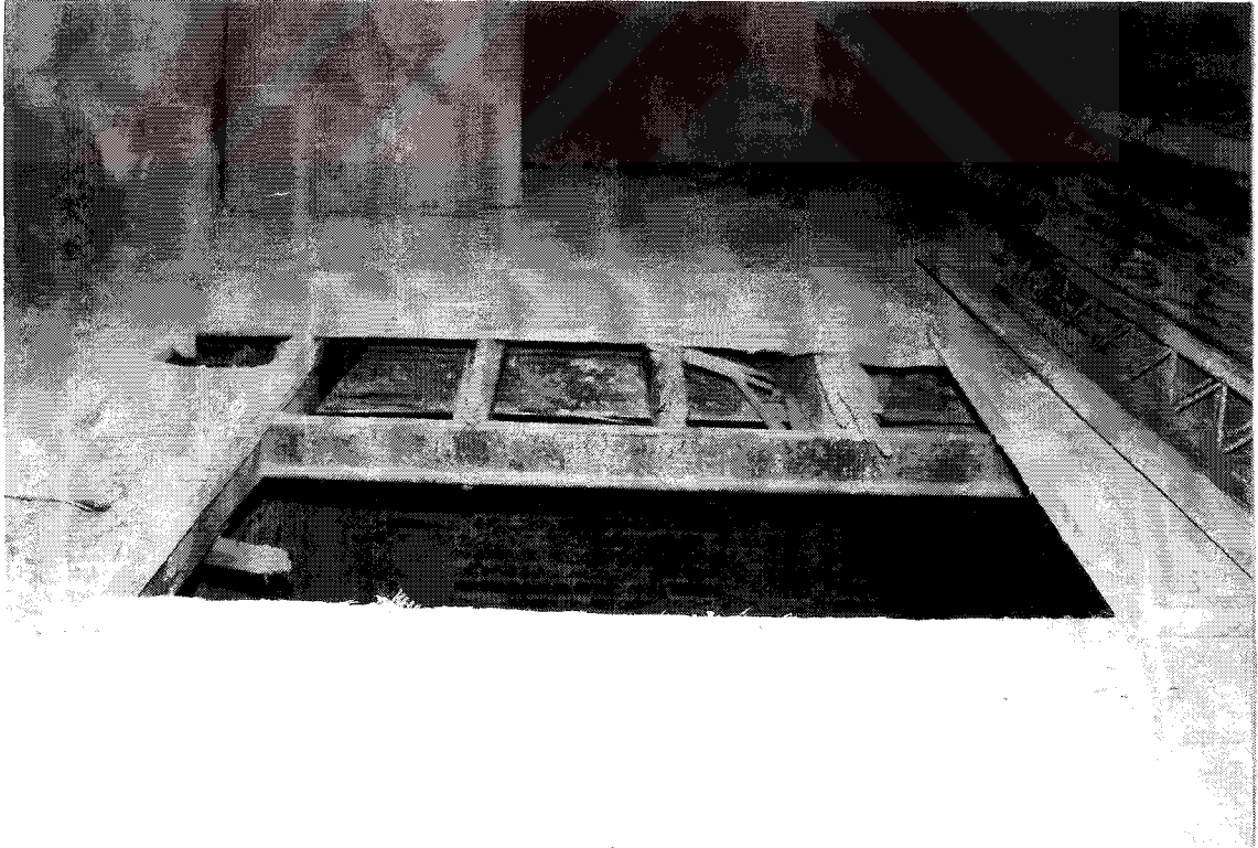
Resim 3.122 Akaretler, 1894 depremi sonrası yenilenen kat döşemeleri
