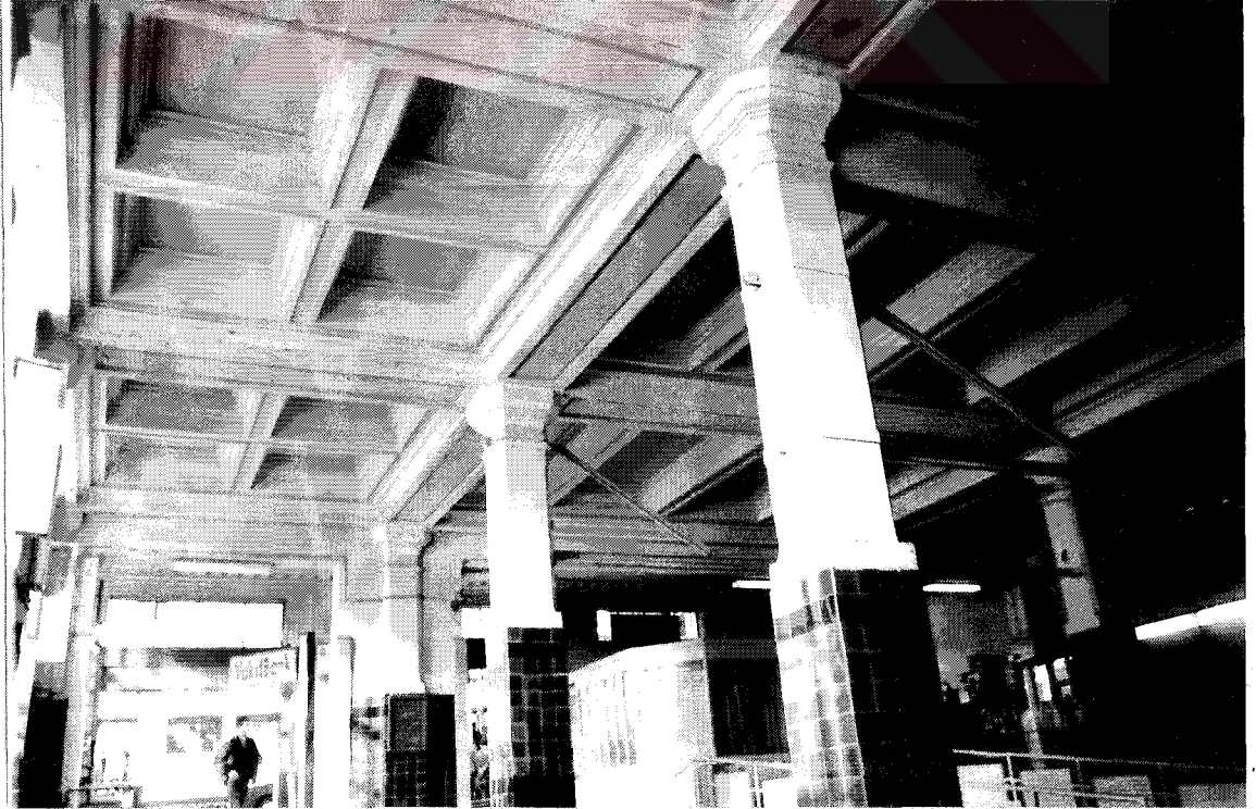
Resim 3.179 Metro Han Binası, çelik iskelet taşıyıcı sistem
