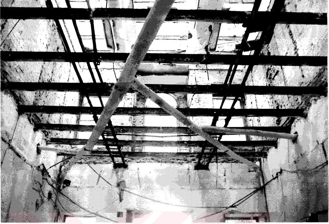
Resim 3.101 Akaretler, kapalı çıkmaları destekleyen pik demir kuşaklama.
