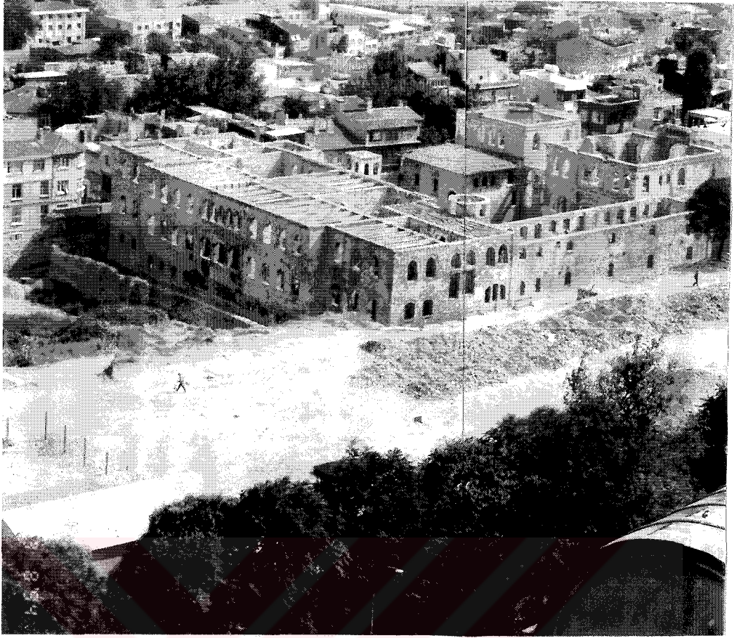
Resim 3.148 Sultanahmet Cezaevi, düşey taşıyıcı yağma tuğla
