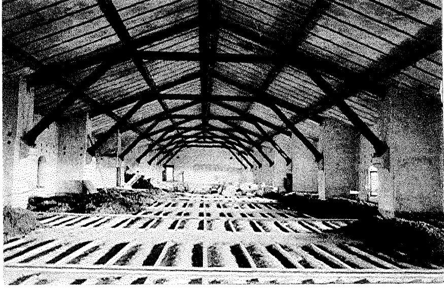
Resim 3.139 Mekteb-i Tıbbiye-i Şahane Binası yatay taşıyıcı volta döşeme, çatı strüktürü volta döşeme
