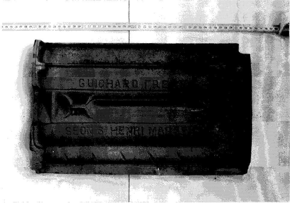
Resim 3.166 Sultanahmet Cezaevi'nde kullanılan Marsilya tipi kiremit (42 x 25 cm.)
