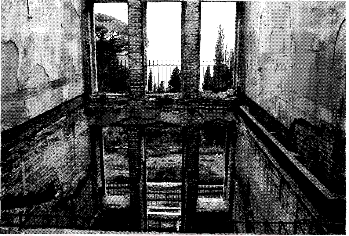
Resim 3.76 Adile Sultan Sarayı, yığma tuğla düşey taşıyıcı (30-31 x 14-15 x 5-6 cm.) (sağ duvarda yer alan metal elemanlar (I profil) restorasyon sırasında betonarme döşemeyi taşıması için konulmuştur.)
