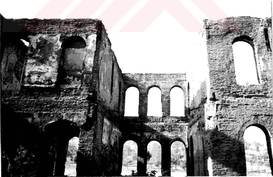
Resim 3.72 Maiyet Binası, yapı üzerinde ahşap kat döşemesine ait izler
