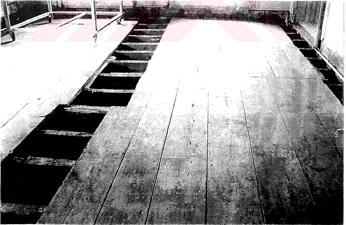
Resim 3.74 Büyük Mabeyn, kat döşemeleri ahşap kirişleme
