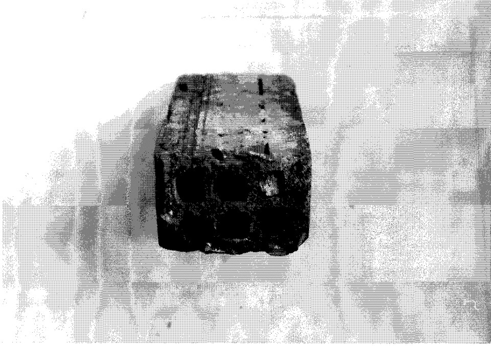
Resim 3.162 Sultanahmet Cezaevi, yığma taşıyıcılarda kullanılan delikli tuğla (22-22.5 x 10.5-11 x 7 cm.)
