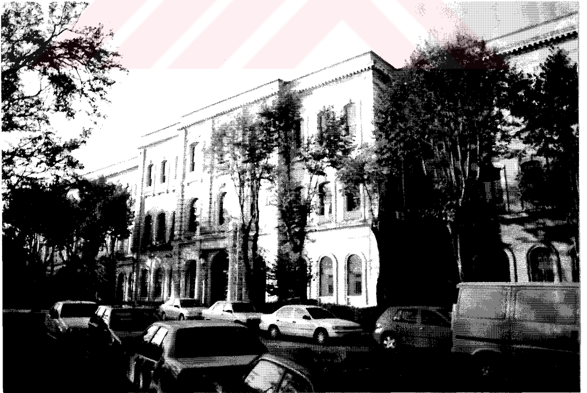
Resim 3.30 Harbiye Nezareti Binası (İstanbul Üniversitesi Rektörlük Binası)
