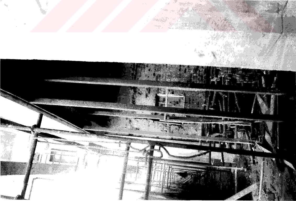
Resim 3.97 Akaretler, yağma kâğır taşıyıcının metal strüktür ile desteklenmesi
