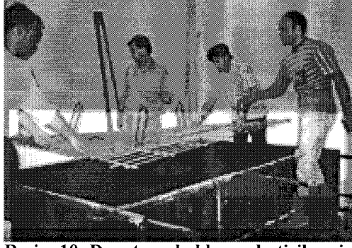
Resim 10: Donatının kalıba yerleştirilmesi
