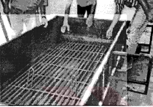
Resim 11: Kalıp montajı
