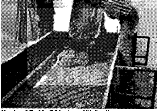
Resim 17: Hafif beton dökümü
