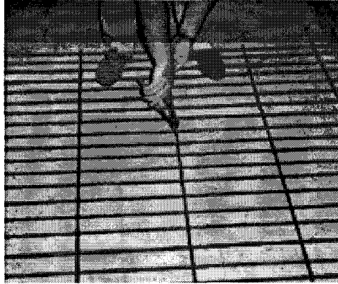
Resim 8: Plak donatısı montajı
