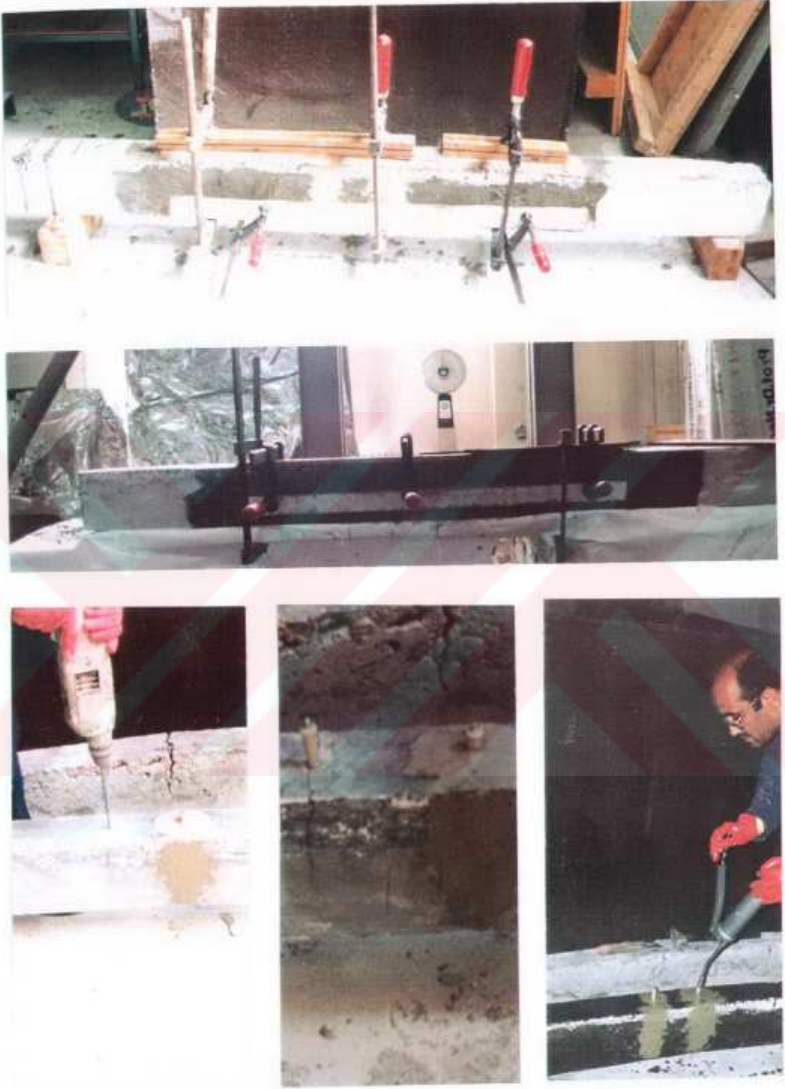
Şekil 5.14 Çatlakların epoksi ile onarımları ve kirişlerde güçlendirme uygulaması.
