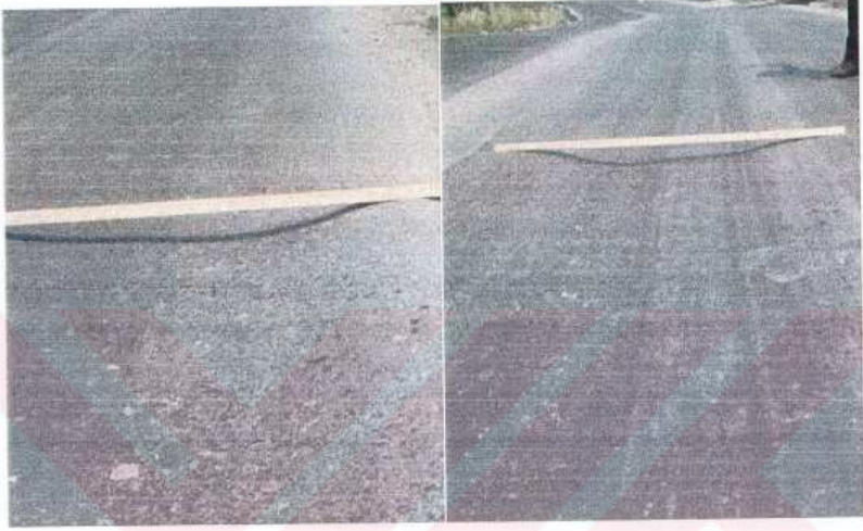
Şekil 3.2 Tekerlek izi oluşumlarına örnekler
