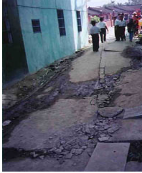
Şekil 4.9 Sıvılaşma etkisiyle zemin yüzünde meydana gelen bir çökme örneği ( www.earthscope.org/r1/uac01/uac01.html )
