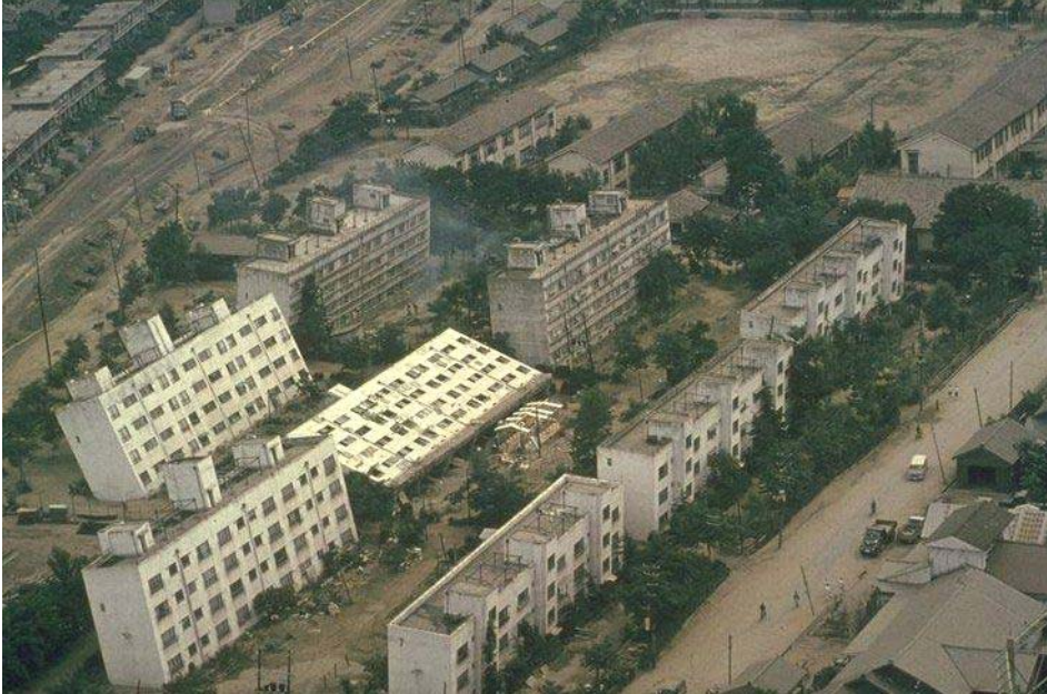
Şekil 4.10 Sıvılaşma nedeniyle oluşan taşıma gücü kaybının sonuçlarına bir örnek (USGS)
