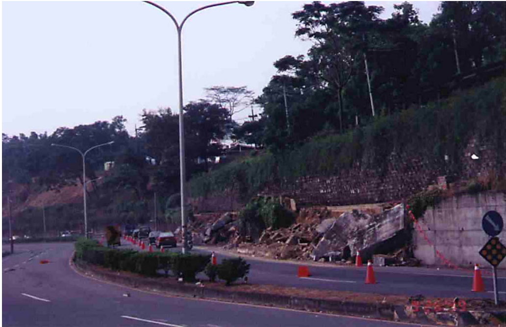
Şekil 4.12 Yıkılmış bir istinat duvarı örneği ( www.earthscape.org/r1/uac01/uac01.html )
