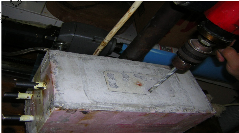
Şekil Ek 8 Betonarme Numunelerden Toz Çıkarılması
