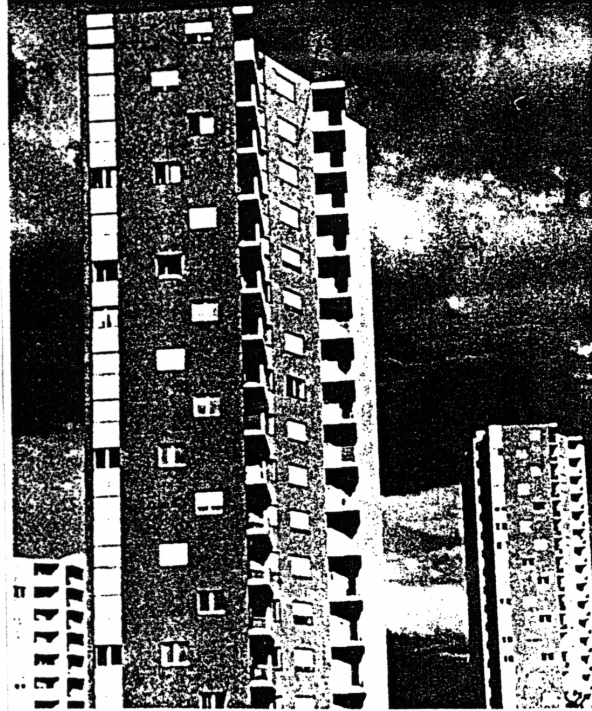
Őekil 2.18 İsvire'nin Biel Őehrinde 1951 yılında dıŐ duvarları 380 mm ve i duvarları 150mm geniŐlikte tuęladan yapılmıŐ 16 katlı yıęma bina (Drysdale vd., 1994).
