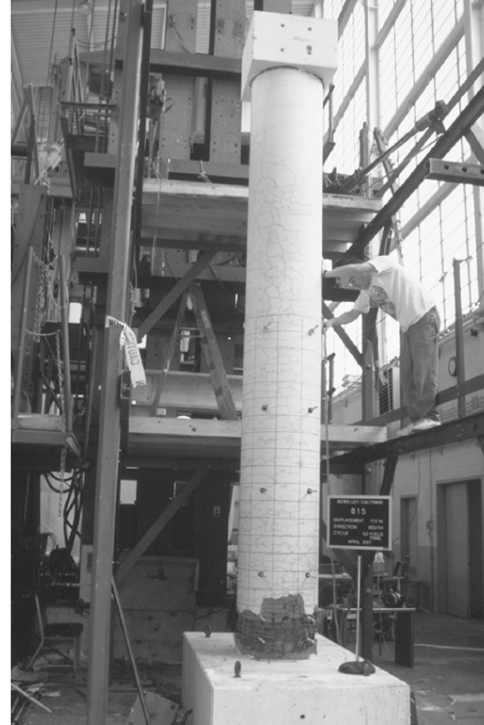
Şekil 4.19 Köprü ayağının göçme öncesi hasar durumu (Lehman ve Moehle, 2000)
