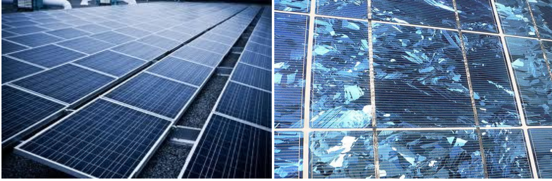
Şekil 4.10 Tek kristal ve Polikristal Silisyum kullanılarak hazırlanan Fotovoltaik Paneller
