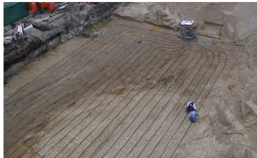
Şekil 5. 2 Toprak kaynaklı ısı pompası
