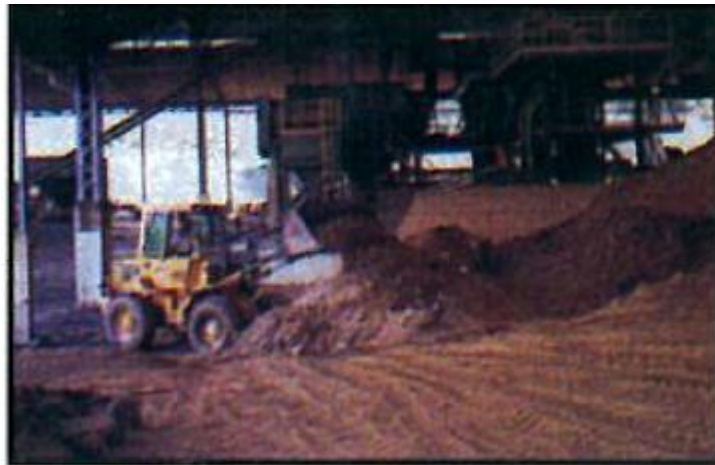
Şekil 2.4 Kil ocağından getirilen kilin, fabrikanın hammadde bölümünde hazırlanması [1]
