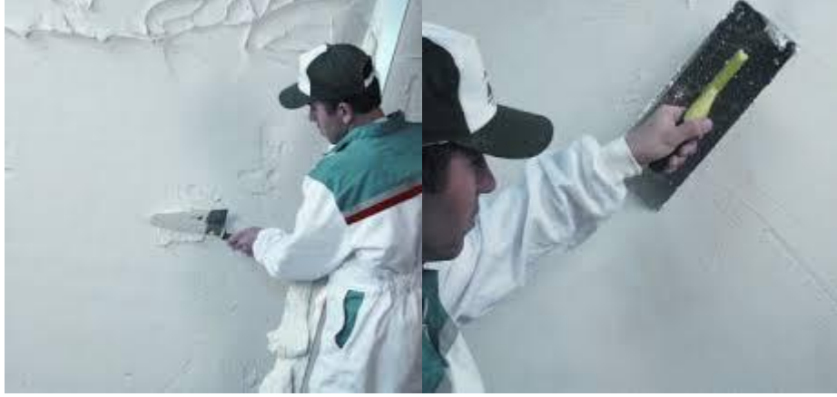
Şekil 7.6 Sıva uygulama görüntüsü
