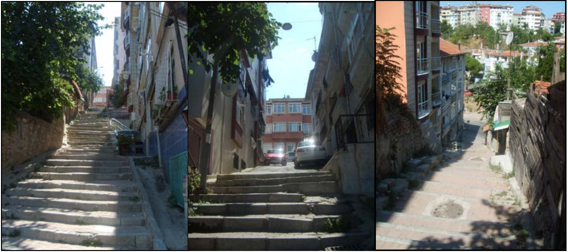
Resim 5.8 Çınarlı Tekke Sokak (53), Üsküdar (2009); ana cadde (Çavuşdere Caddesi) ile üst kottaki ara sokak arasında bağlayıcılık ve yapılarla giriş; yatay düzlemde merdiven+yol birlikteliği.
