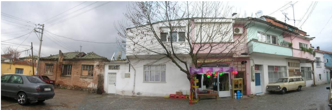
Şekil 4.13 Yanık Konak Meydanı kuzey-batı cephesi [yazarın kendi arşivi]
