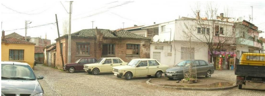
Şekil 4.16 Yanık Konak Meydanı batı ve kuzey-batı cephesi [yazarın kendi arşivi]
