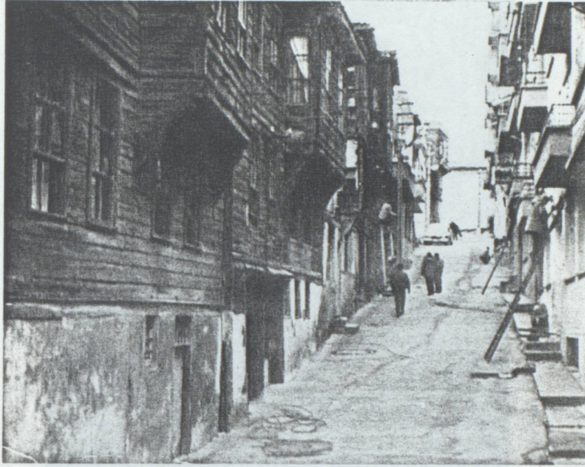
Şekil:30. Atatürk Caddesi'nin hemen arkasındaki sokaktan görünüş. Geleneksel mimarinin yoğun olduğu bu küçük ada da verilen yapı nizamı Blok-6 kat.
