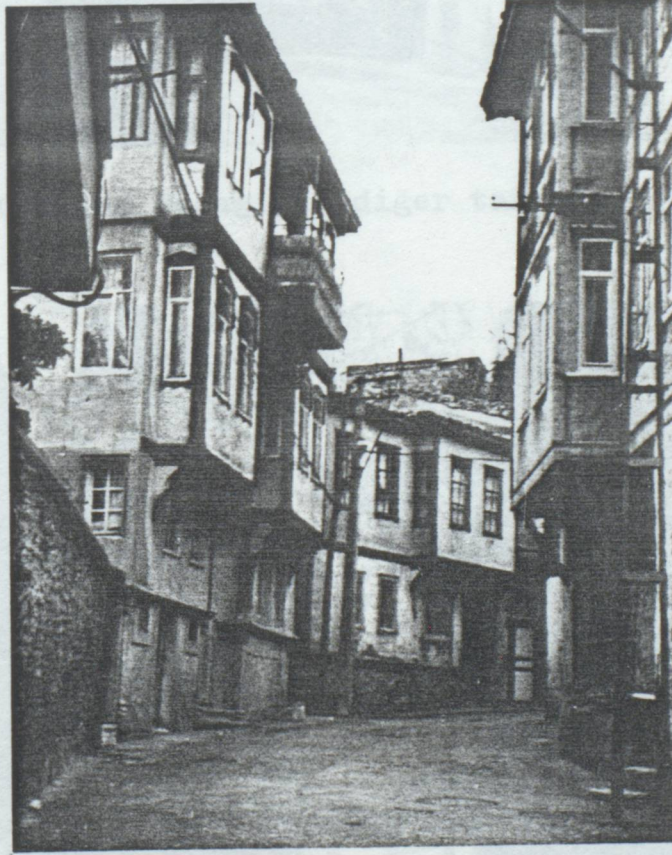
Şekil:39. Kefeve mahallesi, Kuruçeşme sokakta kısmi koruma altına alınan bir doku. Bu dokunun hemen yanında imar planı ile verilen bitişik 4 ve 5 kat yapılaşma, daha önceki örneklerde de gördüğümüz gibi hiç bir yarar sağlamayacağı gibi farklı yapılaşma biçimi ortaya çıkaracaktır. Öyle ise bu tarihi evlere sahip olanların günahı ne?
