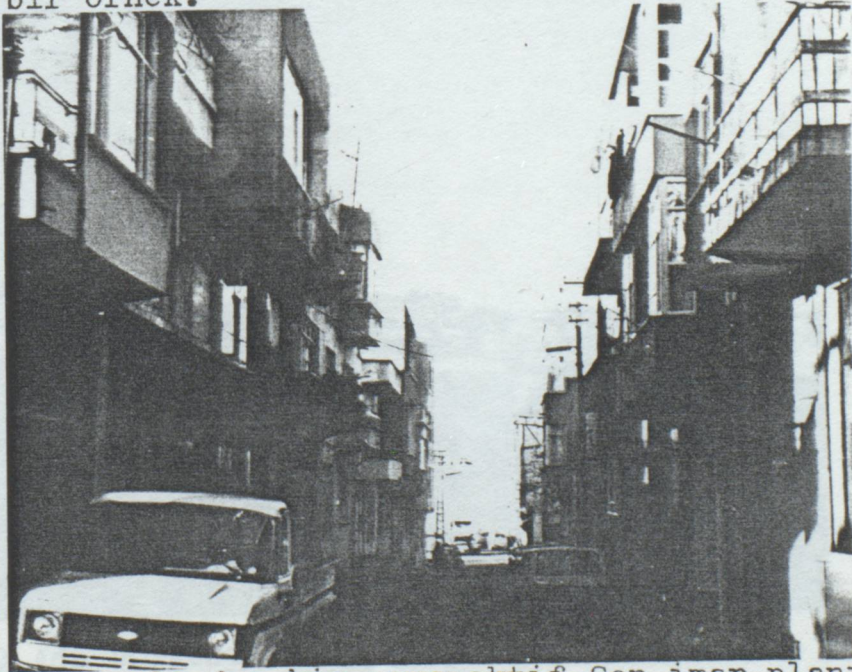
Şekil:67 Aynı alandan bir perspektif. Son imar planı ile getirilen yapılaşma bitişik 4 ve 6 kat.
