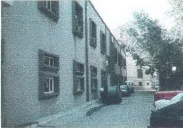
Resim 4.32 Tekel binasının ön bahçesinden bir görünüş (F.4)
