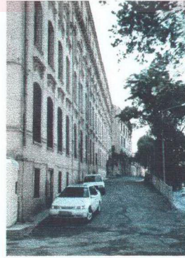
Resim 4.33 Tarihi Tekel binasının ön cephe görüntüsü (F.6)
