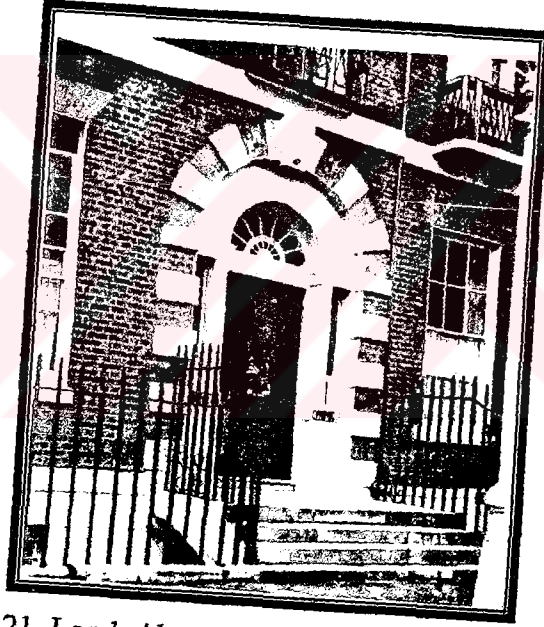
Resim 2.21 Londra'da rengin yapı yüzeylerinde kullanımı. Siyah renkli duvarların oluşturduğu zemin üzerindeki taş detaylar, silmeler ve çerçeveler açık renge boyanmıştır. ( Rasmussen, 1994: 139 )
