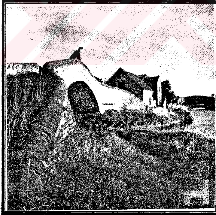
Resim 2.2 Yumuşak biçime sahip bir köprü örneği. 19. yüzyılın başında İngiltere'de inşa edilen büyük köprü. ( Rasmussen, 1994:21 )
