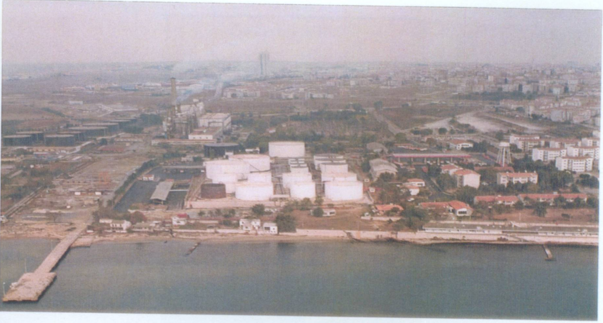
“Şekil 6.11” Kıy gerisi dolum tesisi.
