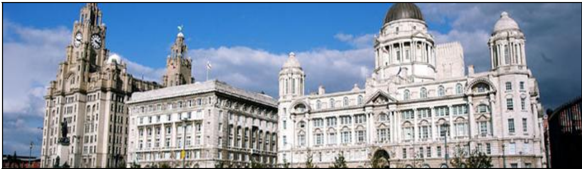
Resim 3.5 İskele Önü yenileme projesi kapsamında bulunan ve kent için önem taşıyan tarihi yapılar
