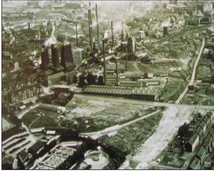
Resim 4.1 Oldukça yoğun sanayileşmenin yaşandığı Emscher Bölgesi'nde yer alan bir sanayi tesisi ve çevresi
