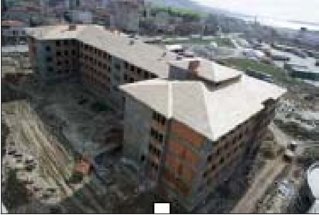
Resim 5.19 Bezirganbahçe Toplukonut alanında inşa edilmekte olan ilköğretim binası
