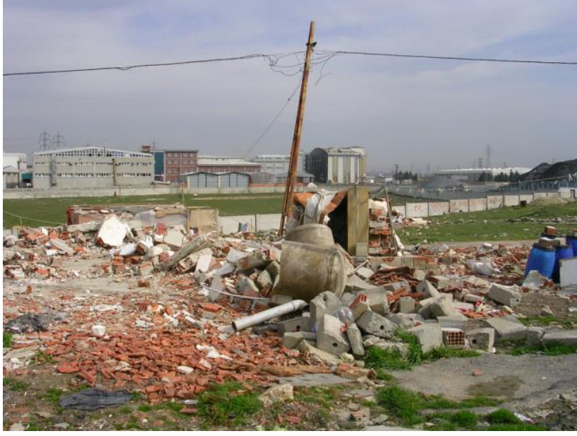
Şekil 5.22. Ayazma Bölgesi Yıkım Alanında Eski Kiracıların Yaşam Alanı [17]
