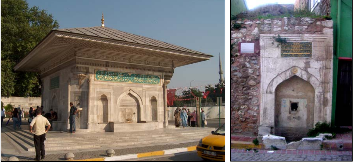
Şekil 3.23 Birden fazla yüzlü serbest konumlanmış çeşme (3.Ahmet Çeşmesi – Üsküdar) ve tek yüzlü duvarla bütünleşik çeşme (Küçük Ayasofya)
