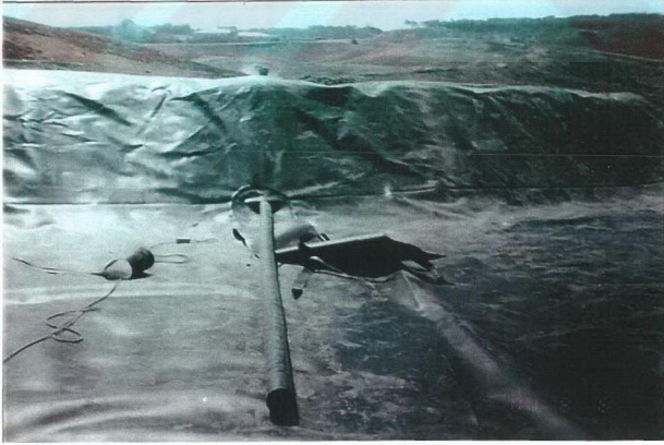
Şekil Ek 1.4 Sızıntı suyu drenaj sistemi
