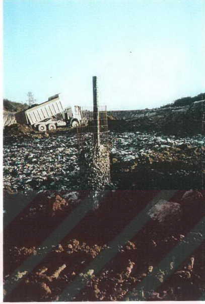
Şekil Ek 1.5 Gaz bacasının teşkili
