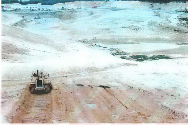
Şekil Ek 1.1 Test hücrelerinde kazı çalışmaları
