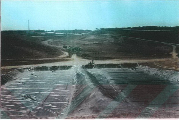
Şekil Ek 1.3 Test hücrelerinin tabanının geomembranla kaplanması
