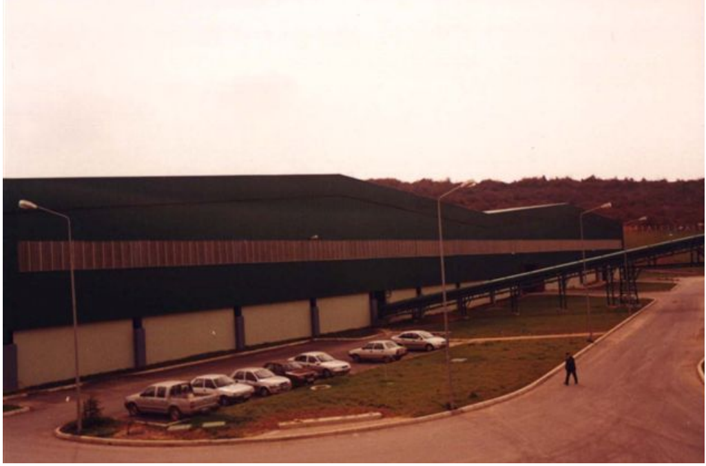
Şekil Ek 2.1 İstanbul Katı Atık ve Geri Kazanım Tesisi genel görünümü
