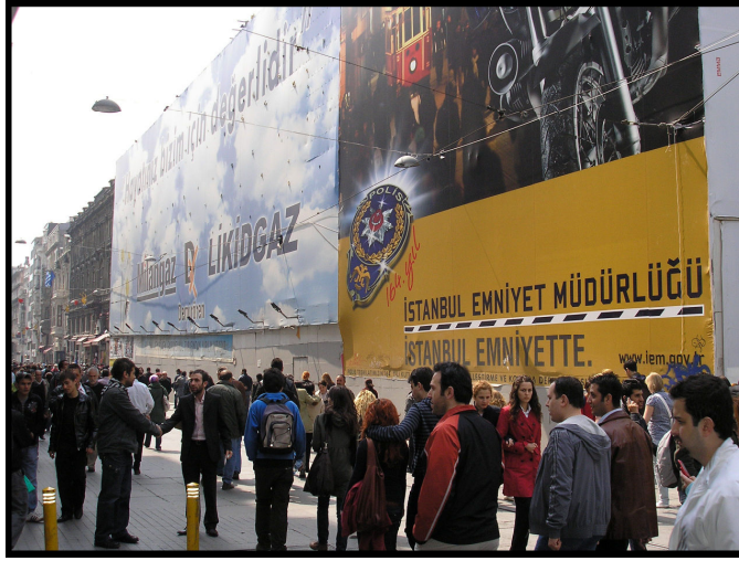
Şekil 5.4 İstiklal Caddesi üzerinde etrafı kapatılmış bir inşaat çalışması
