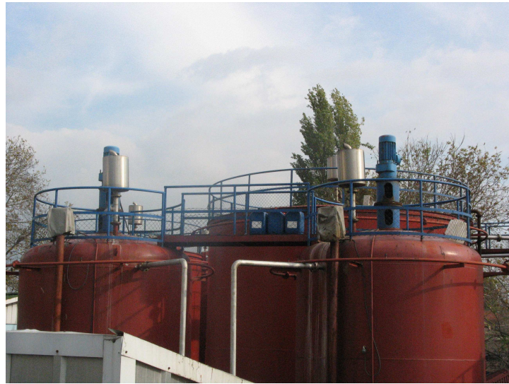
Şekil 4.28 Yangın müdahale sistemi ekipmanları
