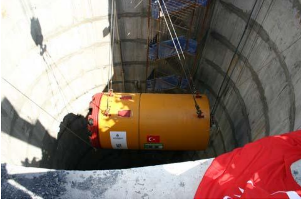
Şekil 6.5 Kazıyı yapacak TBM'in (Tunnel Boring Machine) şafttan indirilmesi
