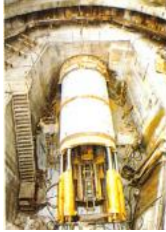
Şekil 4.8 Eminönü - Unkapanı arası mikrotünel imalatı çalışmalarına ait fotoğraf
