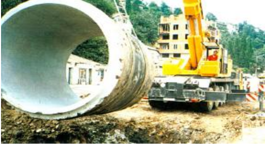
Şekil 4.6 Kâğıthane sağ sahil kolektörü çalışmalarına ait fotoğraf
