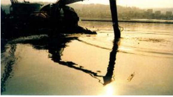
Şekil 4.17 Mavna üzerinde ekskavatörle Haliç dip çamuru çıkartılırken
