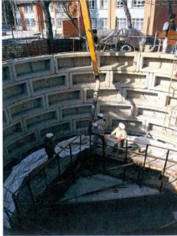
Şekil 4.7 Tünel shaft imalatı
