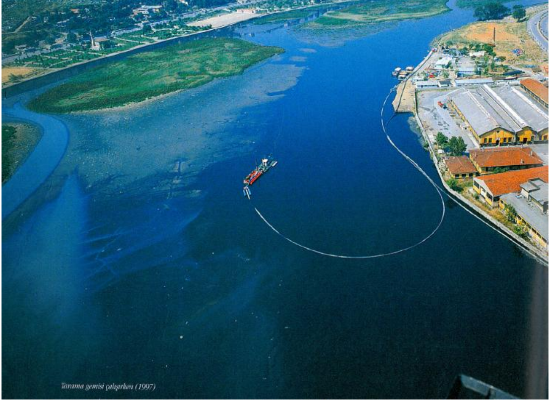
Şekil 4.16 Haliç dip çamuru temizlik çalışmalarına ait fotoğraf
