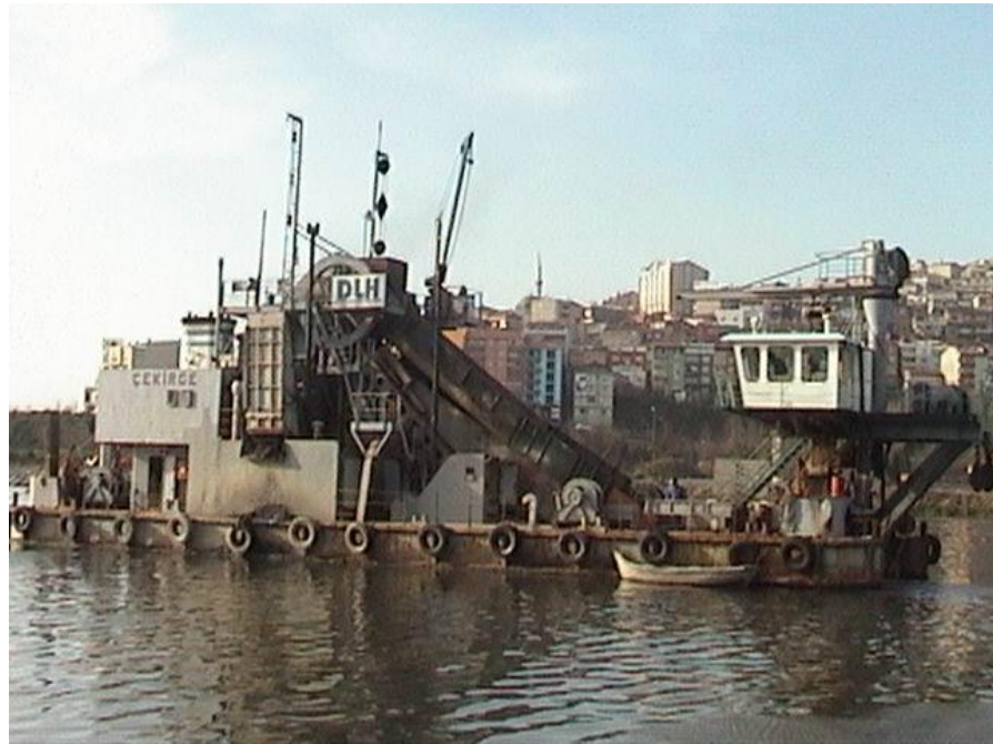
Şekil 6.1 Çıkarılan çamurun taşıyıcı dubaya yüklenmesi
