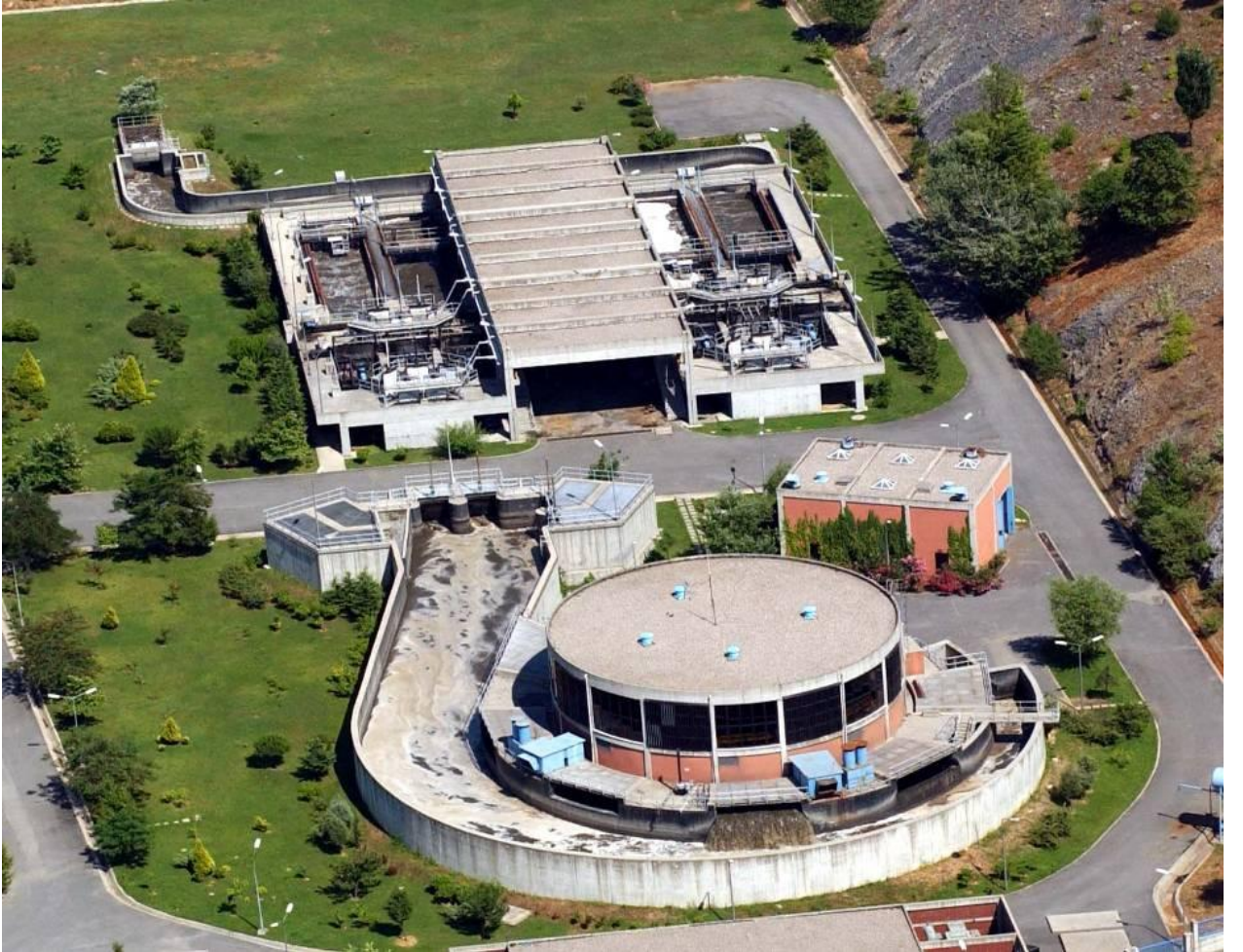
Şekil 4.12 Baltalimanı atıksu ön arıtma tesisi
