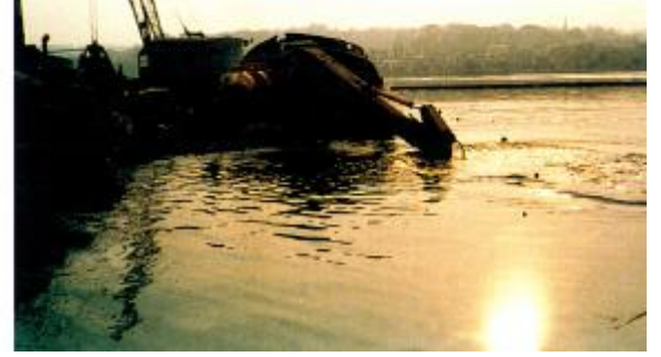
Şekil 4.17 Mavna üzerinde ekskavatörle Haliç dip çamuru çıkartılırken
