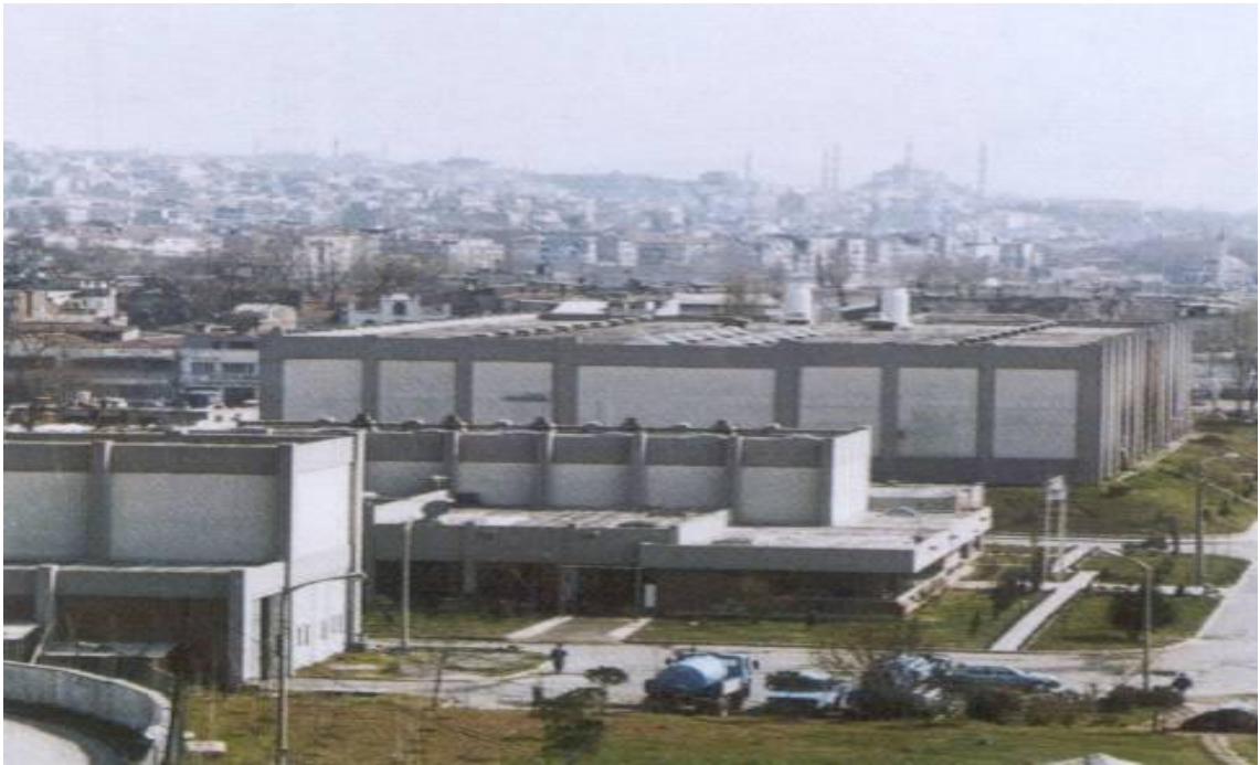
Şekil 4.9 Yenikapı atıksu ön arıtma tesisi
