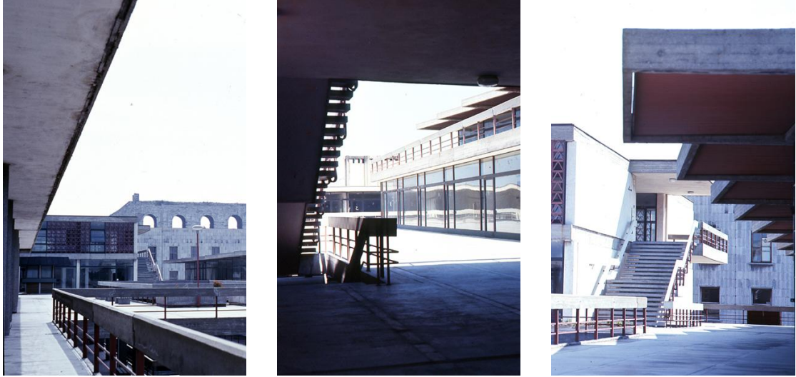
Şekil 12: İMÇ'nin iç mekanlarından fotoğraflar. 1968. Unkapanı.
