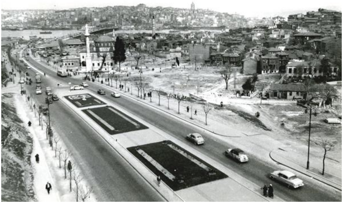
Şekil 9: Su kemerinden Haliç'e doğru uzanan arsasından fotoğraf. 1956-1957. Atatürk Bulvarı ve Manifaturacılar arsası(İMÇ). Unkapanı, İstanbul.
