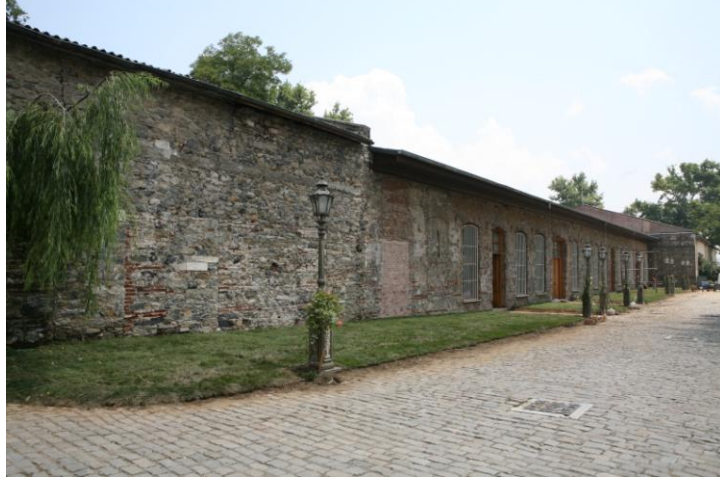
Şekil 26: Dolmabahçe Sarayı Batı Harem Matbahları Binası (Dış Görünüm)
