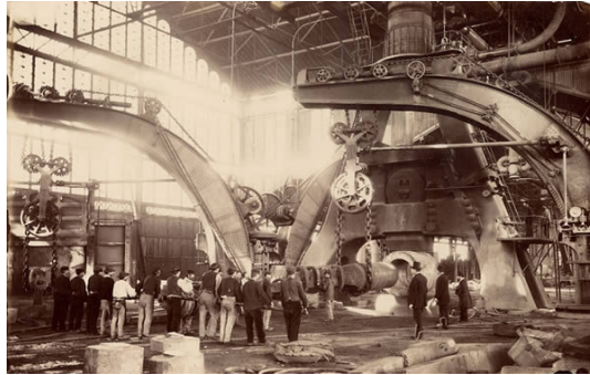
Şekil 19: Etablissements Schneider CIE, Le Creusot.
