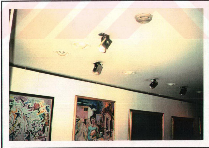
Resim 36 - Bölgesel aydınlatma için tavana gömme ve oynar başlıklı aydınlatma düzenekleri
