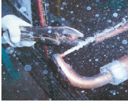
Şekil 28: İstenmeyen Su Çıkışı ve Oluşan Paslanma
