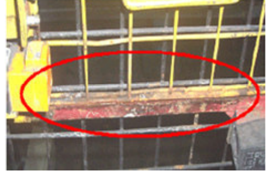
Şekil 28: İstenmeyen Su Çıkışı ve Oluşan Paslanma
