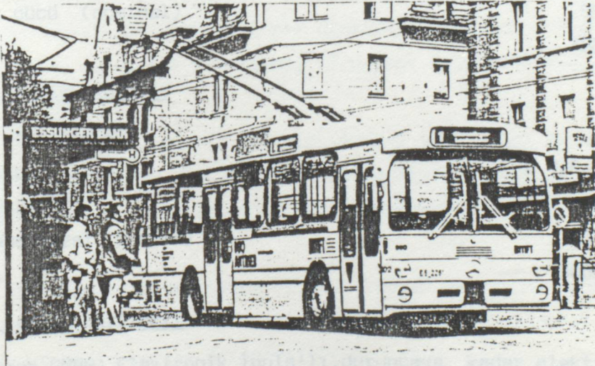
MAN- Standart-Elektrobus SL-E H 455 V 180 Kurşun Akümülatörlü Elektrikli Taşıt.
