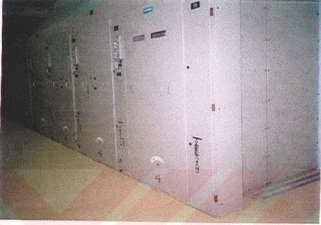
Şekil 6.7 Zemin kat - 34,5 kV O.G. holü
