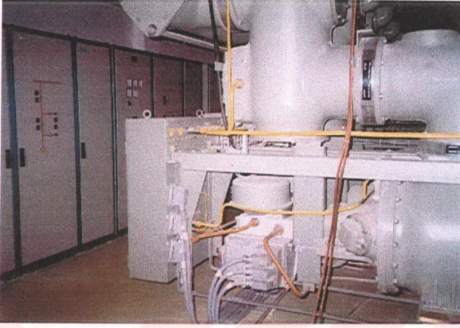
Şekil 6.9 Zemin kat - GIS odası
