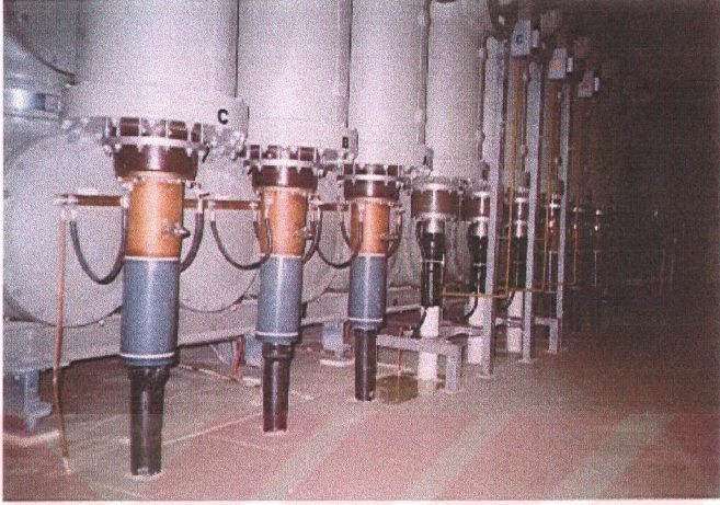
Şekil 6.11 Zemin kat - GIS odası
