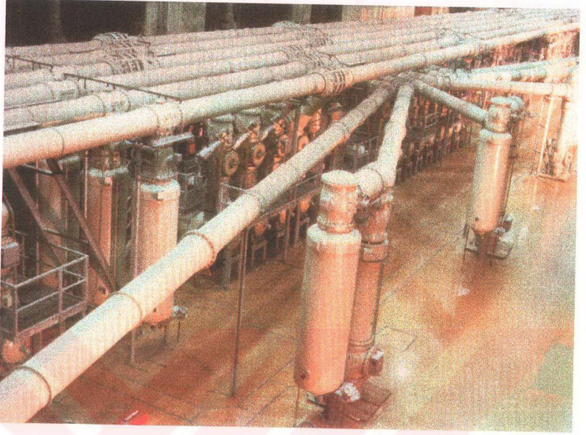
Şekil 5.12 BBC Brown Boveri firmasının yaptığı 550 kV GIS
