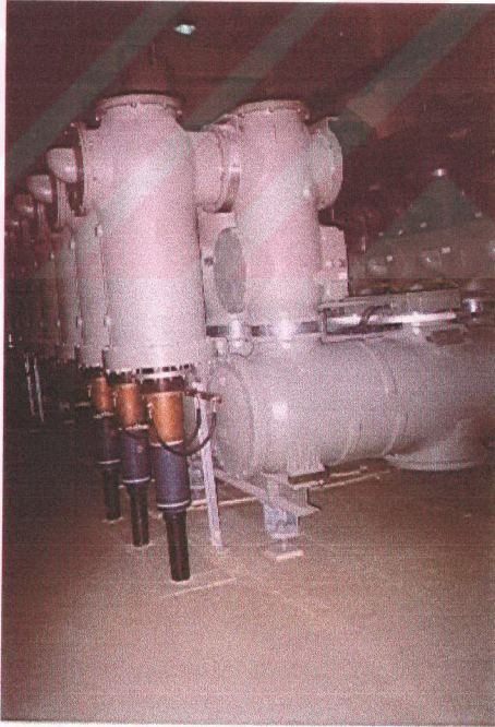
Şekil 6.10 Zemin kat - GIS odası
