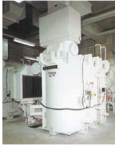
Şekil 7.20 Gaz zorlamalı, hava zorlamalı soğutma tipli SF6 gaz izoleli transformatör (Toshiba)
