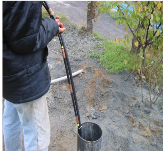
Şekil 2.34 KMO kaplı Ti anotların yerleştirilmesi
