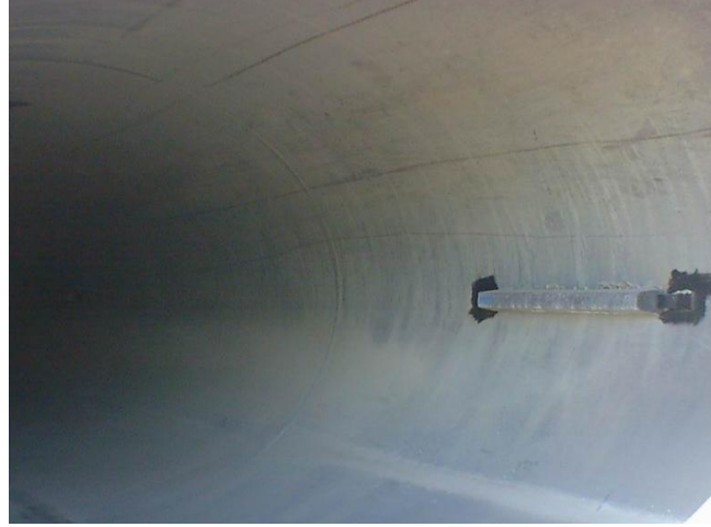
Şekil 2.40 Boru iç yüzeyine Mg anotla uygulanan katodik koruma
