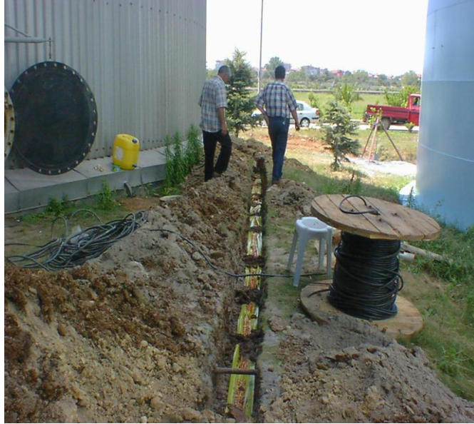
Şekil 2.42 Primer ve sekonder tankların dış taban ve beton donatılarının korunması
