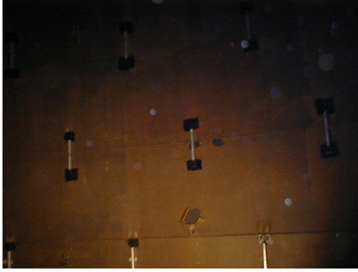
Şekil 2.41 Primer tank iç yüzeyinin Zn anotla korunması
