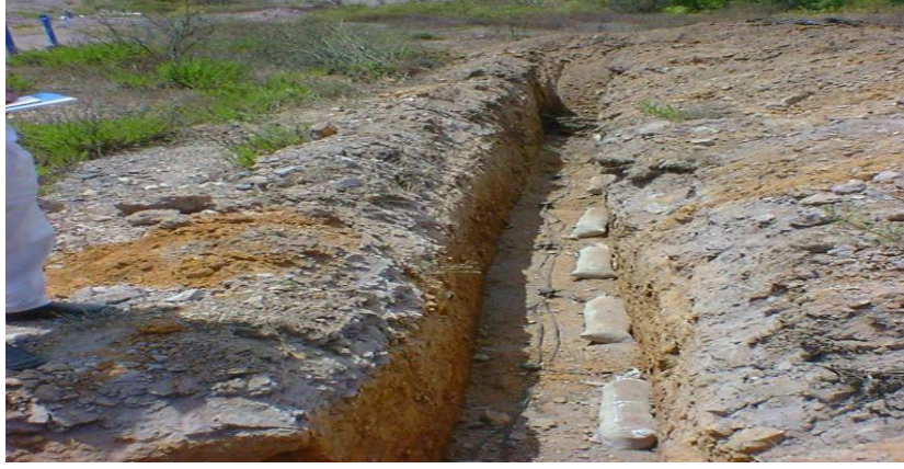
Şekil 2.38 Galvanik usulde Mg Anotların dōşenmesi
