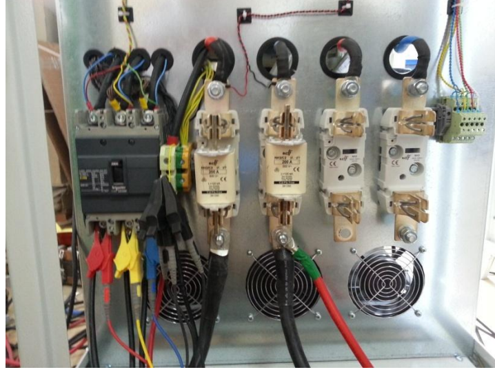
Şekil 6. 5 Doğrultucu Giriş-Çıkış Bağlantı Noktaları
