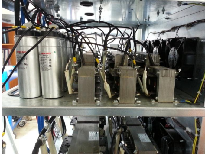
Şekil 6. 9 Besleme Hattına Paralel Bağlı Filtre Gruplarından Biri
