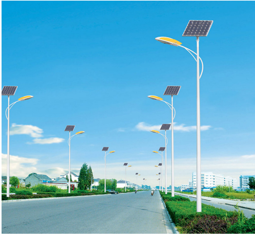
Şekil 1.4 Sokak aydınlatmasında güneş paneli kullanımı.
