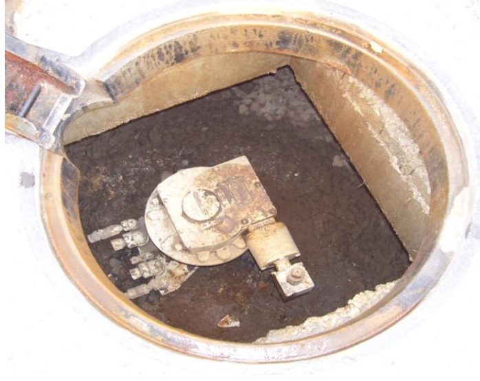
Şekil 3. 12 Gömülü tip doğal gaz vana odası modeli
