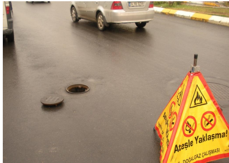
Şekil 6. 5 Blow- Down kapakları
