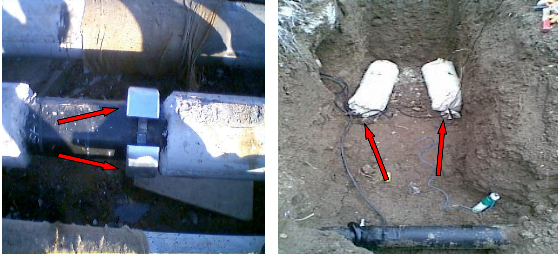
Şekil 5. 29 Kurban anot ile boru hattının katodik koruması [39]
