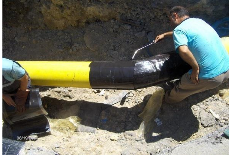
Şekil 5. 24 Doğalgaz çelik borularının kaynak yerlerine sıcak sargı uygulaması
