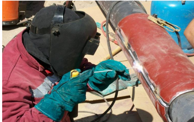
Şekil 7. 5 Korozyon hasarlı bölgeye çelik kılıf kaynatılması
