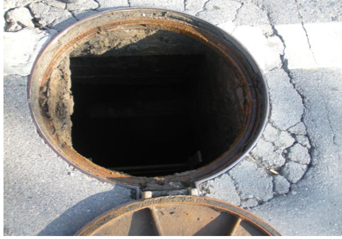
Şekil 6. 4 Çevre betonu Kırılmış menhol kapağı
