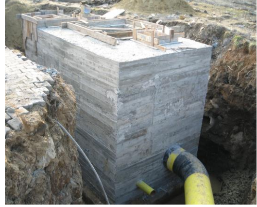
Şekil 3.7 Doğal gaz vana odası inşası
