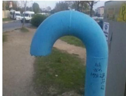
Şekil 7. 24 Yağmur suyu girişini önleyen havalandırma bacası
