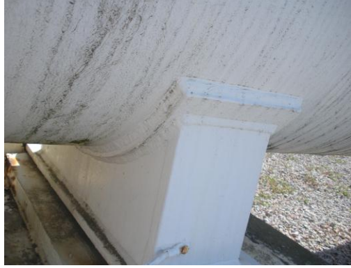
Şekil 7. 27 Doğal gaz vanasında boruya kaynaklı destek uygulaması
