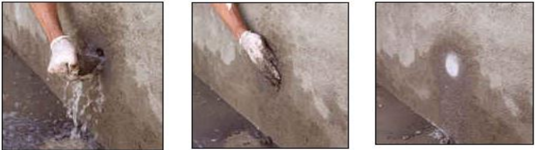
Şekil 7. 26 Su kaçaklarına karşı uygulanan su tıkaçı
