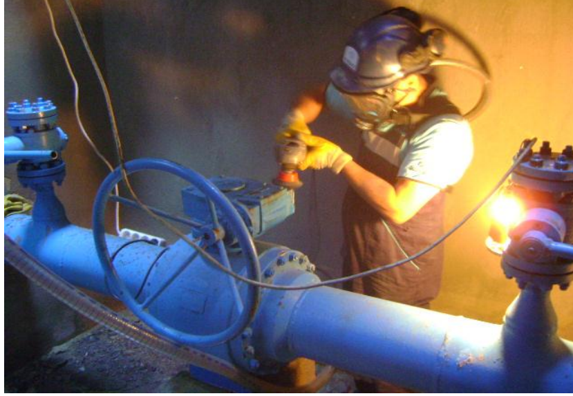
Şekil 5. 26 Vana odasında boyama öncesi yapılan temizlik çalışmaları
