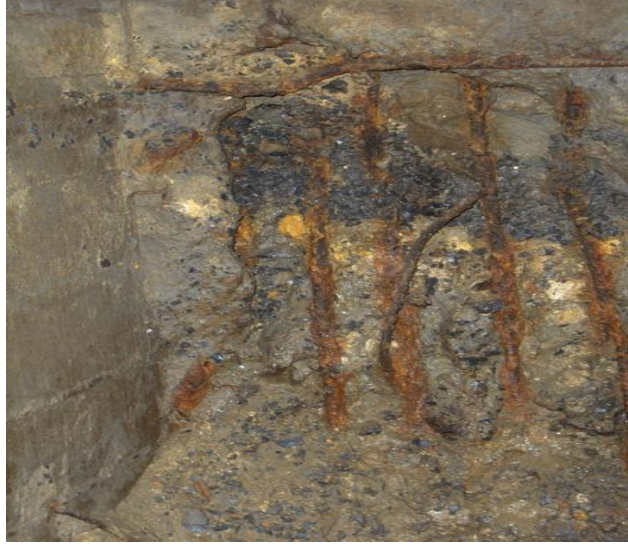
Şekil 6. 10 Paslanmış vana odası demir donatısı
