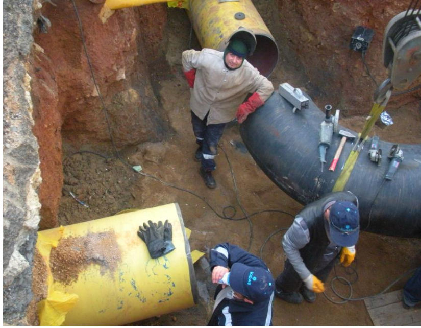
Şekil 7. 14 Gazsızlaştırma işlemi sonrası yeni boru hattının kaynak işlemi
