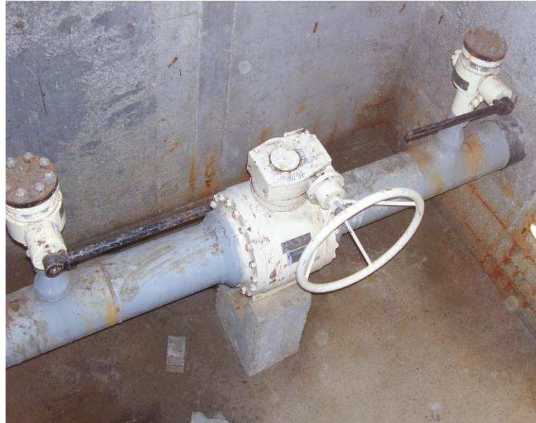
Şekil 3. 10 Doğal gaz vana odası iç görünüşü
