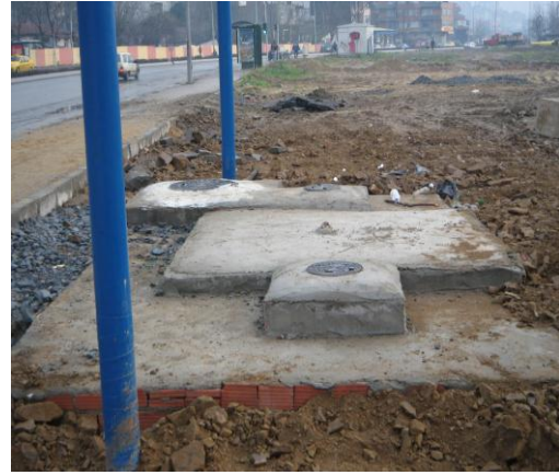
Şekil 3.9 Doğal gaz vana odası inşası
