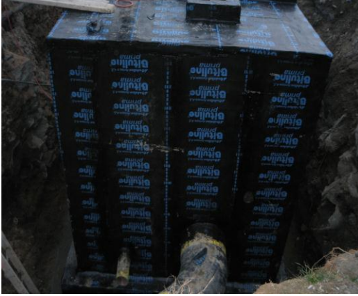
Şekil 3.8 Doğal gaz vana odası inşası
