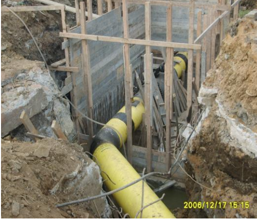
Şekil 3.6 Doğal gaz vana odası inşası
