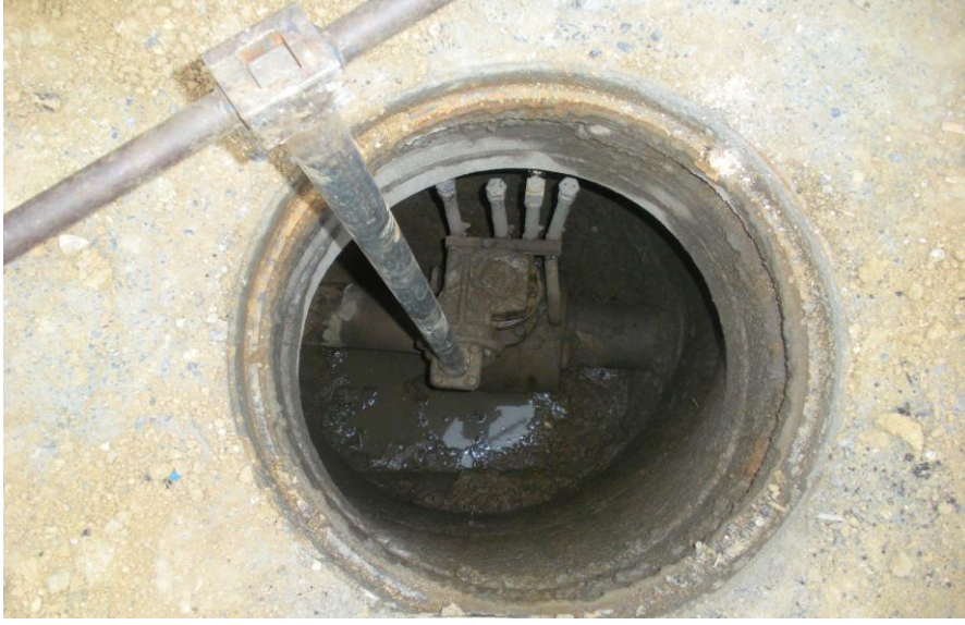
Őekil 3. 14 Odacık tip doęal gaz vana yerleřtirme modeli
