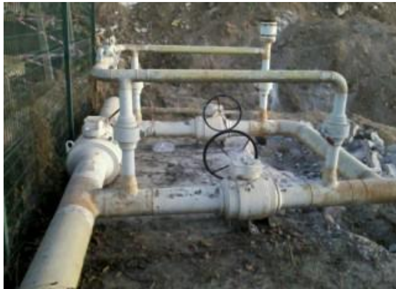
Şekil 3. 13 Sahra tip doğal gaz vanası yerleştirme modeli
