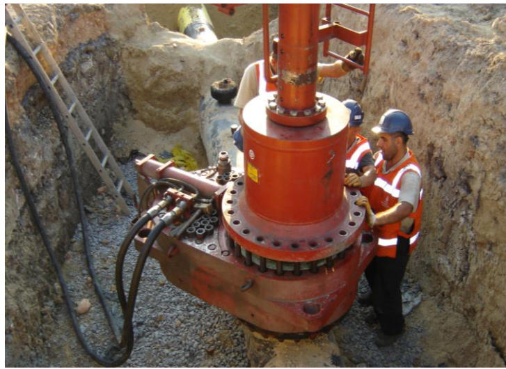
Şekil 7. 31 Doğal gaz boru hattının deplasesi için yapılan stopple operasyonu
