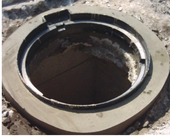
Şekil 7. 25 Menhol kapağı çevresinde çimento esaslı harç uygulaması
