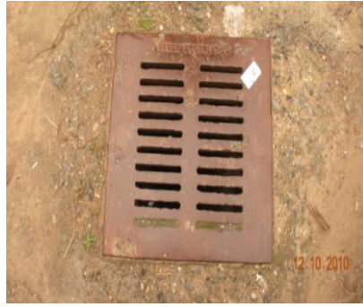
Şekil 6. 6 Havalandırma amaçlı kullanılan ızgaralar
