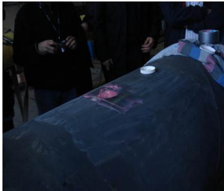
Şekil 7. 18 (a) Hasara dolgu uygulanması (b) dolgu sonrası epoksi reçine uygulanması
