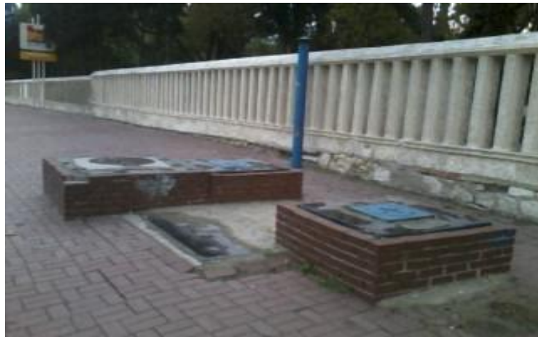
Şekil 7. 22 Kaldırımda menhol ve blow-down kapaklarının yerden yüksek olduğu vana odası uygulaması.
