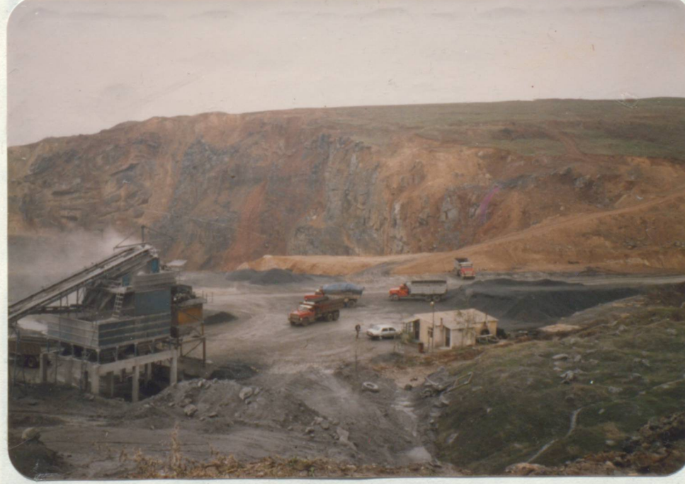
Resim 2.1. Cebeci Siyah Kalker Ocak İşletmesi
