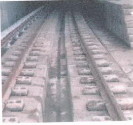
Şekil 2.26 LVT TT içine gömülü travers mesnetli rijit üstyapı sistemi (Erkul, 2002).
