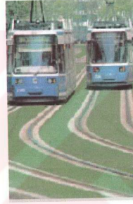
Şekil 2.29 Rasengleis monolitik rijit üstyapı sistemi (Erkul, 2002).
