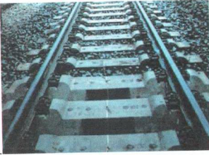
Şekil 2.28 GETRAC TT üzerine döşeli travers mesnetli rijit üstyapı sistemi (Erkul, 2002).
