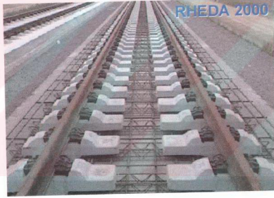
Şekil 2.24 Rheda 2000 taşıma tabakası (TT) içine gömülü travers mesnetli rijit üstyapı (Esveld, 2003).
