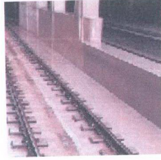
Şekil 2.26 LVT TT içine gömülü travers mesnetli rijit üstyapı sistemi (Erkul, 2002).
