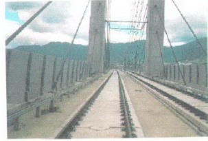
Şekil 2.30 Shinkansen prefabrik üstyapı sistemi (Erkul, 2002).
